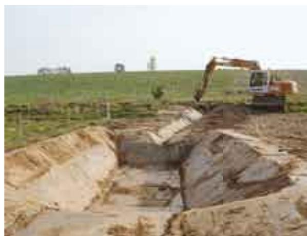
Photo n° 16 : bassin de décantation (Source : GTM-T)
