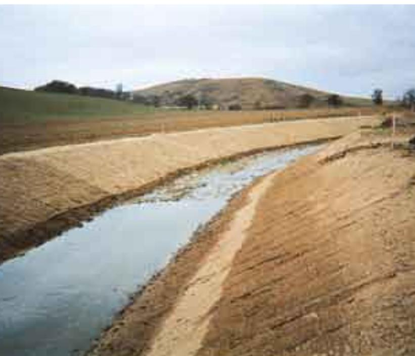
Photo n° 19 : protection des berges par toile de jute (Source : GTM-T)
