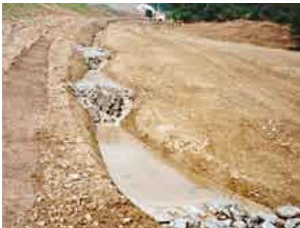
Photo 17 : dispositifs de ralentissement des écoulements
