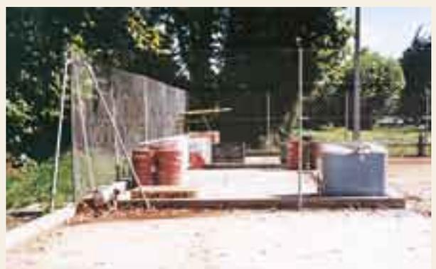
Photo 48 : : stockage sur rétention étanche et grillagée (Source : GTM Terrassement)
