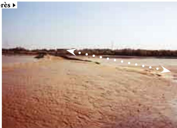
Photos 76, 77 : passage busé complètement détruit pendant une crue annuelle du cours d'eau (Source : E. Mazieres)
