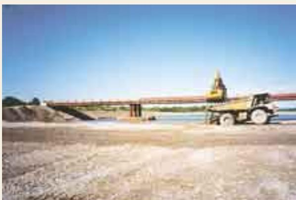
Photo 31 : pont provisoire 90 m de long (Source : GTM Terrassement)
