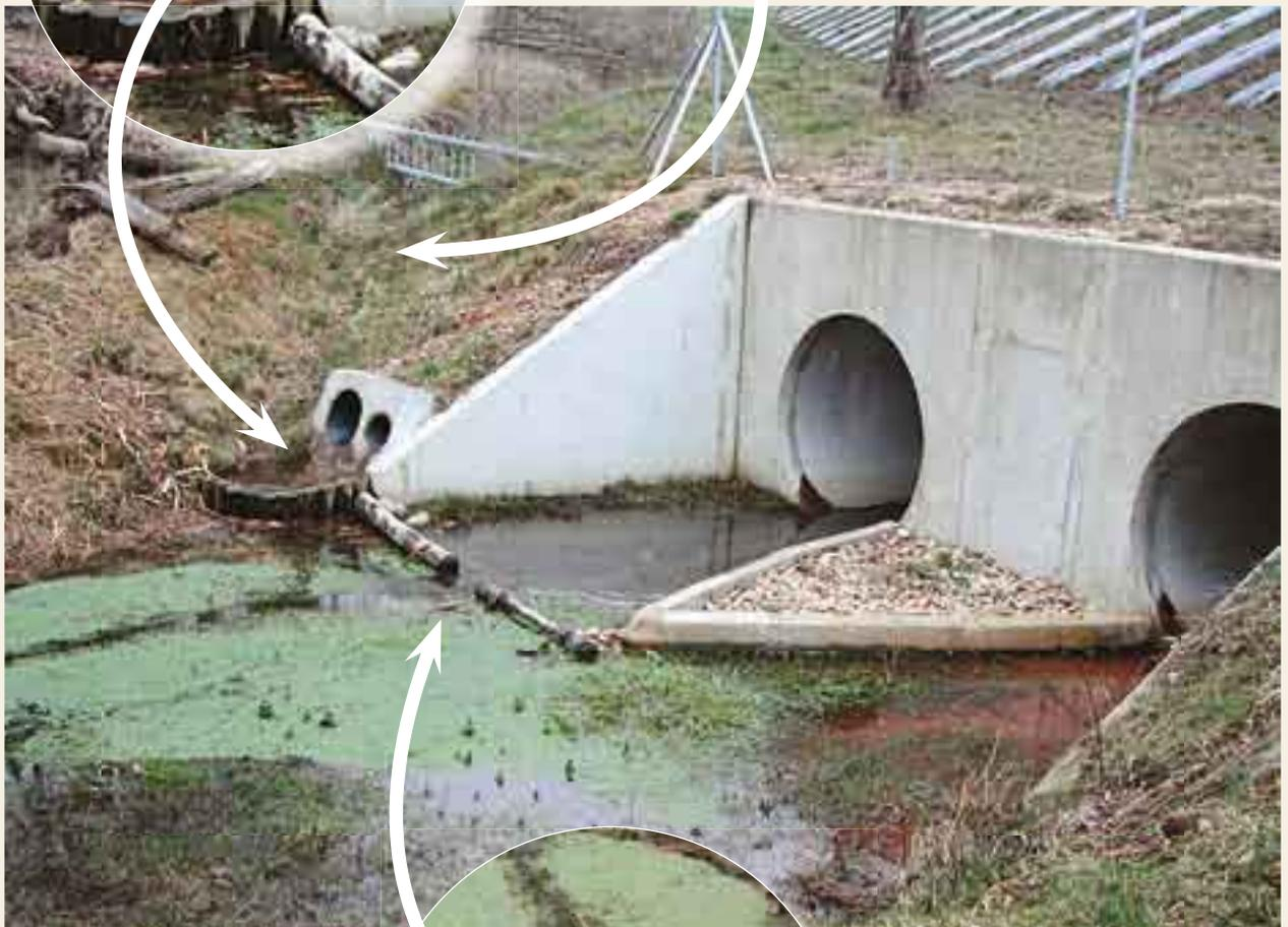
*Seuil en bois en sortie de bêche afin de créer une lame d'eau suffisante pour la circulation du poisson*
