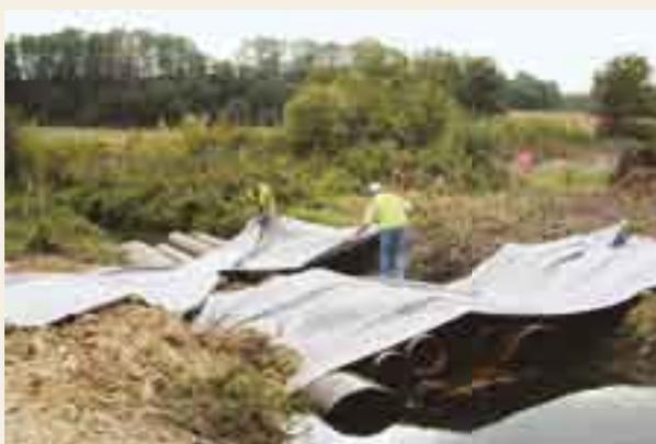
Photo 33 : busage provisoire avec géotextile anticontaminant (Source : GTM Terrassement)
