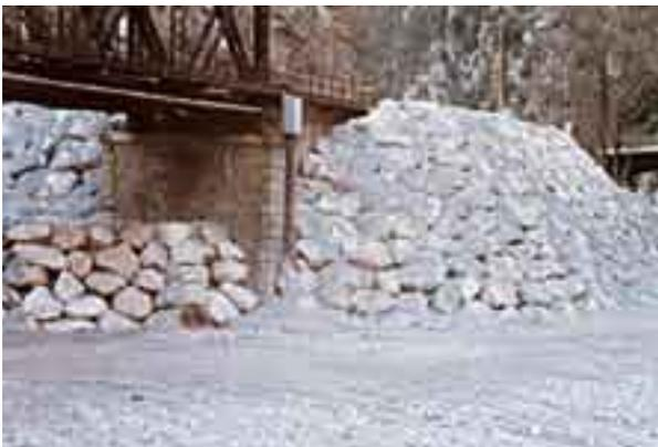
*Photo 59 : les enrochements sont saupoudrés de béton*
