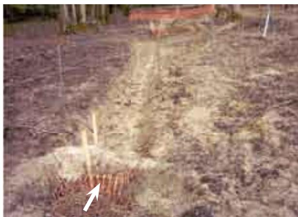
Photos 73, 74 : filtres à paille mal posés ; font uniquement obstacle à l'écoulement des eaux et en aucun cas office de filtres (Source : E. Mazieres)
