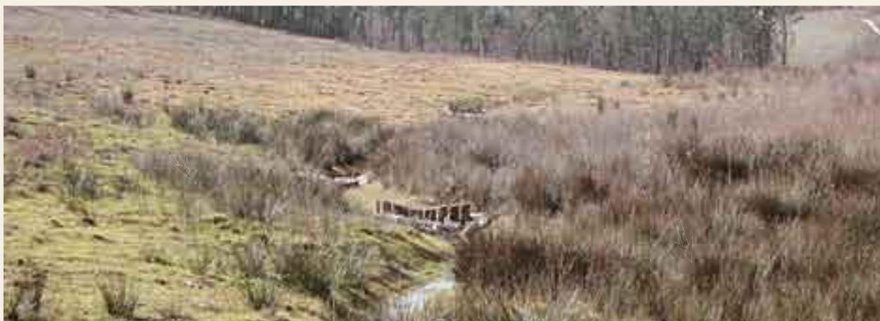
Photo 58 : création sur cette zone de modelé, d'un chenal avec seuil en bois et géonatte en coco tressée (Source : Ph. Thiévent)
