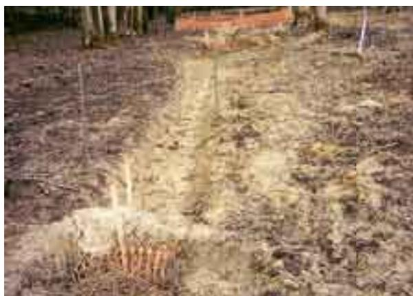
Photo n° 11 : filtre paille déchaussé (Source : GTM-T)
