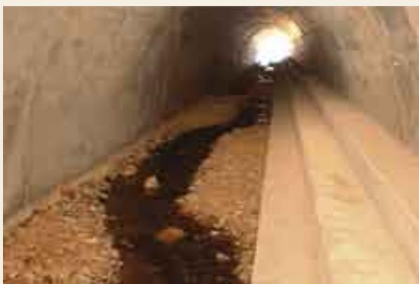
Photo 42 : passage à loutre dans ouvrage hydraulique (Source : GTM-T)
