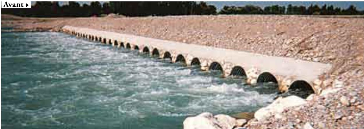
Photo 75 : passage busé provisoire - 30 buses de diamètre 1500 mm (Source : E. Mazieres)
