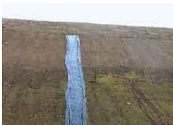
Photo n° 12 : descente d'eau provisoire (Source : GTM-T)
