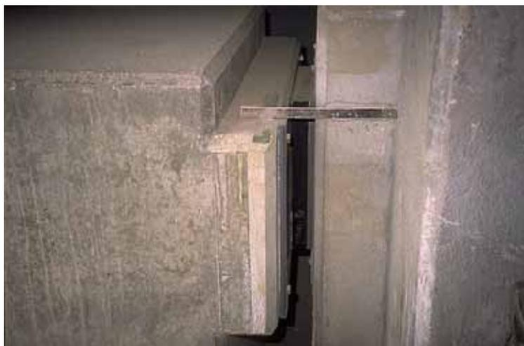
**Figure 2.5 :** exemple d'un réglet de suivi de déplacement (appareil d'appui vertical en butée antisismique) (photo Sétra)
