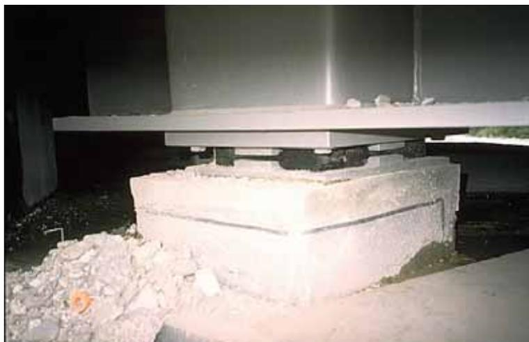
*Figure 2.8 : exemple d'un appareil d'appui à distorsion limitée ou bloquée (photo Sétra)*
