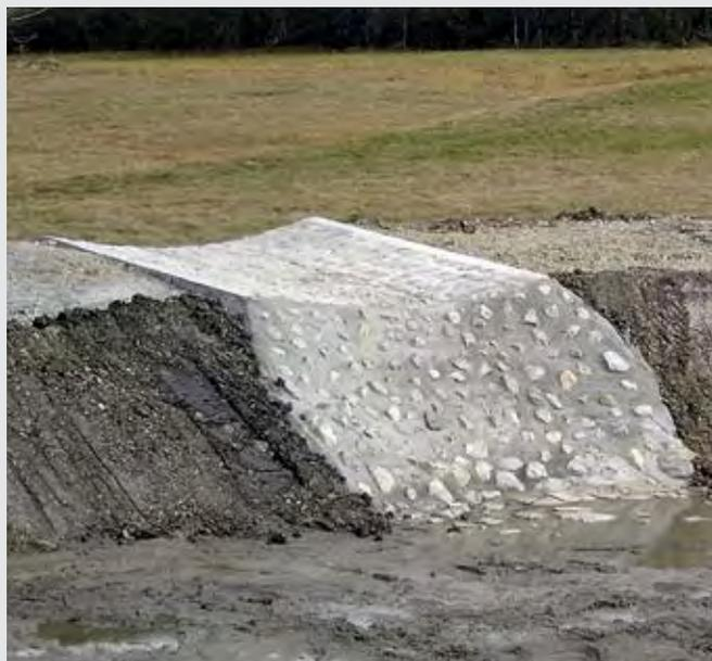
Photo n° 7 : A51, déversoir sur berge de bassin (en construction)
