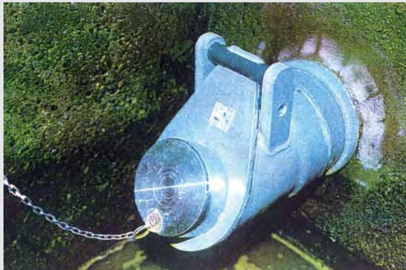
Photo n° 6 : clapet de sortie pour bassin en position fermée – Source : ASF
