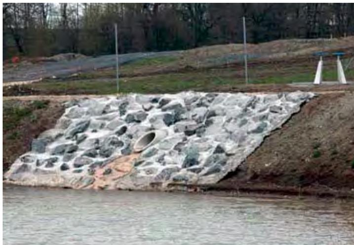
*Photos n° 2 et 3 : deux exemples d'ouvrages d'entrée au bassin pour éviter l'érosion des berges – Source : CETE de l'Est*
