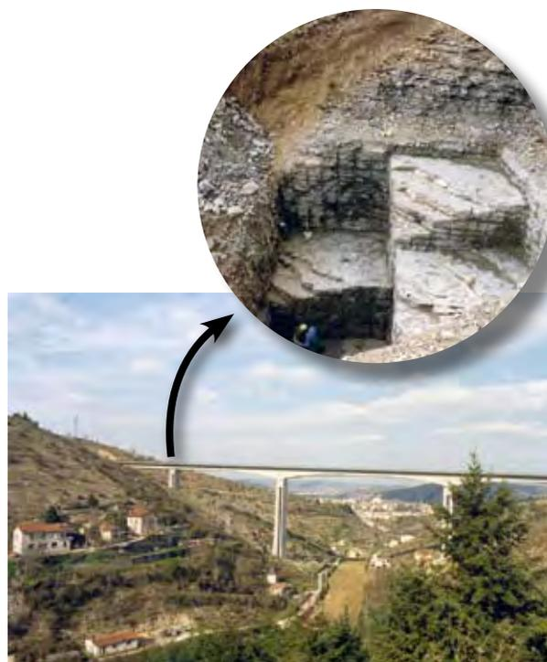
Figure 4.11 : fondation de la pile P2 du viaduc de Roquebilière (déviation RN20 à Cahors) - fouille à redans permettant d'adapter l'appui à la forte pente du toit des formations calcaires du Kimméridgien sous les éboulis – Source : EGIS
