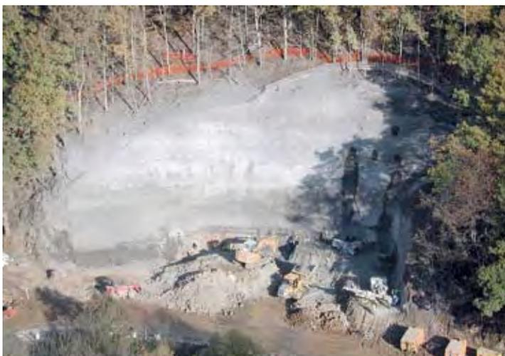
Figure 4.8 : soutènement provisoire par clouage pour construction d'une pile (viaduc de la Sioule) – Source : D. Criado (Sétra)
