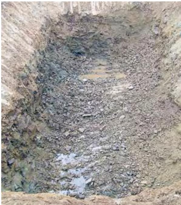
Figure 6.1 : terrassement d'une fouille pour un appui sur semelle. Un complément de nettoyage a été nécessaire avant réception de l'assise
