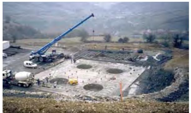
Figure 4.17 : fondation sur puits multiples de la pile P1 du viaduc du Milliau – Source : Sétra
