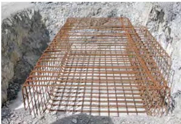
Figure 4.9 : fondation superficielle (tranchée couverte Agos Vidalos RN20) – Source : S&tr
