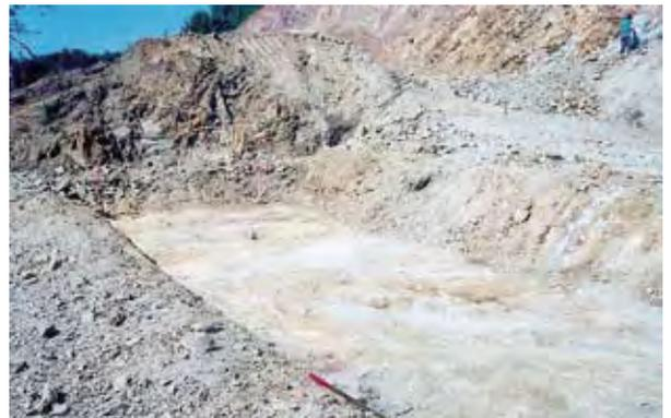
Figure 6.2 (a) et (b) : contournement de Brive-la-Gaillarde (Corrèze) - Vue générale du versant Ouest avec les fouilles des appuis C0 et P1 (a) et terrassement pour la semelle de l'appui C0 du viaduc de Cluzan (b)
