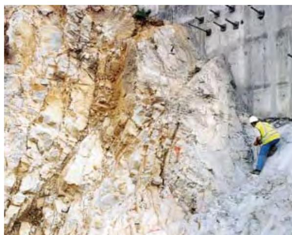
Figure 3.2 : affleurement de quartzite fracturée (viaduc de l'Ante)
