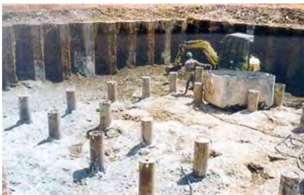
Massif de jet grouting en cours de recépage avec ses mini-piles
