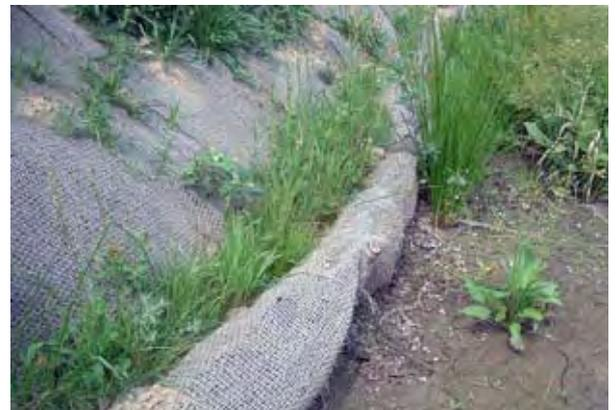
Illustration 55 : Phase chantier A 28 - exemple de mise en place de technique génie-végétal le long d'un cours d'eau : mise en place de fascines d'hélophites (jonc, carex...) et bouturages de saule sur le talus – Source : Sétra
