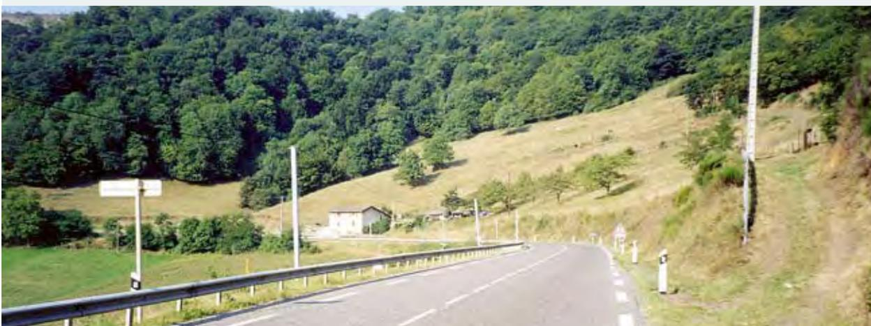
Illustration 78 : exemple virage lisible et visible [24]
