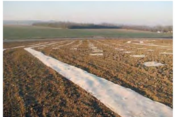
Illustration 54 : phase chantier LGV Est, à gauche plantations des talus de la LGV, à droite exemple de mise en place de technique de génie-végétal par paillage feutre jute/chanvre – Source : RFR
