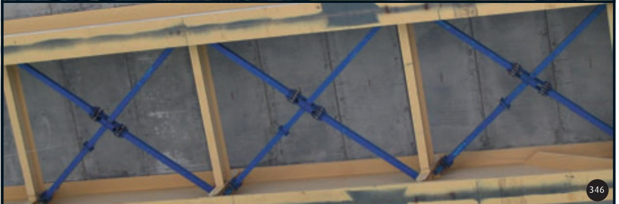
341 : Connecteurs en goujons. 342 : Connecteurs en goujons concentrés pour dalle en éléments préfabriqués de pleine largeur. 343 : Connecteurs en cornières. 344 : Contreventement en X par barres. 345 : Contreventement en X par cornières. 346 : Contreventement en X par tubes.
