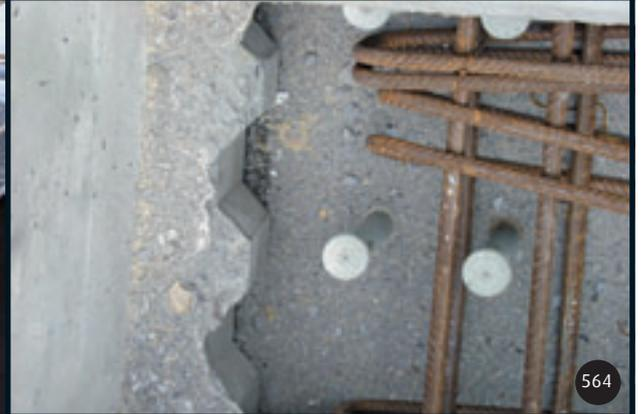
561 : Prédalles collaborantes incluant une partie du ferrailage supérieur de la dalle. 562 : Vérins de poussage de plots coulés en place à l'arrière d'une culée. 563 : Dalle en cours de poussage, avec tunnel de connexion. 564 : Détail d'une poche de connexion d'une dalle poussée montrant les clefs de cisaillement du tunnel de connexion.
