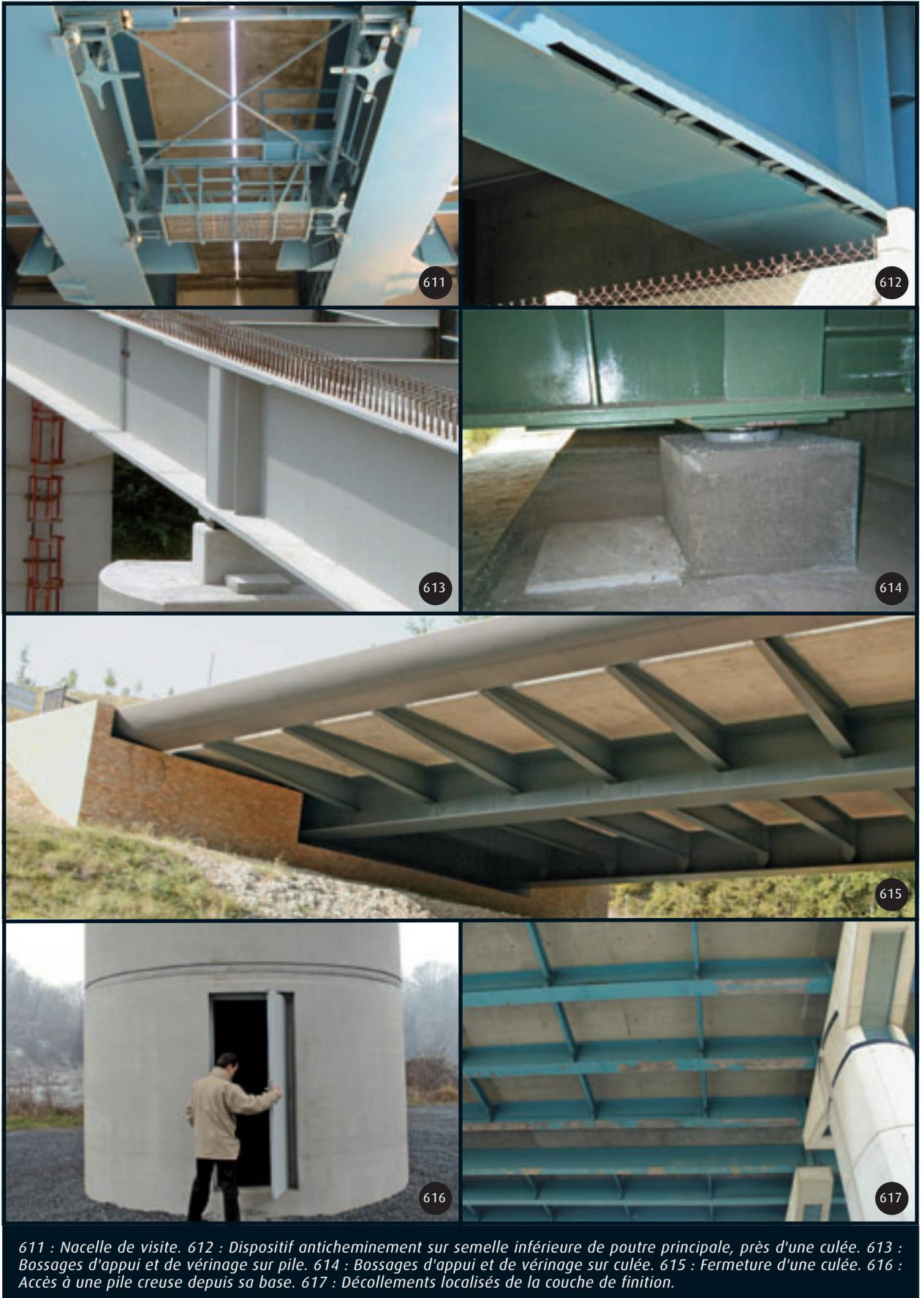
611 : Nacelle de visite. 612 : Dispositif anticheminement sur semelle inférieure de poutre principale, près d'une culée. 613 : Bossages d'appui et de vérinage sur pile. 614 : Bossages d'appui et de vérinage sur culée. 615 : Fermeture d'une culée. 616 : Accès à une pile creuse depuis sa base. 617 : Décollements localisés de la couche de finition.
