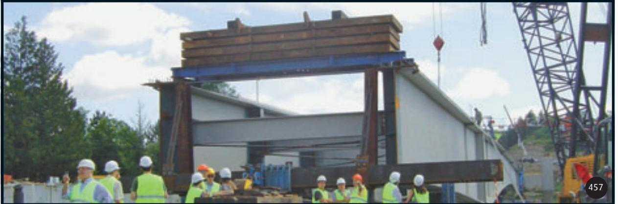
451 et 452 : Contreventements provisoires. 453 : Guidage latéral intégré dans la chaise à galets. 454 : Guidage latéral par profilé. 455 et 456 : Guidages latéraux avec vérin horizontal. 457 : Contrepoids de lançage.
