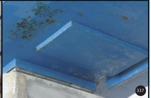
331 et 332 : Zones sur piles de tabliers de hauteur variable. 333 : Pièce de pont sur culée avec emplacements de vérinage. 334 : Blocage parasismique intégré à l'entretoise sur culée. 335 : Réduction de hauteur des poutres principales sur culée pour renfort de dalle. 336 et 337 : Cales biaisées.
