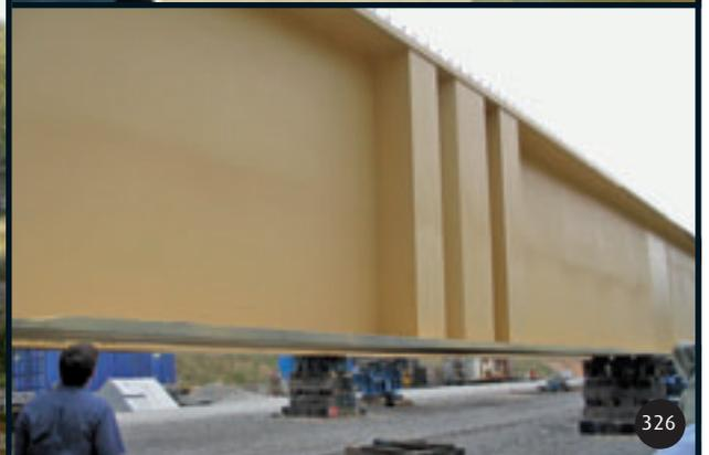
321 : Pièces de pont renforcées par goussets. 322 et 323 : Raidisseurs longitudinaux de bipoutres. 324 à 326 : Montants d'appuis en simple T $\acute{e}$  (324, les emplacements de v $\acute{e}$ rinage sont situés sous l'entretoise sur pile), en T $\acute{e}$  avec deux triangles latéraux (325), avec trois augets (326).
