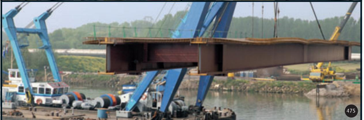
471 : Pose d'une poutre avec une grue mobile sur pneus. 472 : Pose d'un tronçon de bipoutre avec une grue sur chenilles. 473 : Pose d'un tronçon de caisson avec une grue mobile sur pneus. 474 et 475 : Pose de travées entières de bipoutres à l'aide de bigues.
