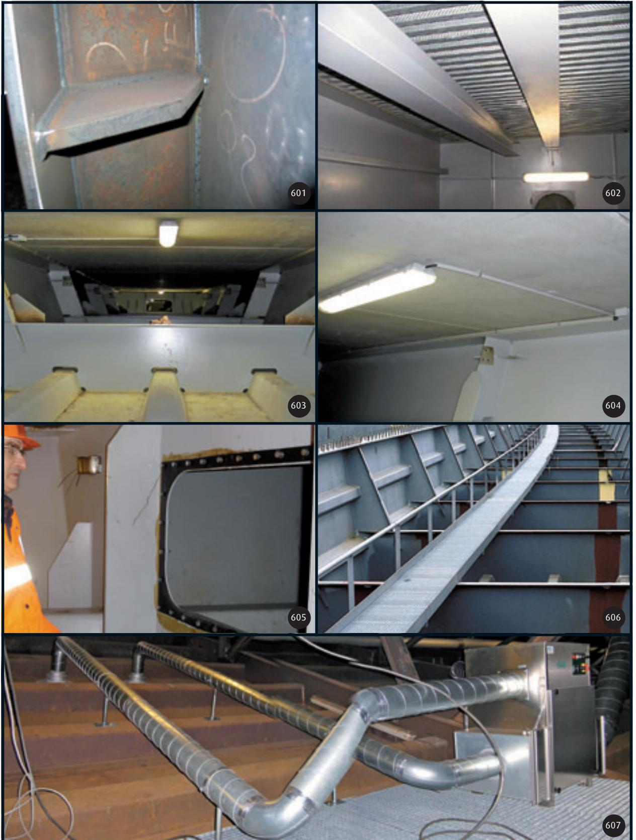
601 : Détail d'un nez de mouchoir. 602 à 604 : Éclairages intérieurs de caissons. 605 : Joint d'étanchéité pour trappe de fermeture de diaphragme sur culée. 606 : Cheminement en caillebotis posé sur traverses de cadres de caisson. 607 : Déshumidificateur.
