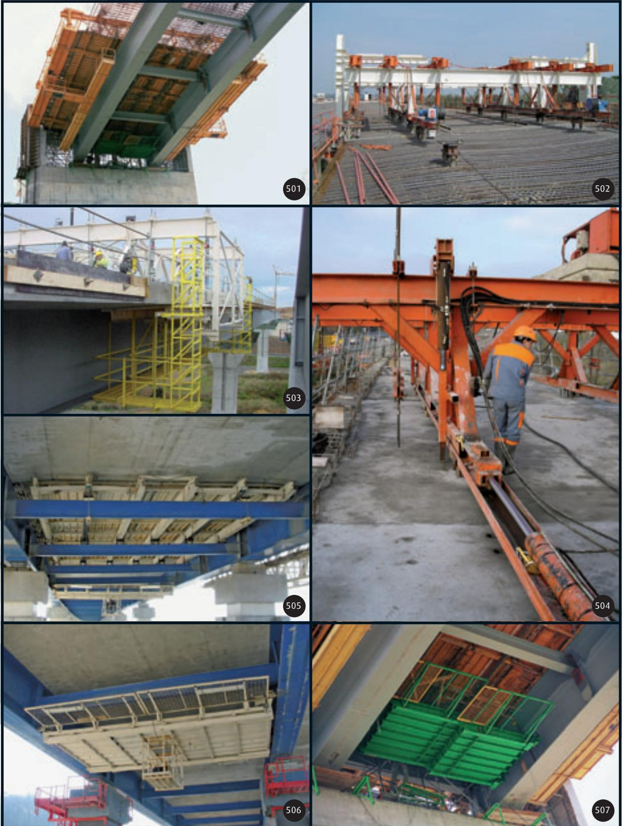
501 à 503 : Vues générales de divers équipages mobiles pour bipoutres à entretoises. 504 : Vérins de déplacement d'un équipage. 505 : Plateau coffrant central d'un équipage pour bipoutres à entretoises. 506 et 507 : Nacelles pour intervention en sous-face de la dalle.
