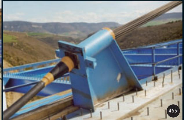
461 et 462 : Mâts de haubannage. 463 à 465 : Ancrage des haubans provisoires sur la charpente définitive.
