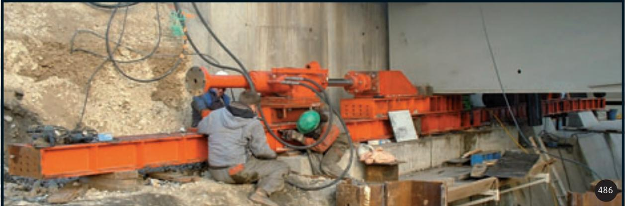
481 et 482 : Palées provisoires courantes. 483 : Palée provisoire de grande hauteur pour montage d'un caisson à béquilles. 484 et 485 : Corbeaux d'assemblage. 486 : Dispositif de ripage transversal.
