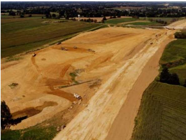
Illustration 7 - Pendant les travaux : la proximité entre la zone de dépôt et la plate-forme autoroutière a permis de réaliser des économies de transport de matériaux [43]
