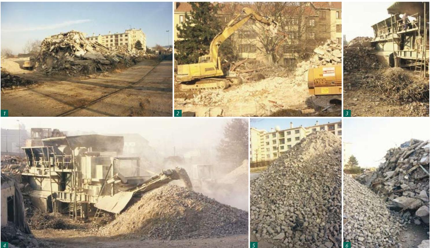
Illustration 10 – Exemple de déconstruction d'un bâtiment : 1 - vue du matériau après démolition ; 2 - pince à démolition ; 3 - ferrailles éliminées ; 4 - concassage mobile ; 5 - stock élaboré ; 6 - comparaison des matériaux avant et après élaboration.
