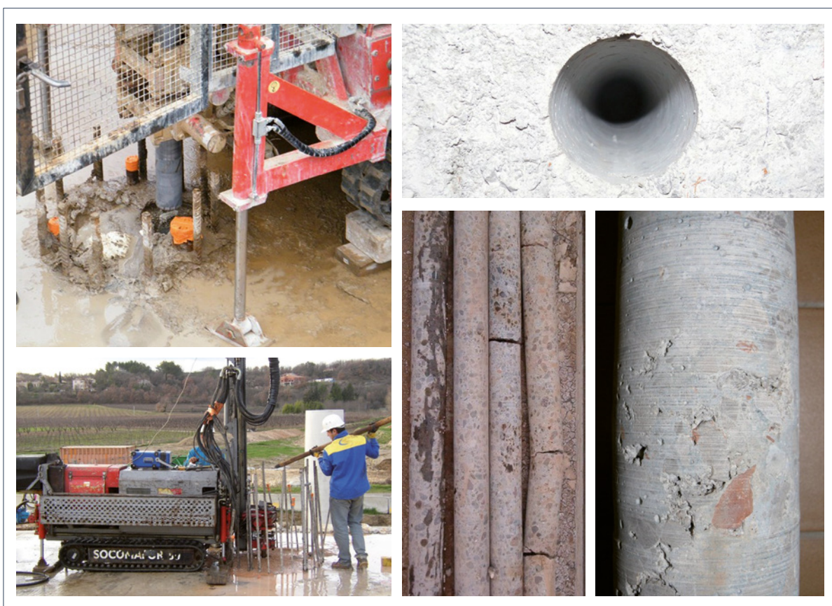
Figure 6.30 : Carottage du béton d'un pieu
