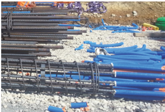
b) Tubes de réservation dépassant en tête de pieux gainés pour faciliter le recépage et l'extraction du bloc de béton
