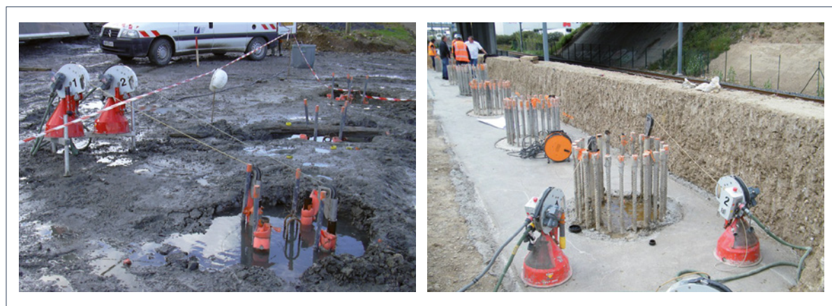
Figure 6.2 : Exemples d'appareillage de la méthode sonique par transparence mise en place sur chantier
