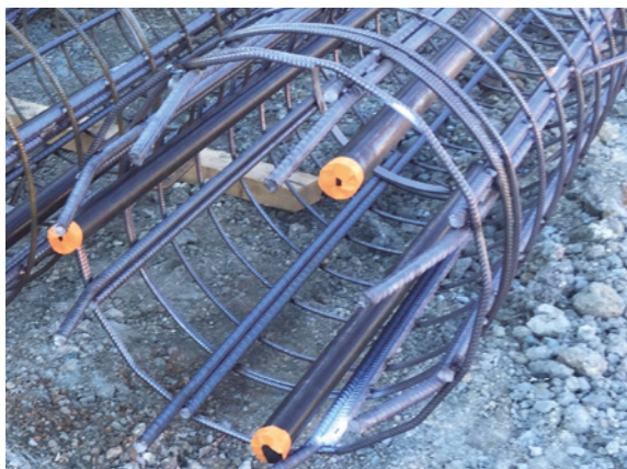
a) Bouchons étanches des tubes de réservation
