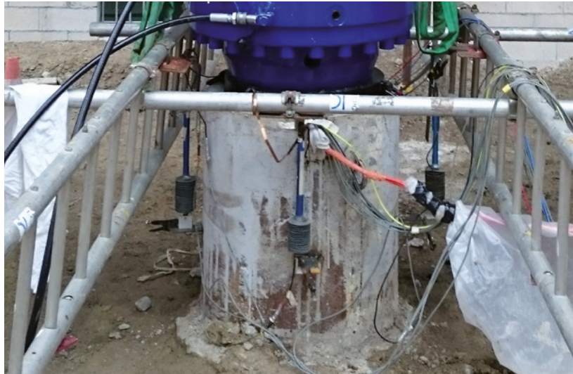
Figure 6.35 : Mesure des déplacements axiaux (verticaux) lors d'un essai de chargement en compression
