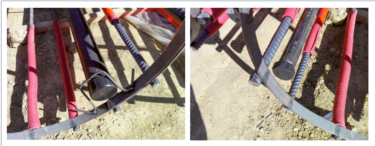
Figure 6.10 : Exemples de bouchons étanches pour les tubes de réservation
