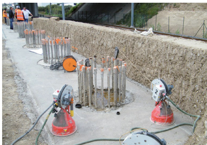
a) Plateforme bien préparée et accessibilité assurée aux tubes de réservation
