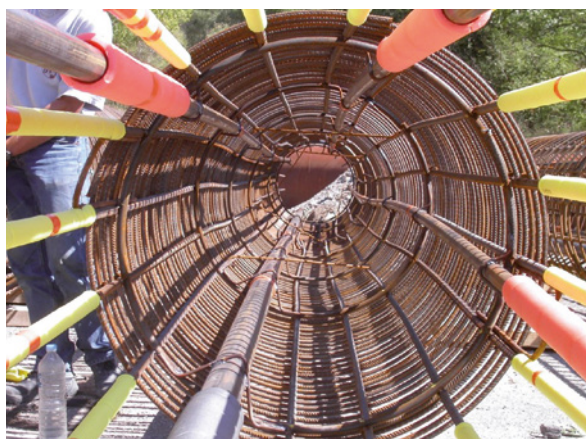
Figure 6.13 : Tubes de réservation non rectilignes et non parallèles induisant un temps de propagation biaisé
