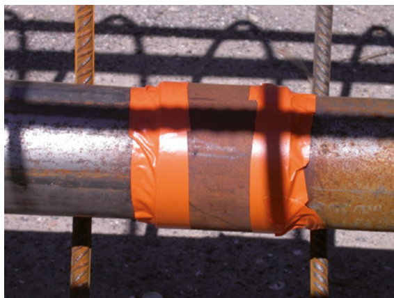
b) Rubans adhésifs pour assurer l'étanchéité au droit d'un tulipage ⚠ à signaler avant l'auscultation sonique)
