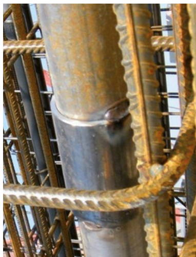
Figure 5.67 : Raccord par manchon partiellement soudé
