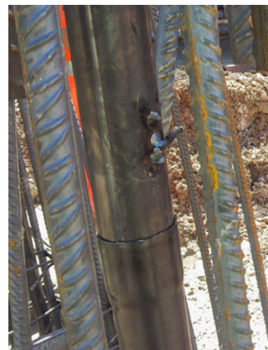
Figure 5.68 : Raccord tulipé (déconseillé)
