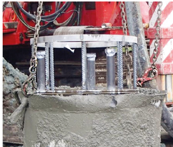
Figure 5.81 : Position du crochet de manutention
