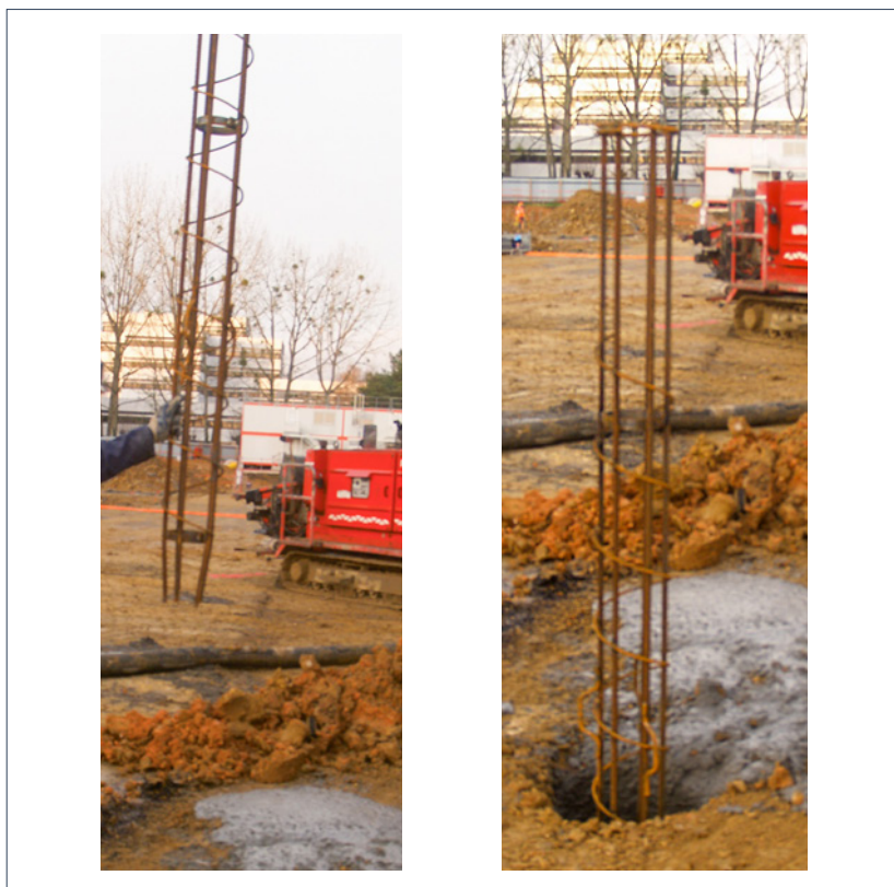
Figure 5.4 : Mise en place des cages en cas d'arase basse de plus de 2 m
