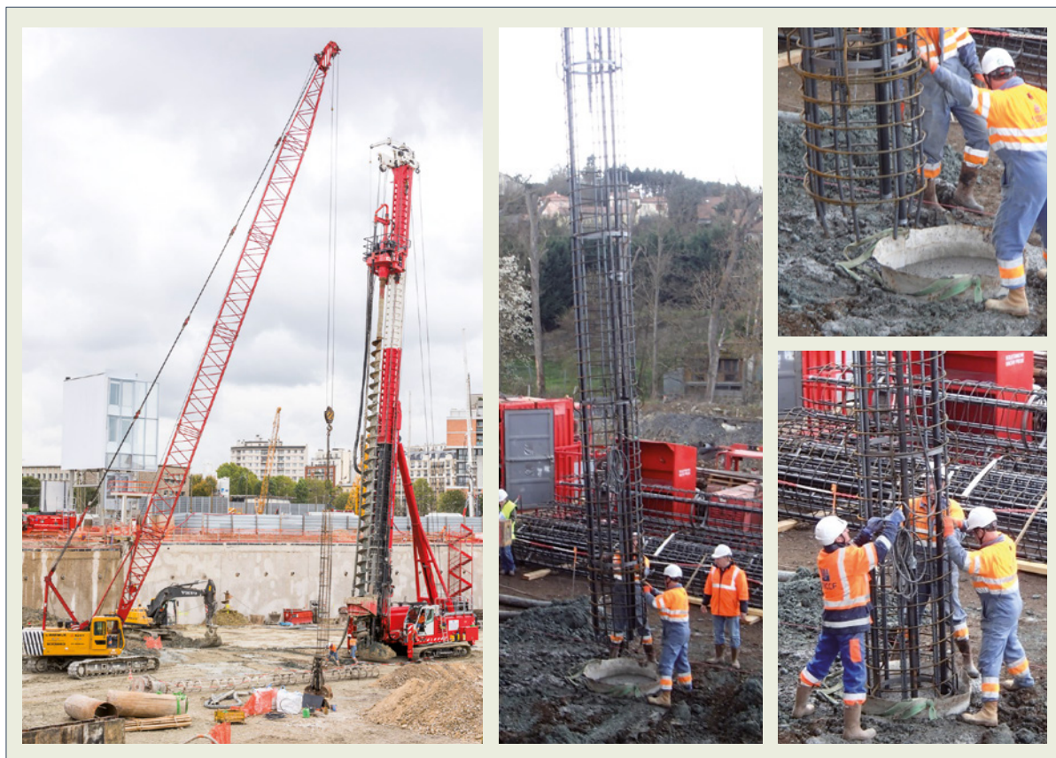
Figure 5.93 : Photos de trépideur et introduction de la cage d'armature dans le béton frais à l'aide d'un trépideur
