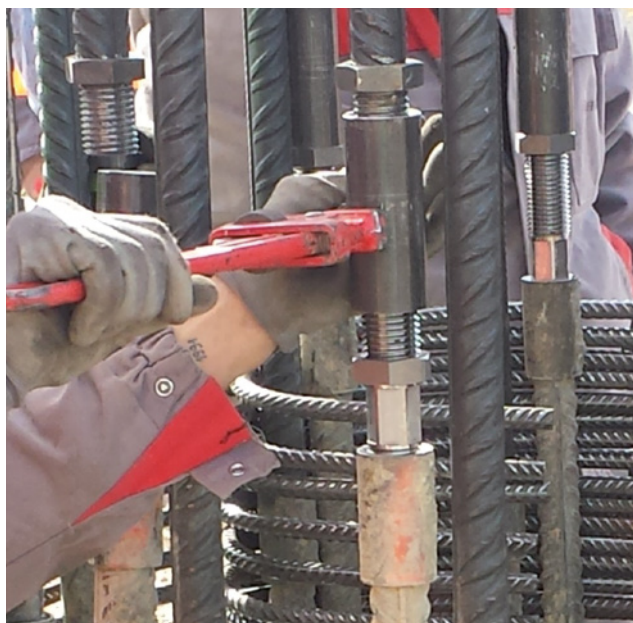
Figure 5.62 : Assemblage en position verticale de la cage d'armature via des manchons
