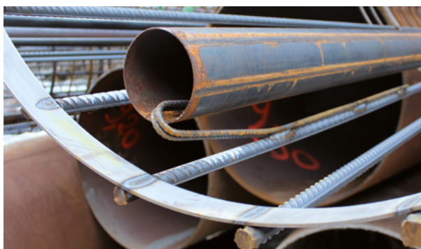
Figure 5.70 : Calage provisoire des tubes de réservation
