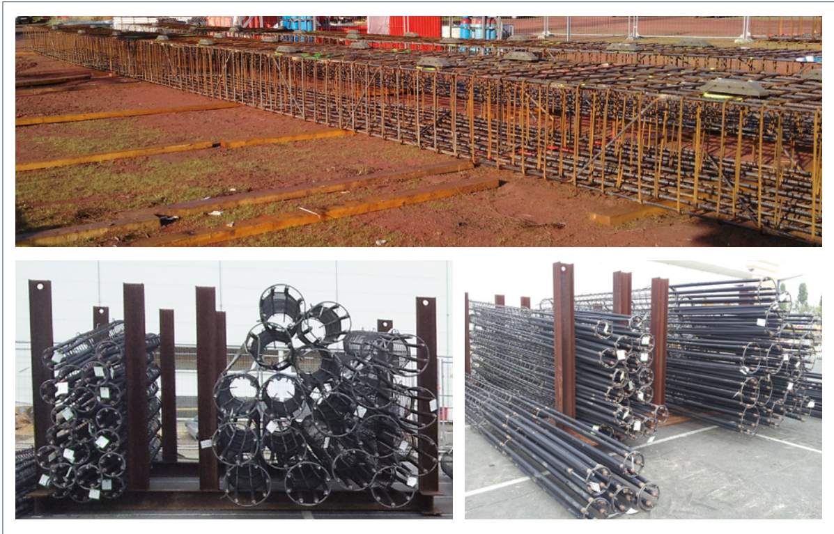
Figure 5.87 : Stockage des cages d'armature
