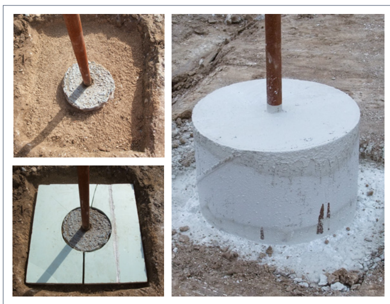
Figure 5.57 : Réservation dans une tête pour passage des extensomètres
