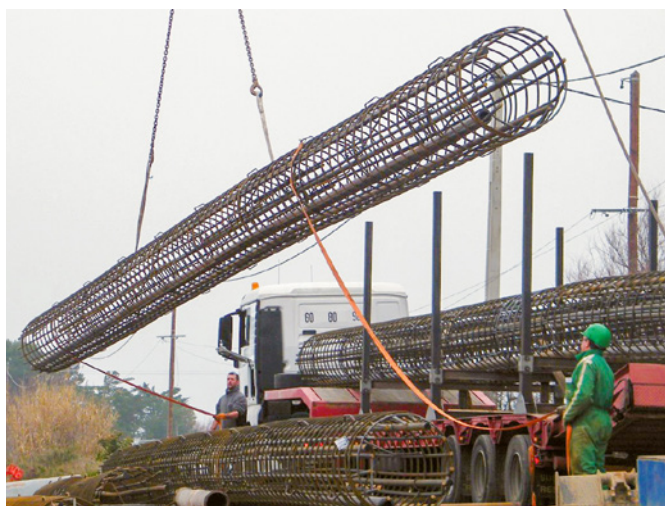
Figure 5.86 : Transport et déchargement de cages d'armature
