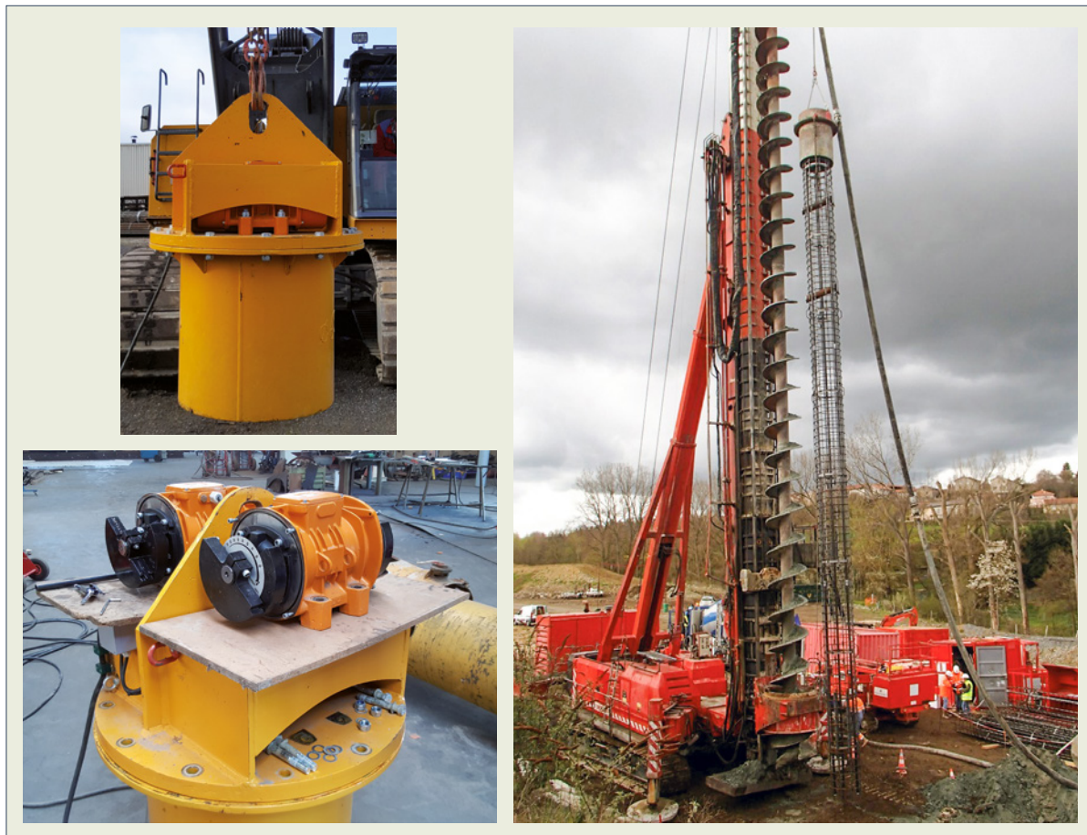
Figure 5.93 : Photos de trépideur et introduction de la cage d'armature dans le béton frais à l'aide d'un trépideur
