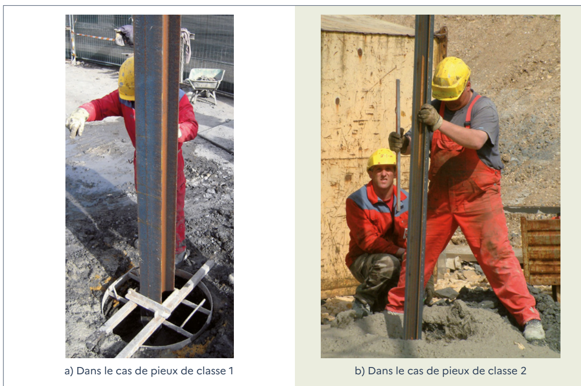
Figure 5.91 : Exemples de mise en place de profilés
