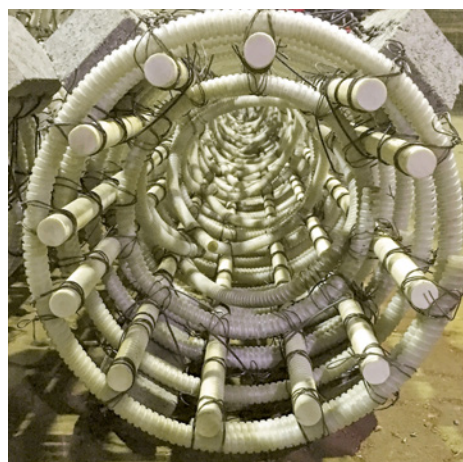
Cerces extérieures et cerces intérieures de montage
