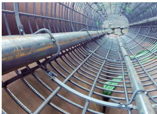
Cerces en bande (ou en fer plat) recevant les dispositifs de fixation des tubes d'auscultation
