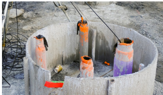
Solution risquée avec mise en place de chiffon et ruban adhésif
