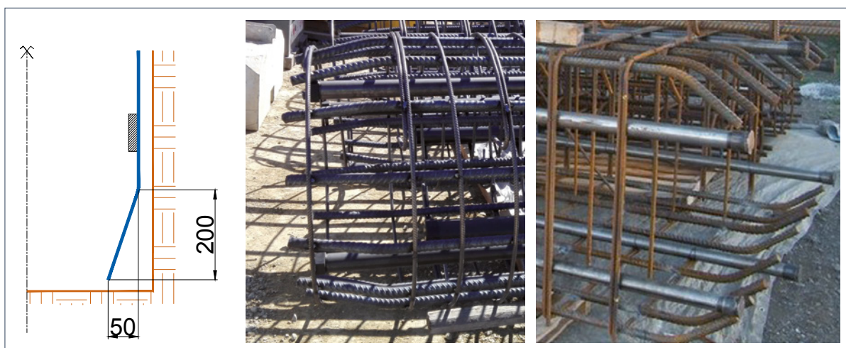
Figure 5.42 : Inclinaison des armatures en fin de cage
