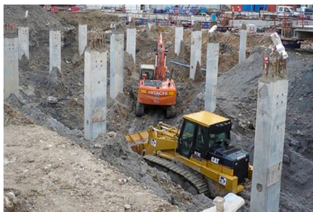
c) Terrassement autour de poteaux préfondés en béton armé
