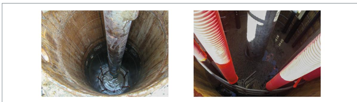
Figure 4.16 : Bétonnage des pieux via le remplissage de la trémie en tête du tube plongeur
