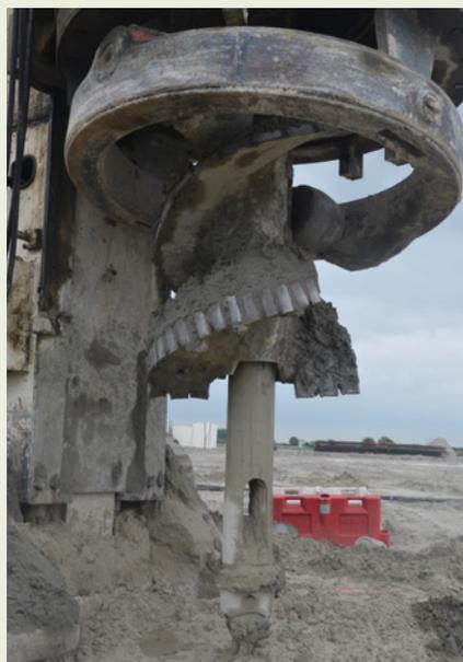
**Figure 4.38 : Fin du bétonnage avec la technique de la tarière creuse**
