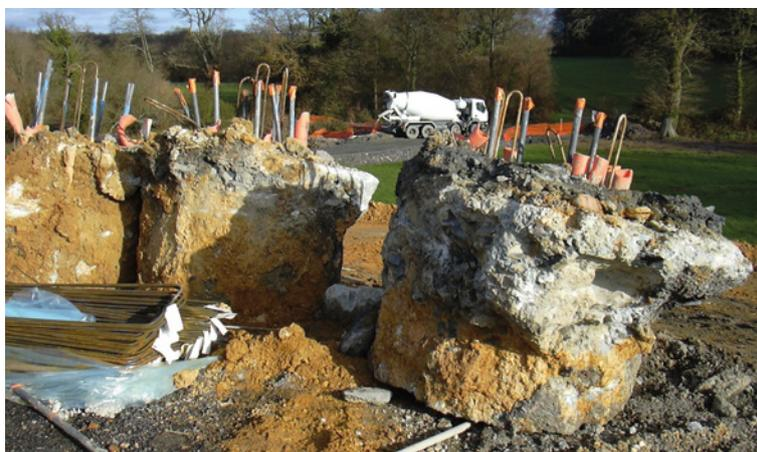
Blocs extraits de béton recépié par méthode RECEPIEUX® provenant de pieux coulés jusqu'au niveau de la plateforme de travail
