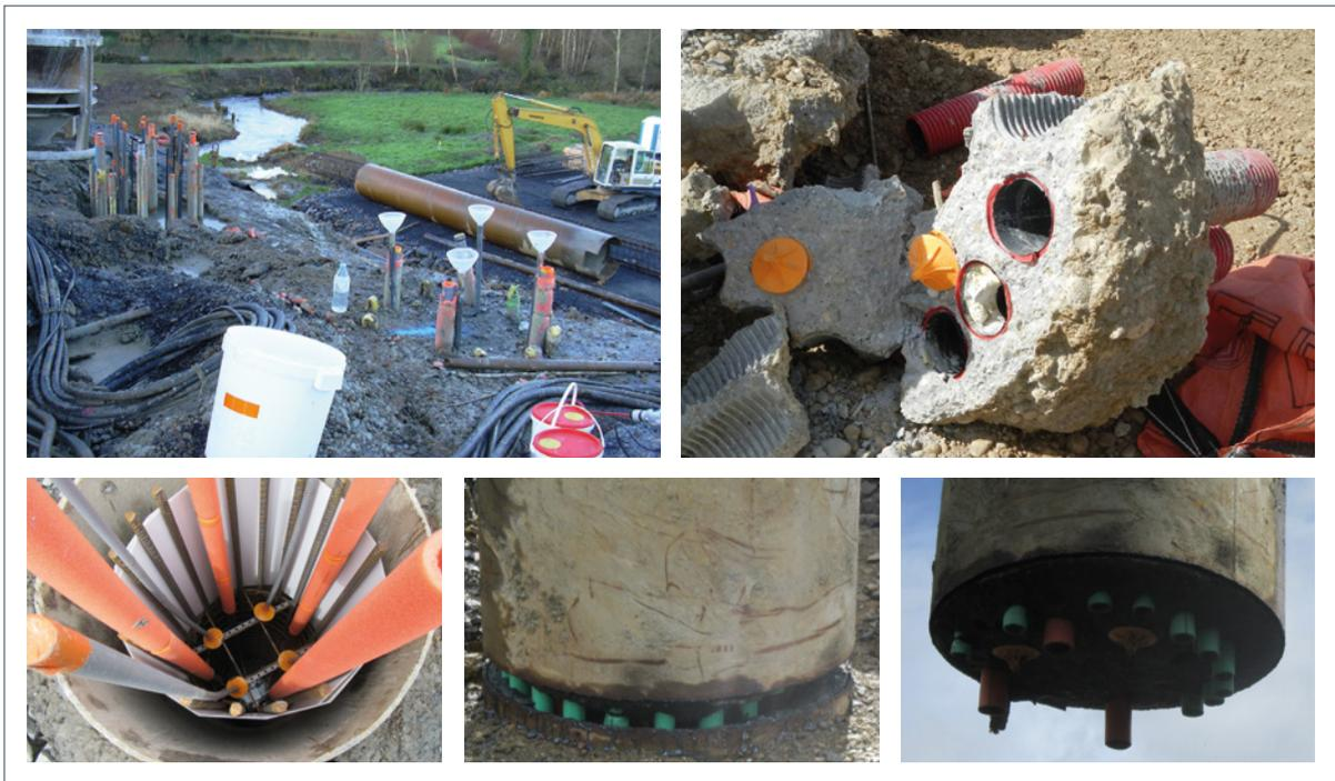
Figure 4.53 : Protection des armatures par des gaines/fourreaux au niveau de la zone à recéper
