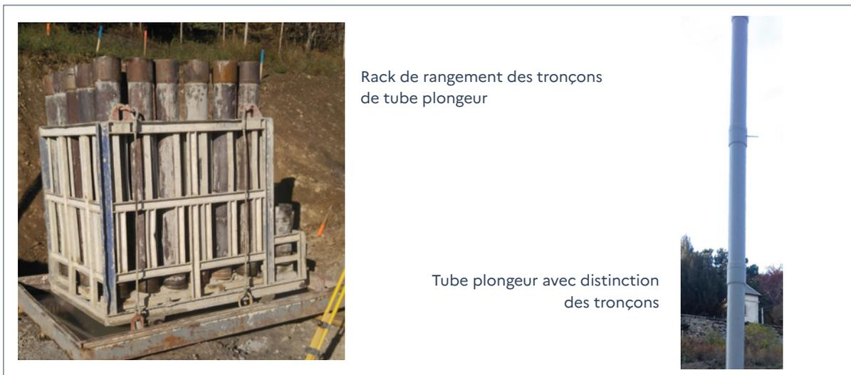
**Figure 4.19 : Exemples de système de retenue et de centrage des tubes plongeurs (ou colonnes de bétonnage)**
