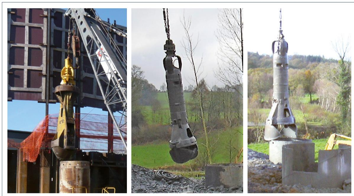
Figure 3.67 : Exemples de benne fixée sur un kelly
