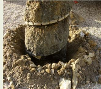
Figure 3.5 : Exemples de tarière creuse à double rotation
