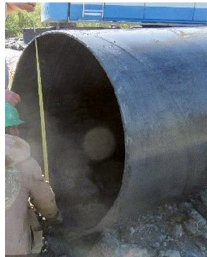
Figure 3.104 : Schéma type de l'arrivée de sable sous un tube de travail en contact avec le substratum
