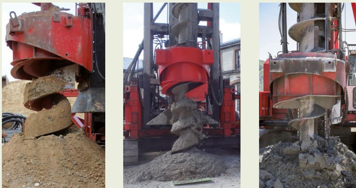
b) Exemple de système de décrotteur actif
