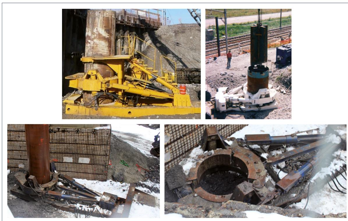
Figure 3.97 : Mise en place d'un tube de travail par vibrofonçage à l'aide du vibrofonçeur<sup>(48)</sup>
