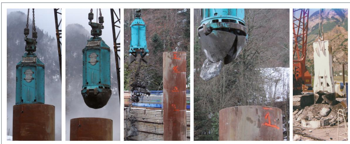
Figure 3.63 : Trépan en croix avec âme creuse pour l'évacuation des déblais
