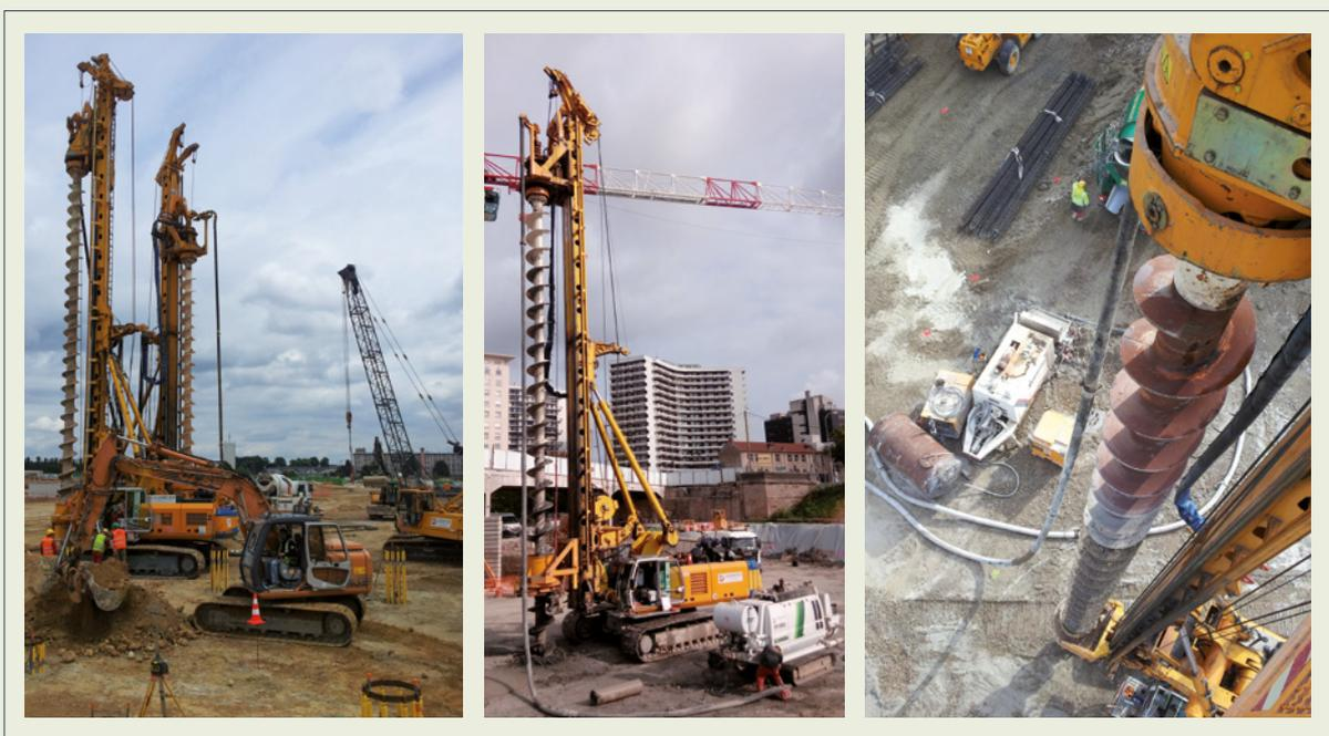
Figure 3.28 : Exemples de machine de forage à la tarière creuse double rotation
