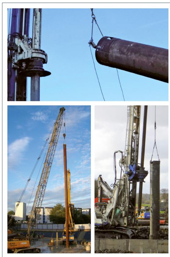
Figure 3.100 : Montage et démontage des tubes récupérés constitués de plusieurs tronçons (schémas de principe)
