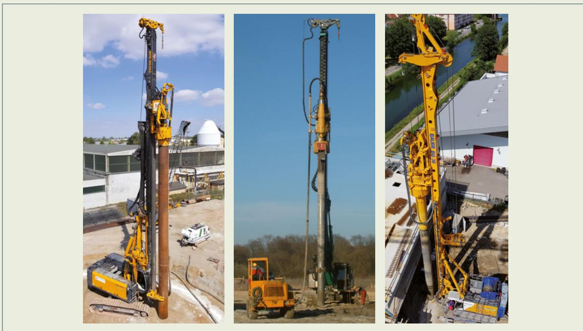
Tableau 3.2 : Classification possible des machines de forage des pieux forés tarière creuse simple rotation (classe 2)
