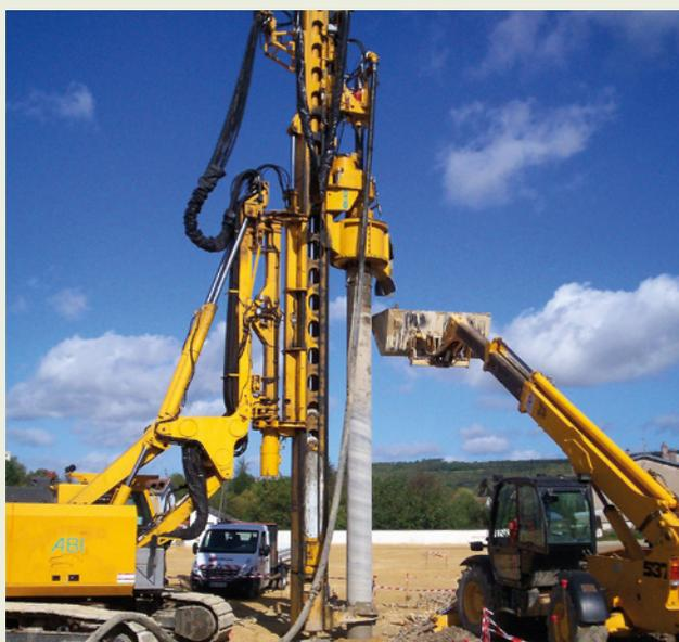
Machine de forage pour la réalisation de pieux à la tarière creuse double rotation
