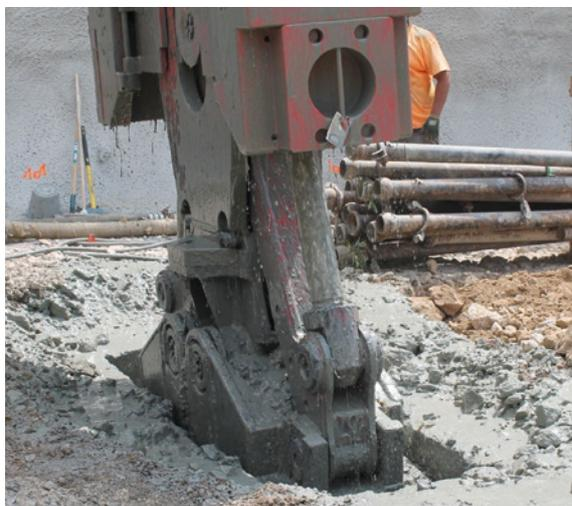
Excavation à l'aide d'une benne preneuse dans un forage rempli de fluide stabilisateur
