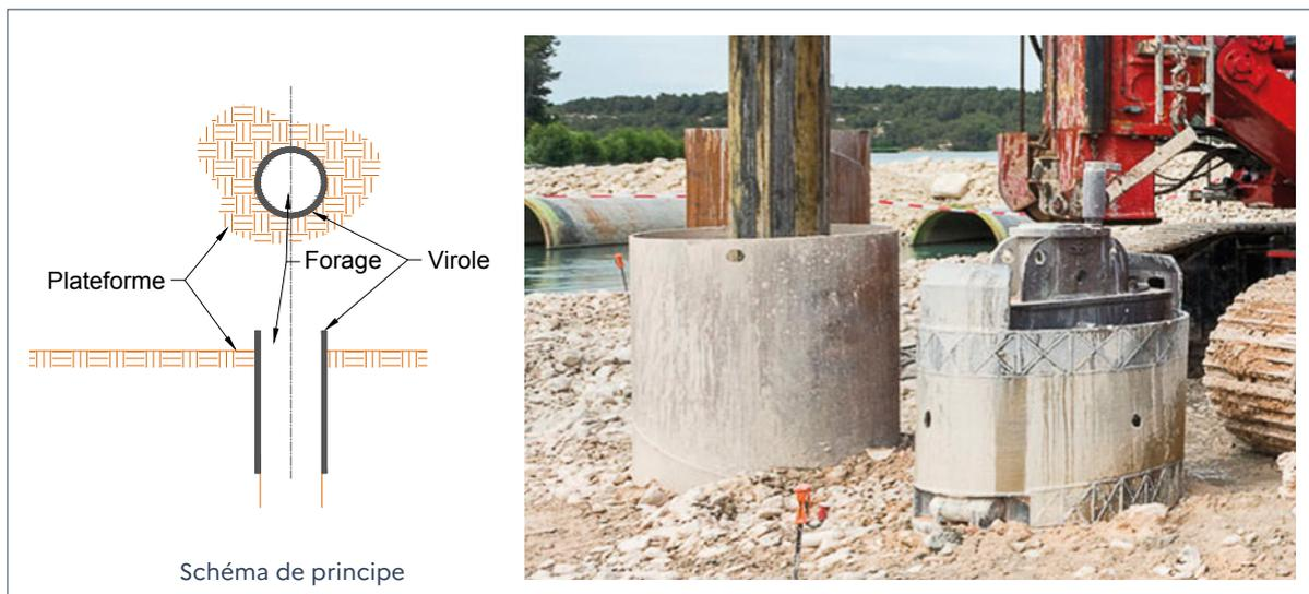
11. Fonçage par battage, vibrage, vérinage, vissage ou par une combinaison de ces méthodes (selon l'article 3.23 de la norme NF EN 12699).
