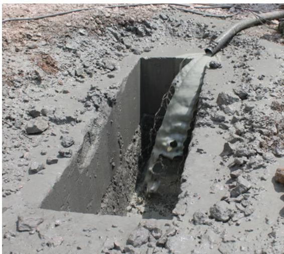
Remplissage par la tête du forage par un fluide stabilisateur (ici une suspension minérale)
