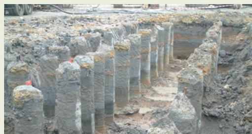
Exemple de pieux réalisés par la technique tarière creuse double rotation
