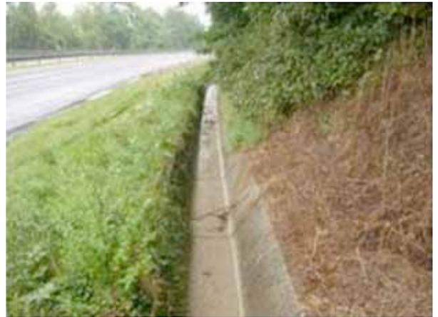
Figure 2 – Exemples de composante « TRANSFERT » : fossés étanches (LCPC/LR St Quentin)
