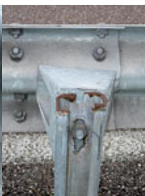
Figure 8 : découpe et perçage du support de fixation
