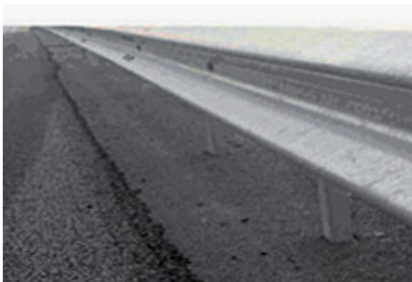
Figure 5 : les pieds de glissière implantés dans l'enrobé facilitent l'entretien
