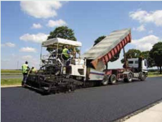
Le **Finisseur** assure la mise en place de la couche de roulement, faite de matériaux enrobés (granulats mélangés à un liant hydrocarboné type bitume). Il reçoit les enrobés dans une trémie, à l'aide d'un camion benne, puis les répand en couche uniforme.
