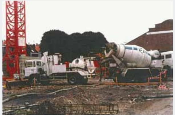
*Coulage d'un pieu (pompe à béton + toupie)
