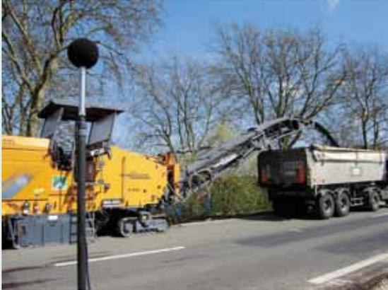
Une **Fraiseuse** est un engin qui permet de « décaper » les routes afin de les restaurer, elle est dite à froid quand il n'est pas nécessaire de chauffer le revêtement avant son entrée en action.
