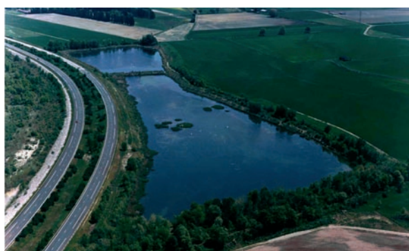
Aménagement routier de Fos sur mer (Bouches-du-Rhône) - Source : Robin Rolland (DIREN Paca)
