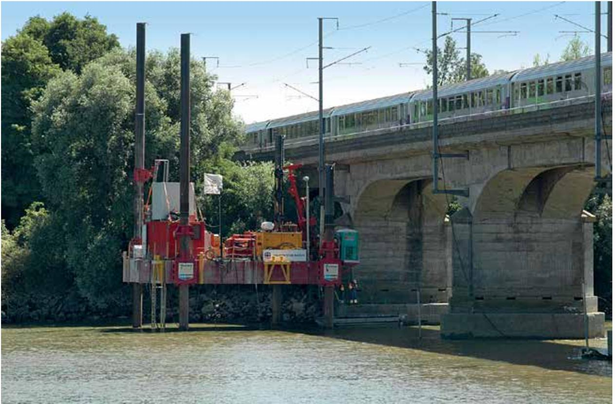
Figure 18 : Injection de maçonnerie (Photo : RFF)
