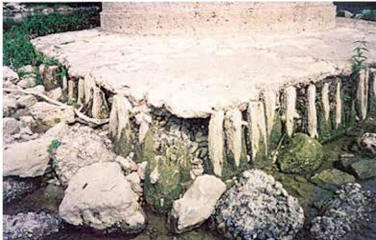
Figure 6 : Dissolution partielle du béton de chaux (Photo : SNCF)
