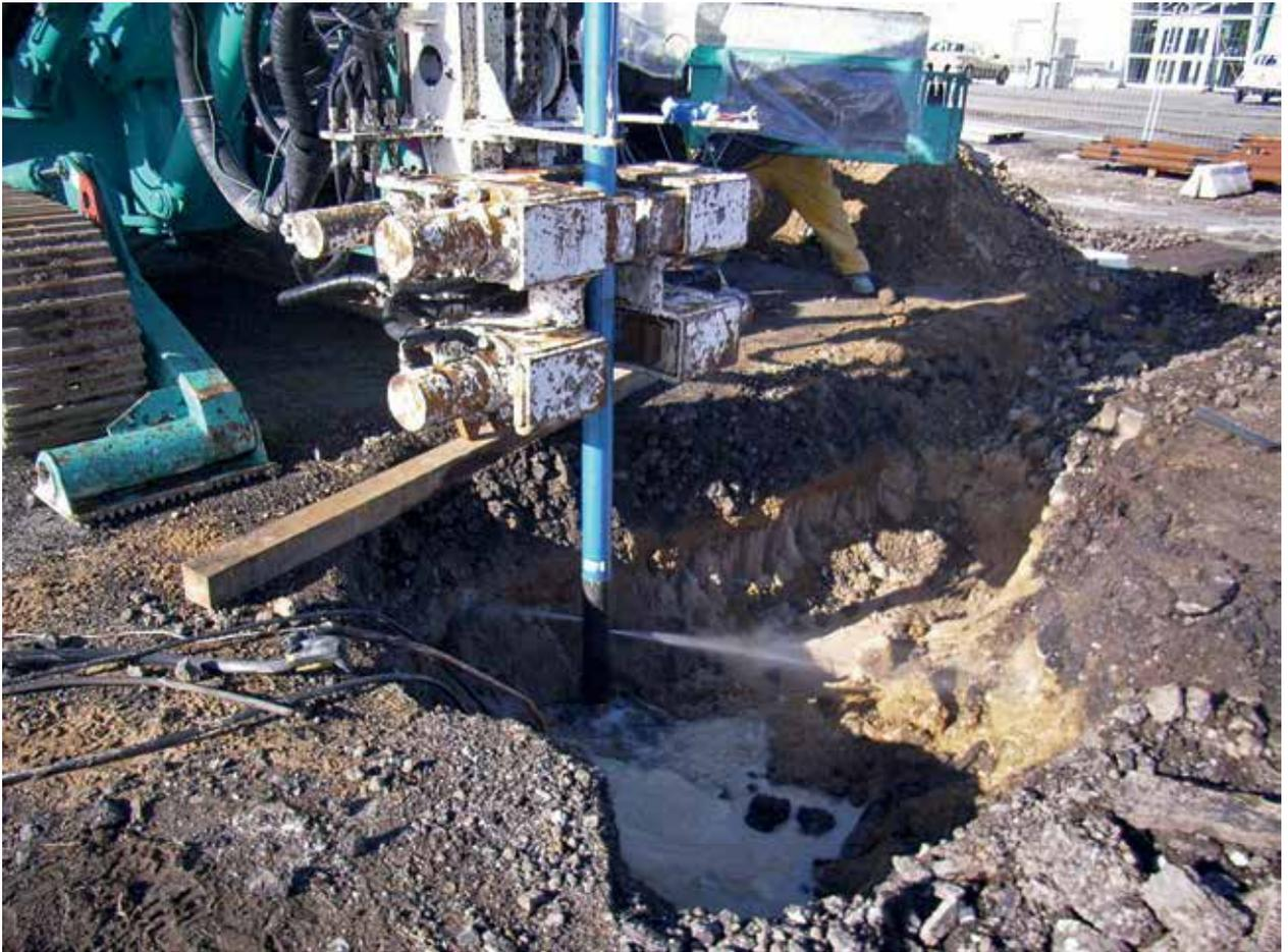
Figure 19 : Matériel de jet-grouting (Photo : IFSTAR)
