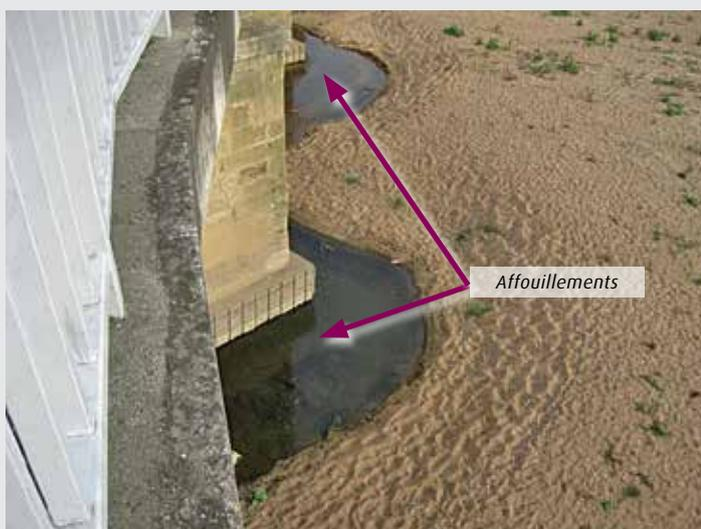
Figure 1 : Affouillements à l'amont d'une pile
