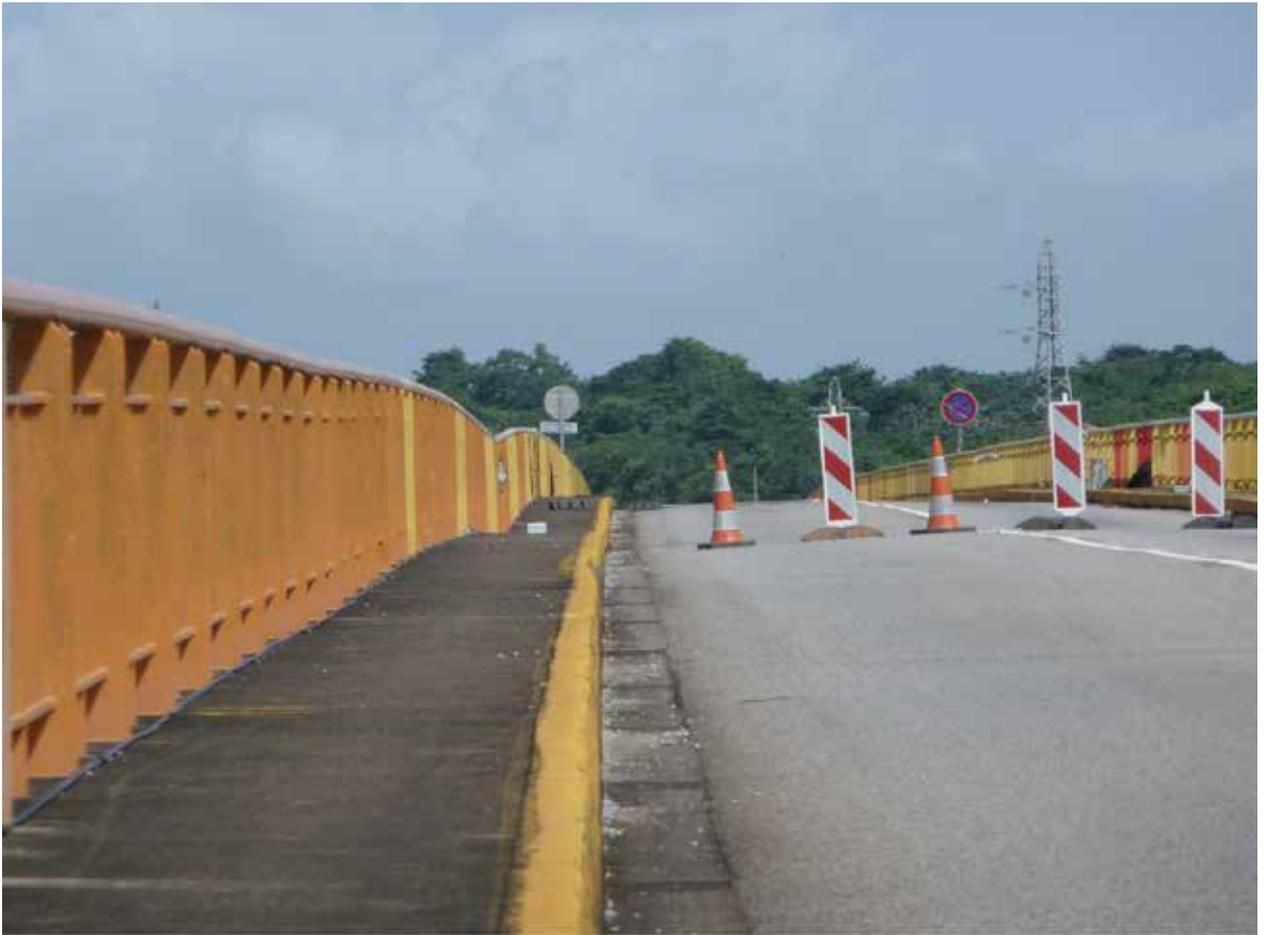
Figure 5 : Tassement d'appui du pont sur le Larivot visible au niveau du garde-corps (Photo : CETE de l'Ouest)
