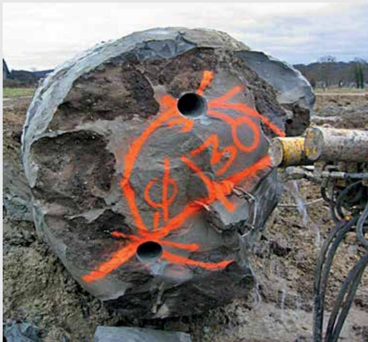
*Colonne de jet-grouting découverte pour contrôle du diamètre
