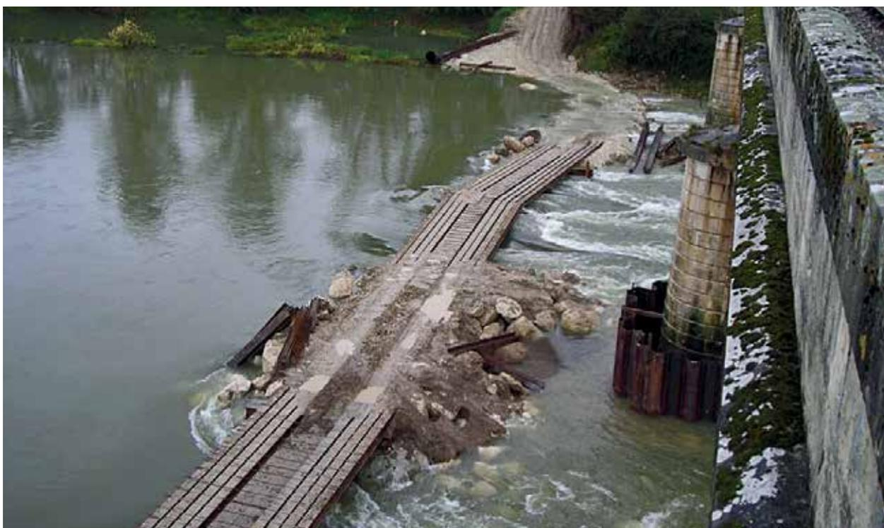
Figure 15 : Estacade d'accès pendant une crue (Photo : SNCF)
