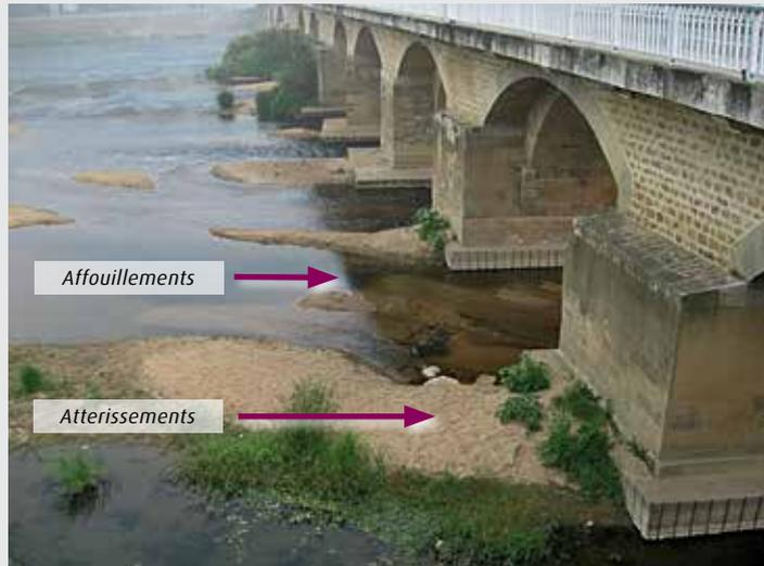
Figure 2 : Affouillement à l'aval d'une passe et atterrissement à l'aval d'une pile
