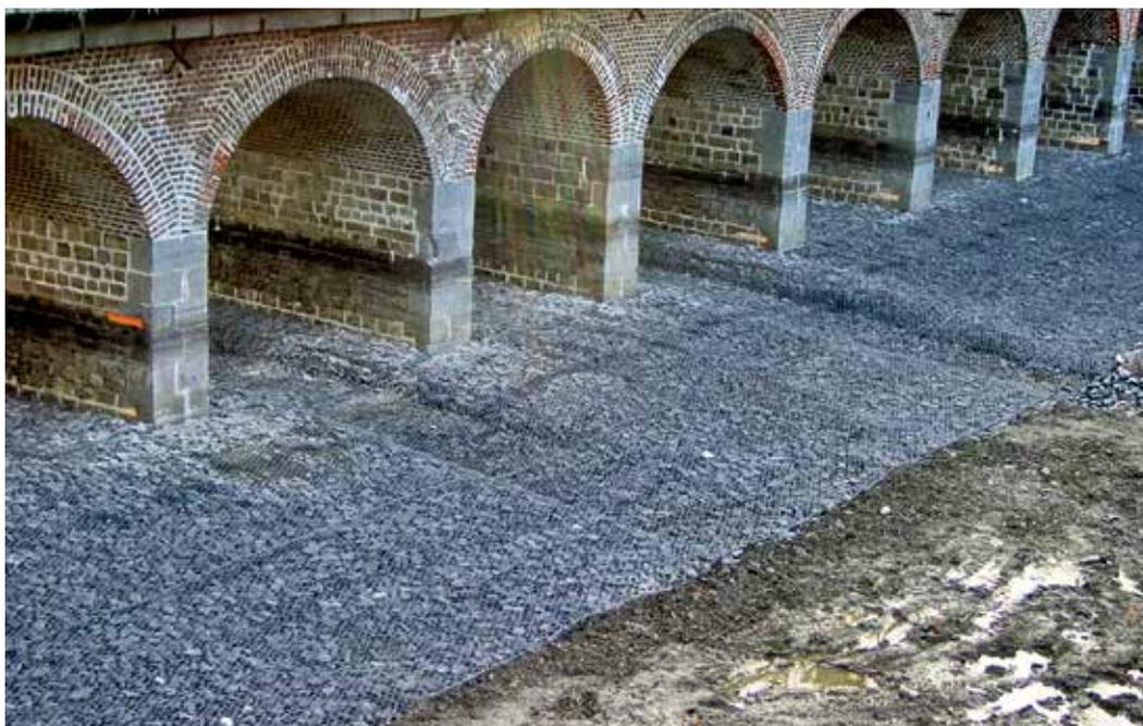
Figure 16 : Mise en place de tapis de gabion (Photo : CETE Nord-Picardie)
