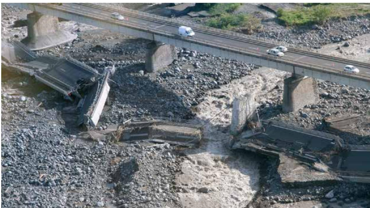
Figure 3 : Effondrement du pont sur la rivière Saint-Étienne dû à un affouillement (Photo : CETE Méditerranée)
