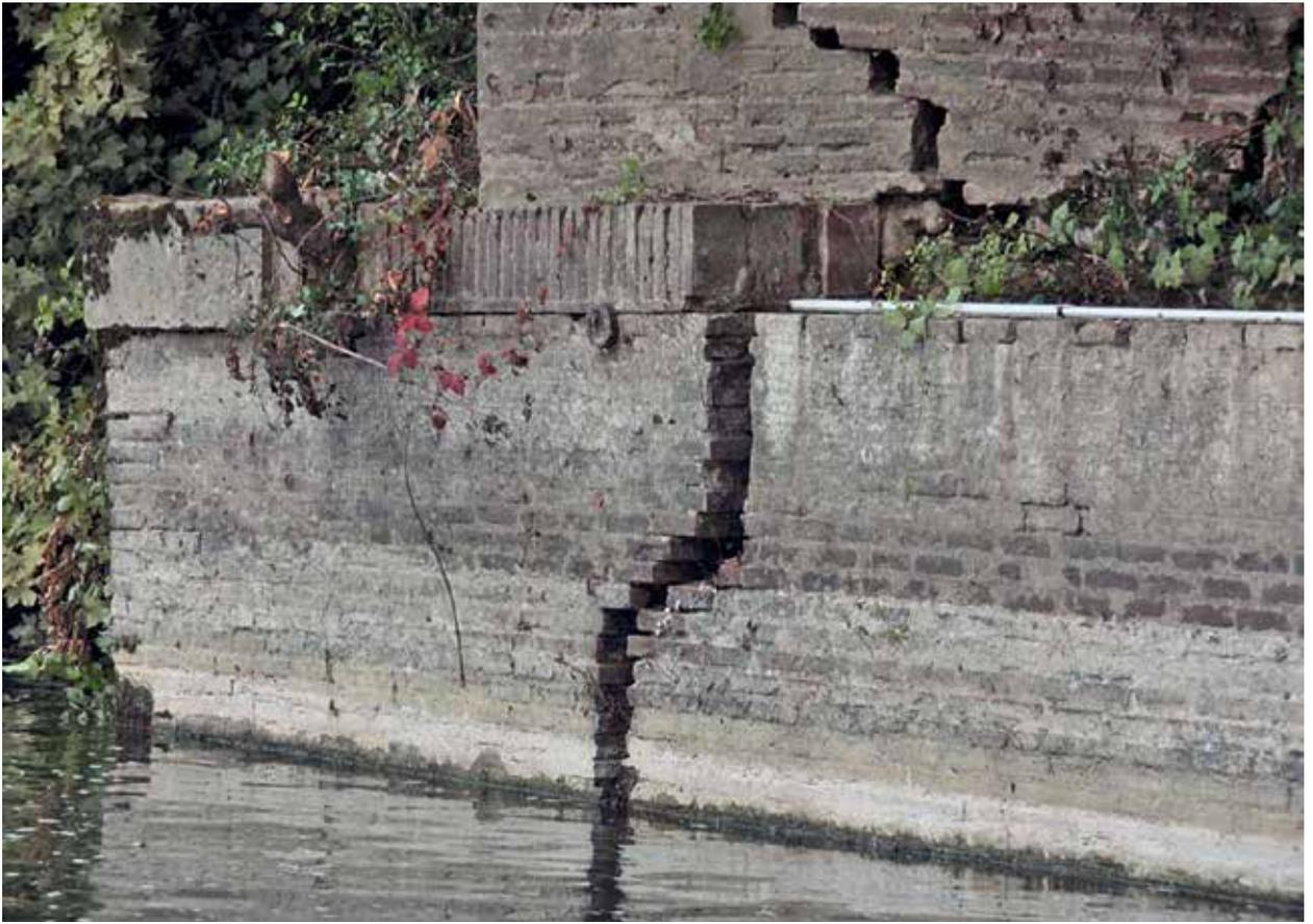
Figure 12 : Fracture dans un mur de soutènement (Photo : DRIEA Île-de-France)
