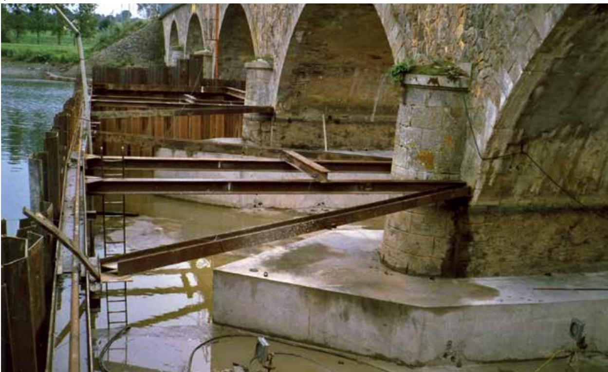
Figure 14 : Ceinturage d'un appui à l'abri d'un batardeau (Photo : J.P. Levillain)
