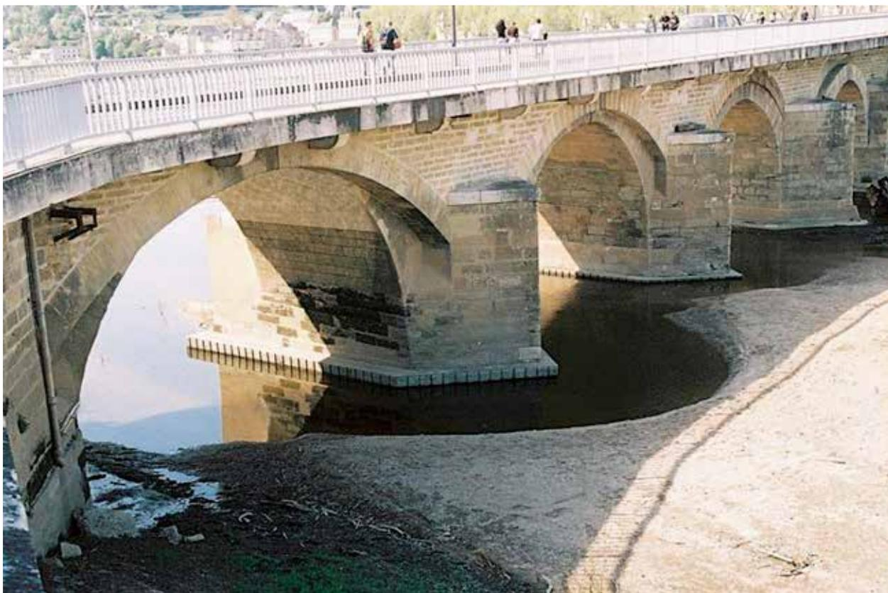
Figure 4 : Différences de niveau à proximité des piles à l'étiage (Photo : J-P Levillain)
