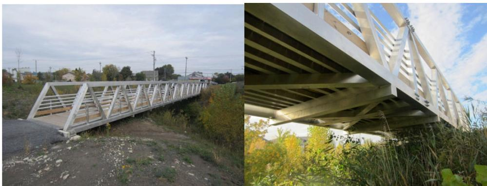
Figure 5.7 Pont à treillis pony en aluminium du ruisseau Daigneault
