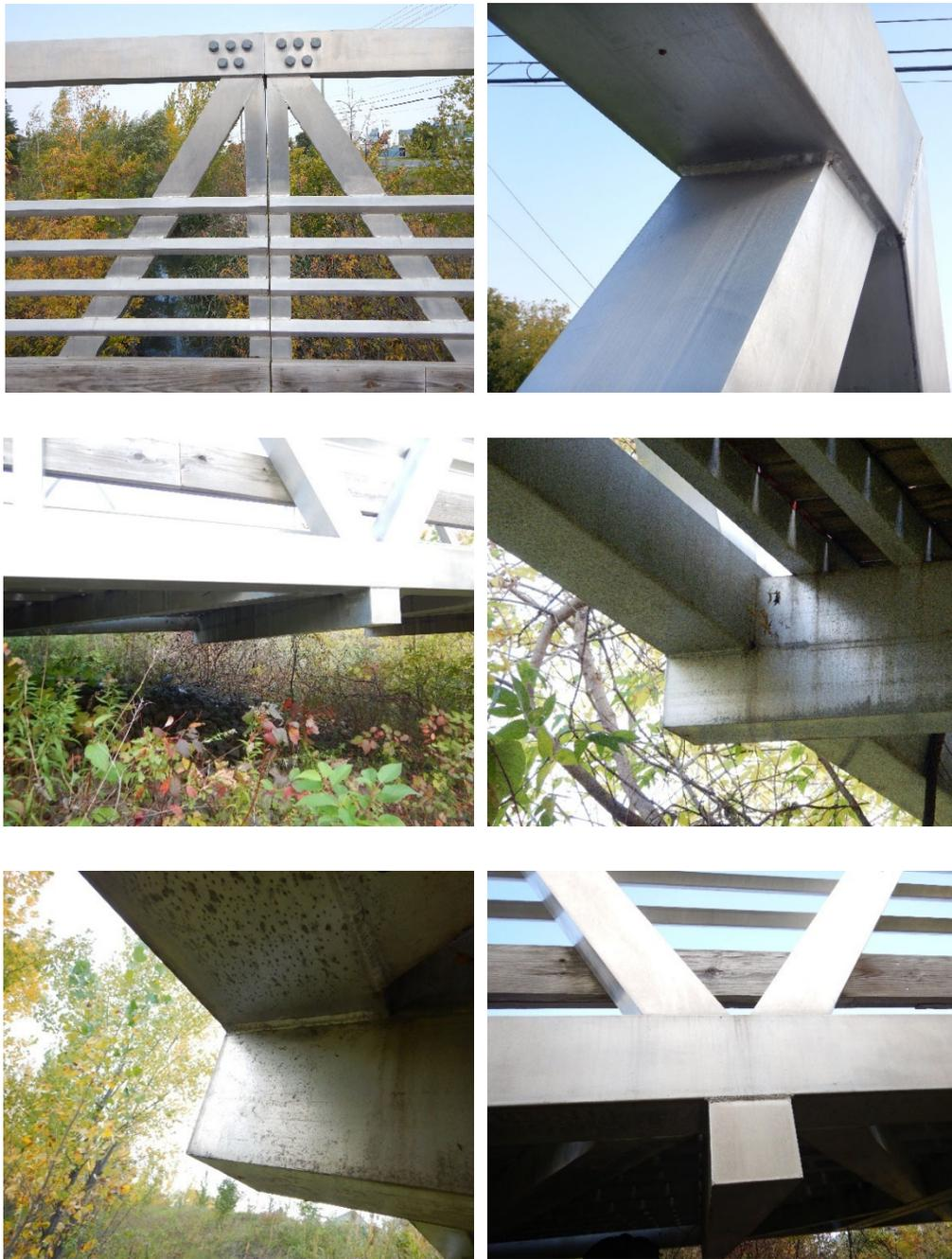
**Figure 4.3** Assemblages soudés et boulonnés de profilés tubulaires en aluminium pour les membres principales
