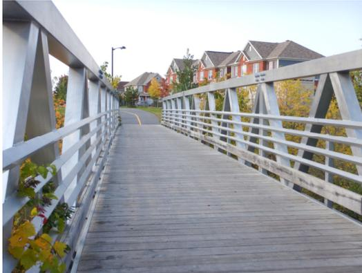
Figure 1.5 Vue d'un pont à treillis pony en aluminium avec surcharge véhiculaire maximale de 58 kN situé à Saint-Hubert (Paez, 2020)
