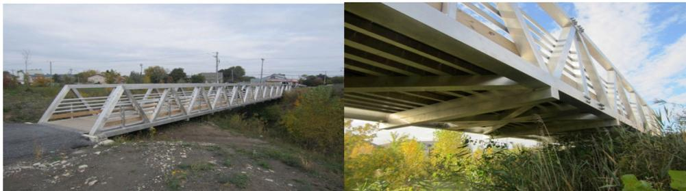
**Figure 1.1 Pont à treillis pony en aluminium (Paez, 2020)**
