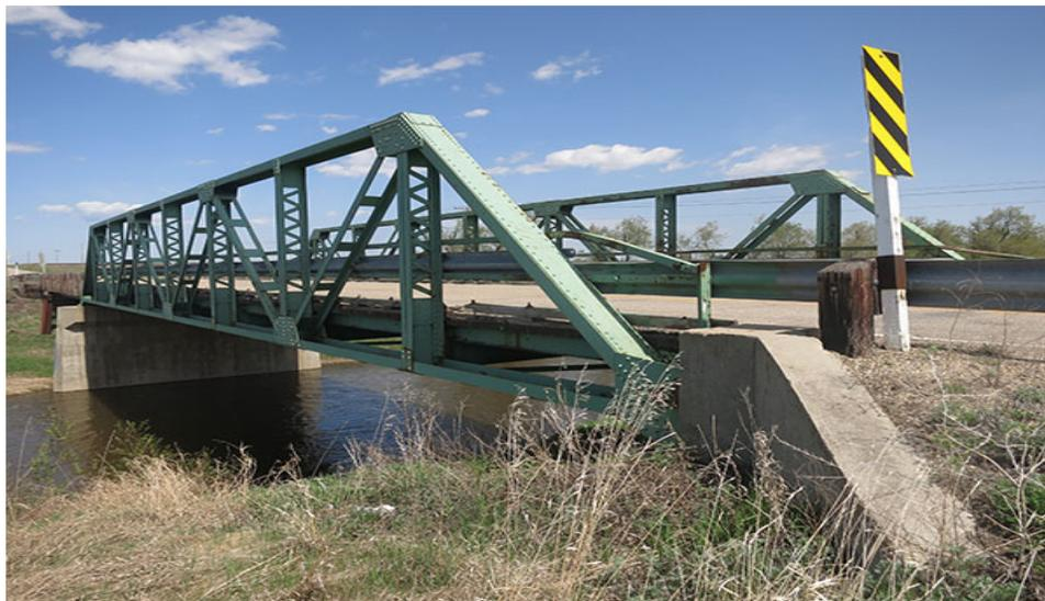
**Figure 1.2** Pont à treillis pony en acier sur la rivière Valley (Paez, 2020)
