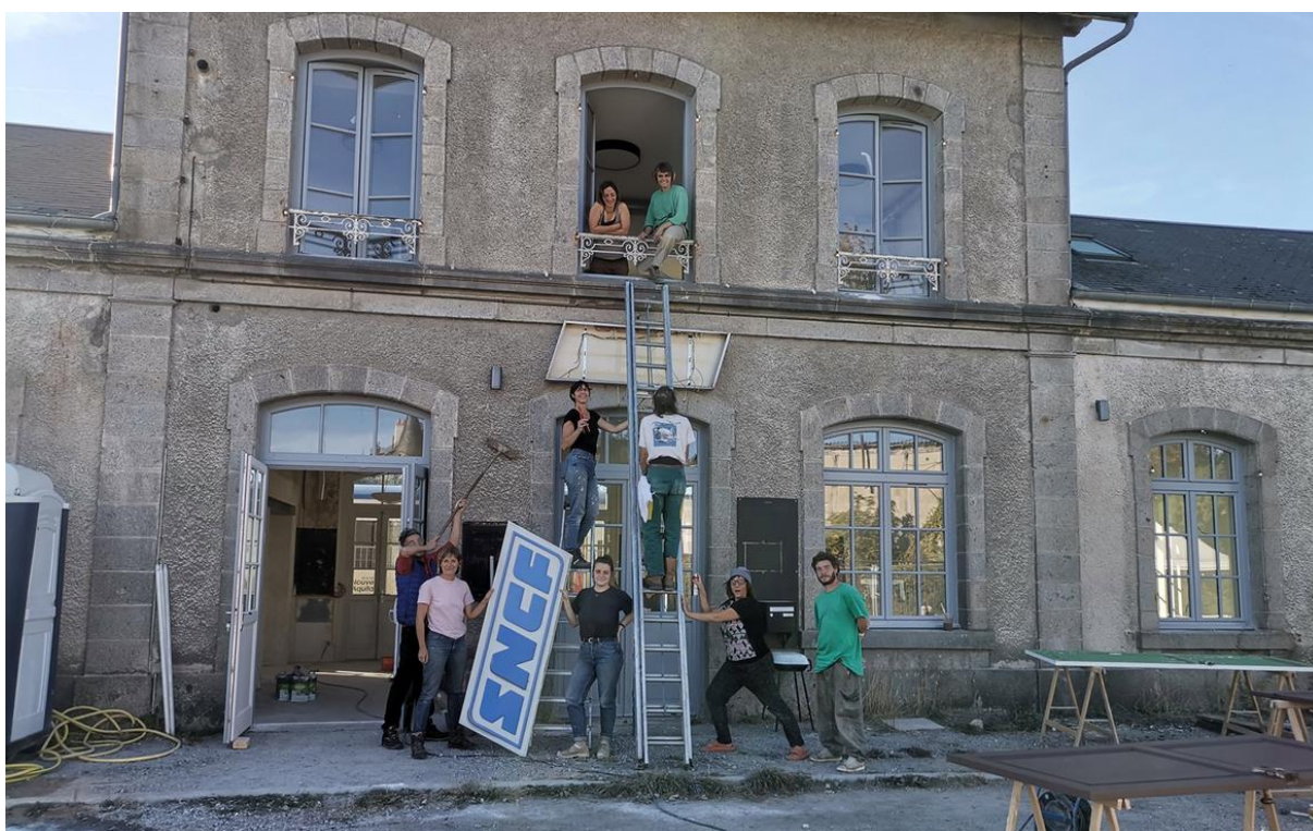
Chantiers participatifs à la gare de Felletin (Source : www.culture-nouvelle-aquitaine.fr )
