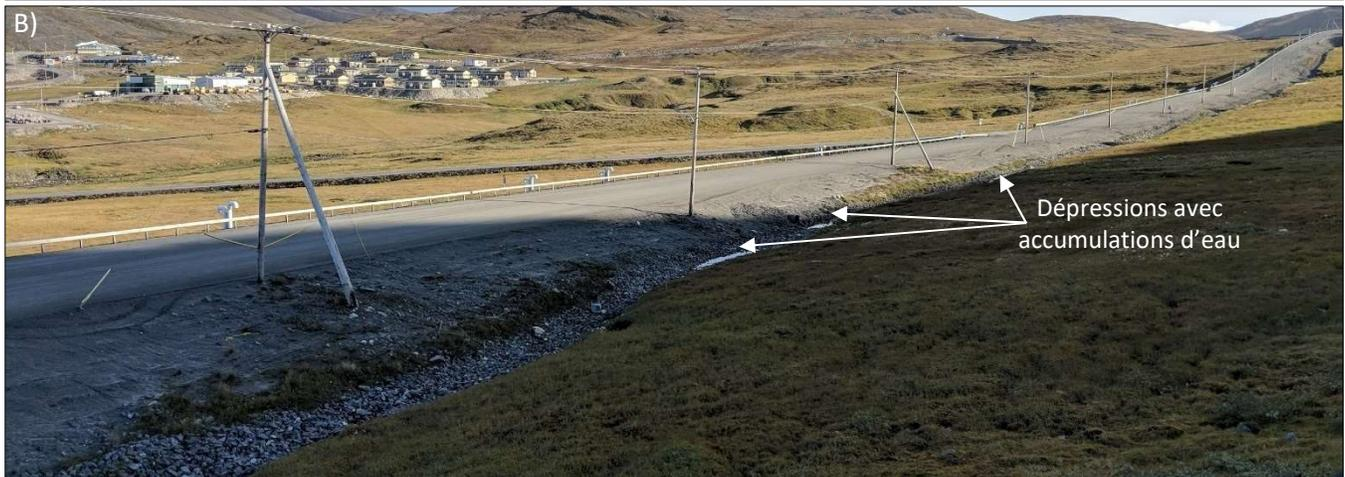
Figure 70 : A) Exposition d'un pergélisol riche en glace et développement d'une niche de thermo-érosion lors de l'excavation du terrain naturel à l'été 2012 au cours de la mise en place fossé de drainage côté amont, chaînage 1+380 m, route d'accès à l'aéroport de Salluit. B) Dépressions accompagnées d'accumulation d'eau observées à l'été 2019 entre les chaînages 1+380 m et 1+460 m.
