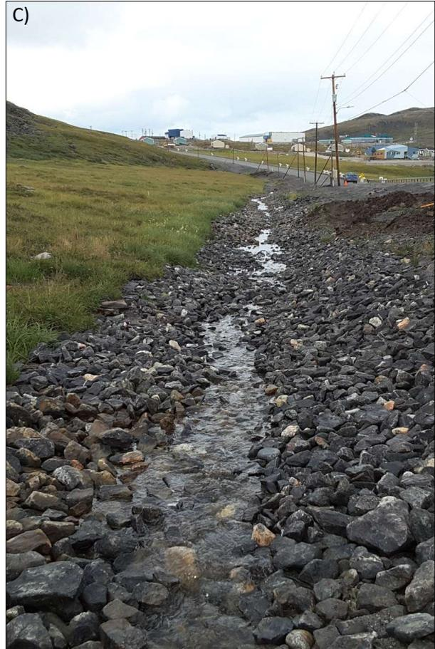
Figure 68 : A et B) Reprofilage par comblement du fossé côté amont de la route d'accès à l'aéroport de Salluit. C) Aperçu final du profil du fossé dans lequel l'écoulement est désormais rectiligne et fluant (Tirée de L'Hérault et Allard, 2016).
