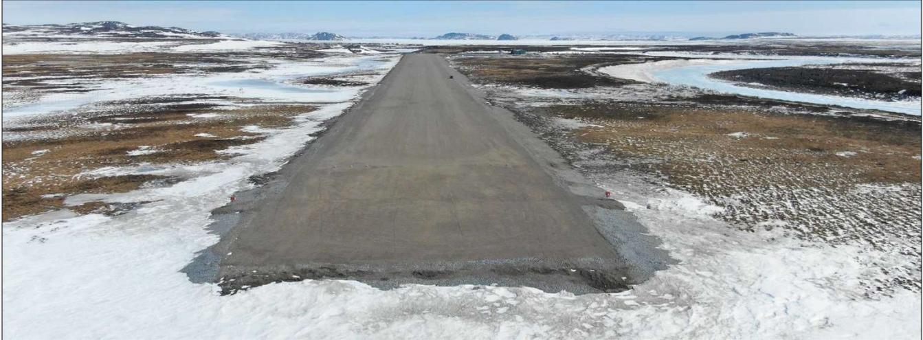
Figure 100 : Patron de distribution de la couverture de neige résiduelle observé à la fin de l'hiver 2019, piste d'atterrissage de Tasiujaq.
