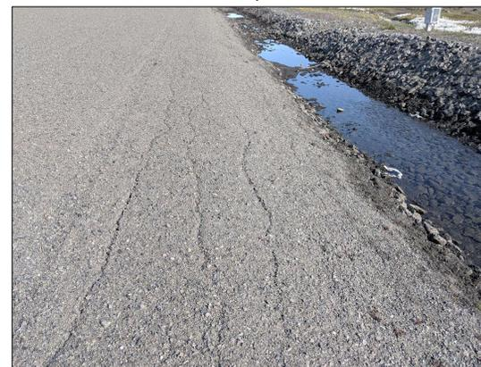
Figure 112 : Emplacements des plaques de tassements, anciennes dépressions et fissures localisées pour la période (2004-2012) sur fond topographique généré à partir des données LIDAR de 2016, piste d'atterrissage de Quaqaq. A) Nouvelle dépression réapparue sensiblement au même endroit que l'ancienne dépression QUA-Dp-2. Fissures longitudinales en haut de talus aux environs des chaînages B) 1+600 m et C) 1+660 m. Les photos A, B et C ont été prises à l'été 2019.
