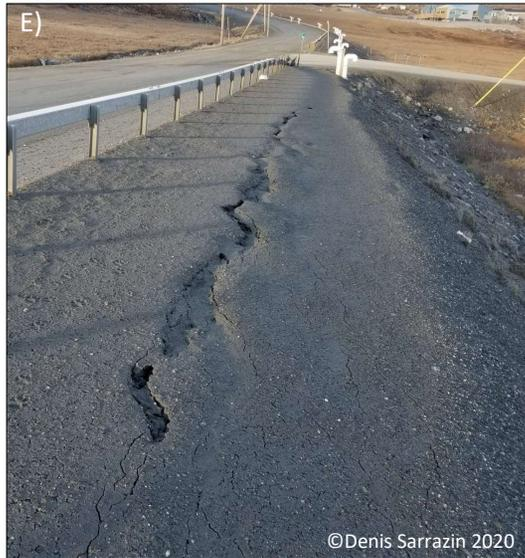
Figure 59 : Évolution de fissures situées dans l'accotement du côté aval entre les chaînages 1+580 m et 1+600 m, route d'accès à l'aéroport de Salluit. A) 30 juillet 2014, B) 25 août 2016, C) 26 août 2018, D) 16 septembre 2019 et E) 10 octobre 2020.
