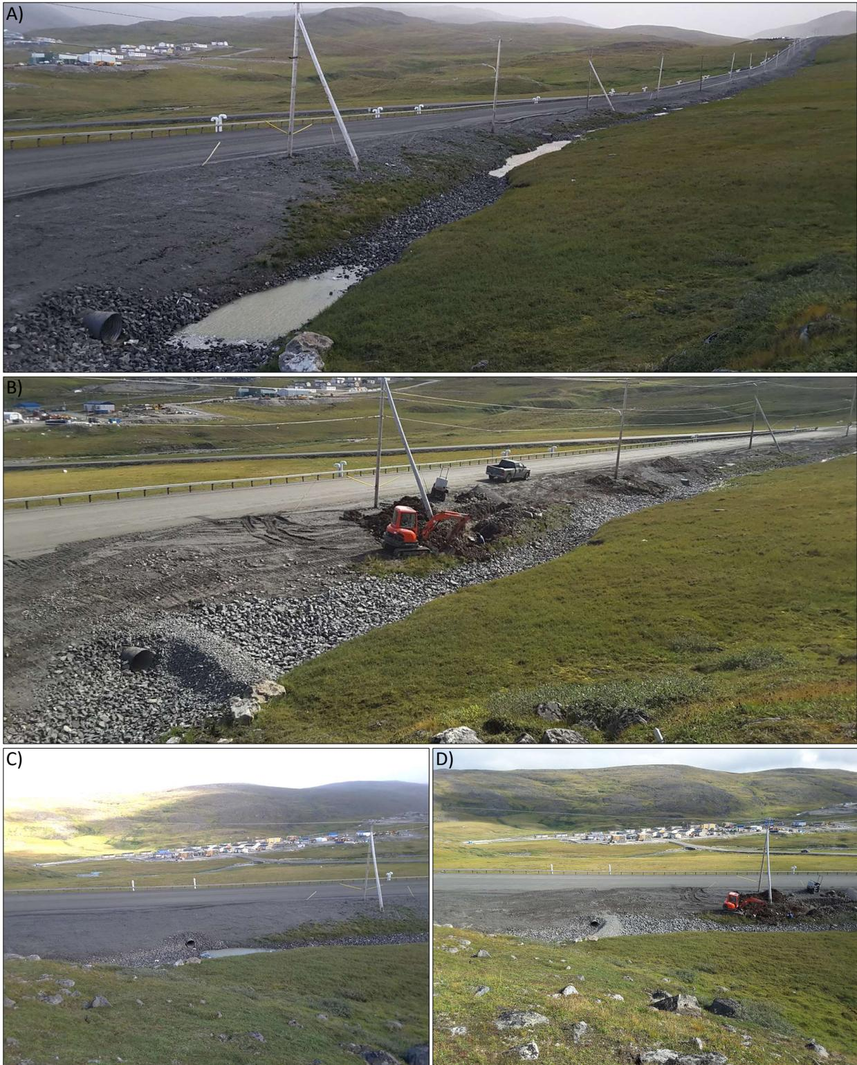
Figure 69 : Conditions du fossé de drainage sur le côté amont de la route d'accès à l'aéroport de Salluit avant (A et C) et après (B et D) les travaux correctifs de 2016 qui consistaient à reprofiler le fossé et mettre en place des bermes de déviation (Tirée de L'Hérault et Allard, 2016).
