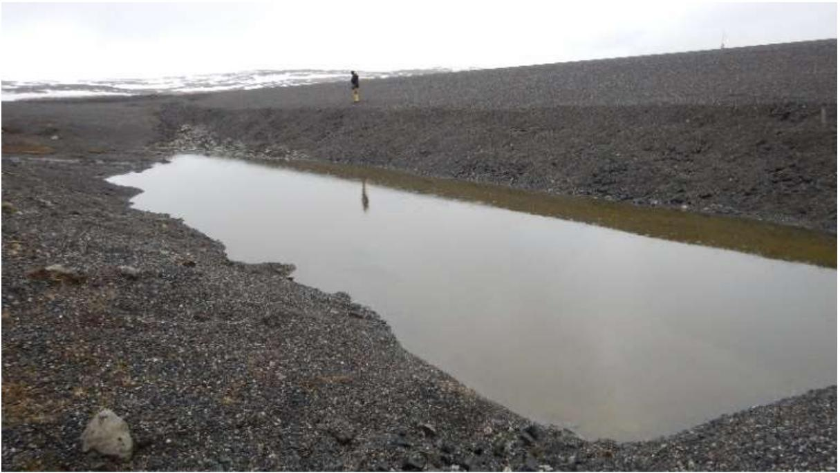
Figure 82 : Accumulation d'eau à la fin de la période de dégel (16 juin, 2015) pour la section de la pente douce tronquée située au sud du chemin d'accès à l'anémomètre, chaînage 1+940 à 2+000 m, piste d'atterrissage de Salluit.
