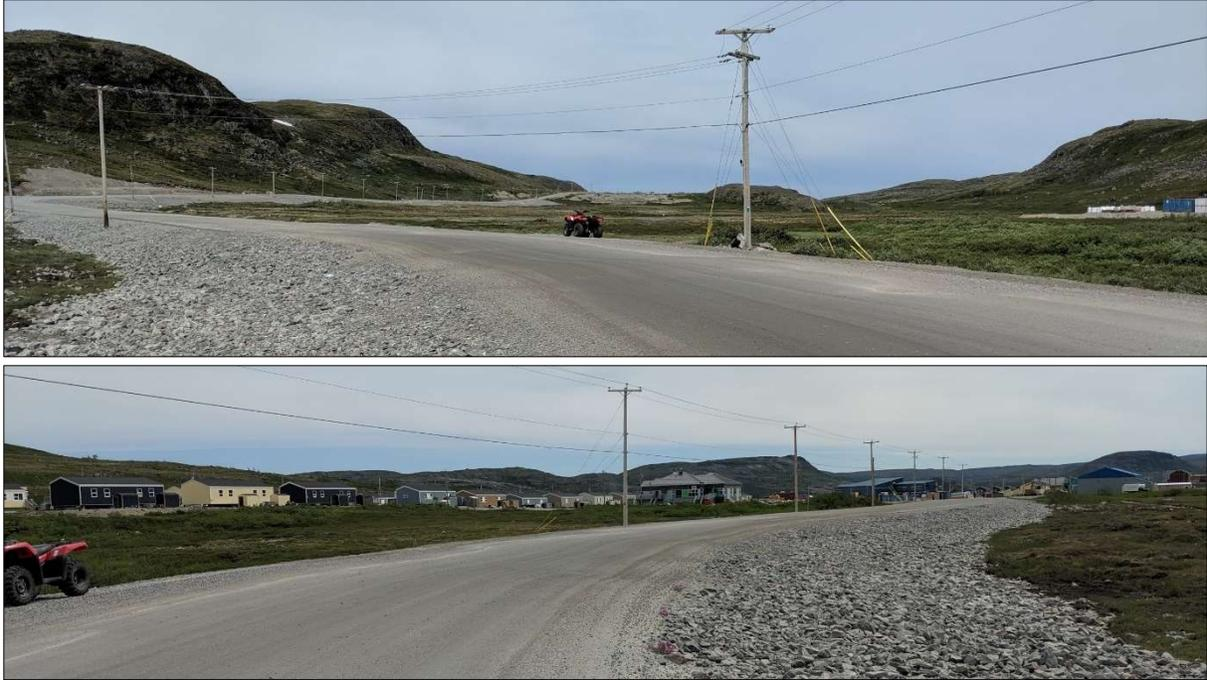
Figure 129 : Déformations affectant les sections de la route toujours pavées entre les chaînages 0+680 et 0+920 m telles qu'observées lors d'une visite sur le terrain effectuée à l'été 2019, route d'accès à l'aéroport de Kangiqsualujuaq.
