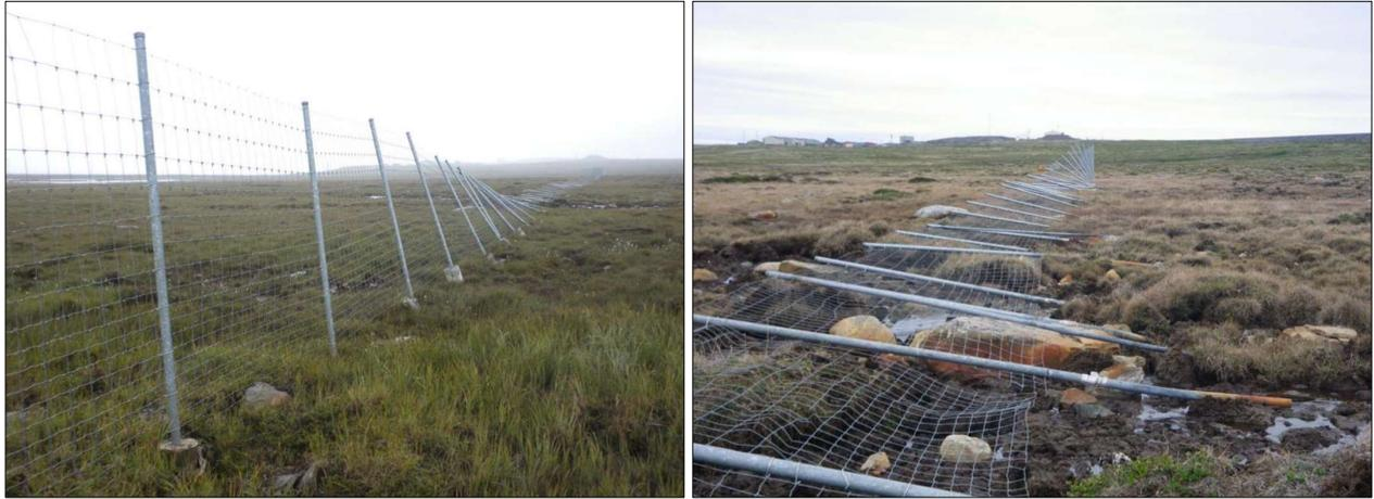
Figure 156 : Sections de clôture fortement endommagées par l'action du soulèvement gélival sur les fondations, Aéroport d'Aupaluk (source : MTQ, 2011-2012, devis 7202-13-3505).
