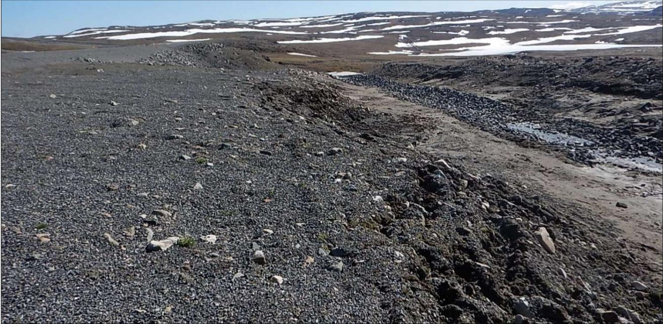
Figure 84 : Nombreuses fissures observées dans la section aval du fossé de décharge côté piste entre les chaînages 2+300 et 2+400 m (Source : MTQ, 2019).
