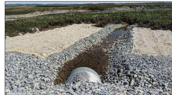
Figure 139 : Conditions de drainage le long de la route d'accès à l'aéroport de Tasiujaq, juillet-septembre 2019. Fossés (A et D) et embouchures ponceau côté amont (B et E) et aval (C et F).
