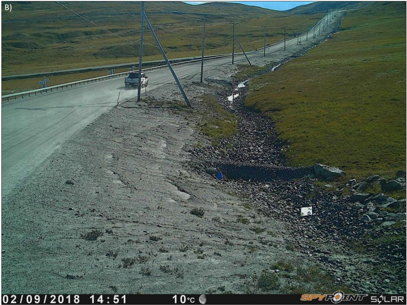
Figure 14 : A) Configuration d'un site pour le suivi des conditions de drainage le long d'un remblai à l'aide d'une caméra automatisée fixée sur un hauban de poteau électrique, route d'accès à l'aéroport de Salluit. B) Exemple d'une photographie prise par la caméra automatisée.
