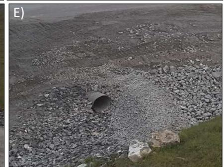
Figure 43 : Vue en coupe de la route d'accès à l'aéroport de Salluit avec pente douce (côté amont) et drain thermique (côté aval) tirée A) des plans de construction et B) des plans tel que construit. C.1, C.2 et C.3) Étapes d'installations du drain thermique avec cheminées de ventilation. D) Aperçu de l'infrastructure une fois les travaux complétés. E) Exemple d'une berme de déviation installée en 2016 dans le fossé de drainage à l'entrée d'un ponteau côté amont.
