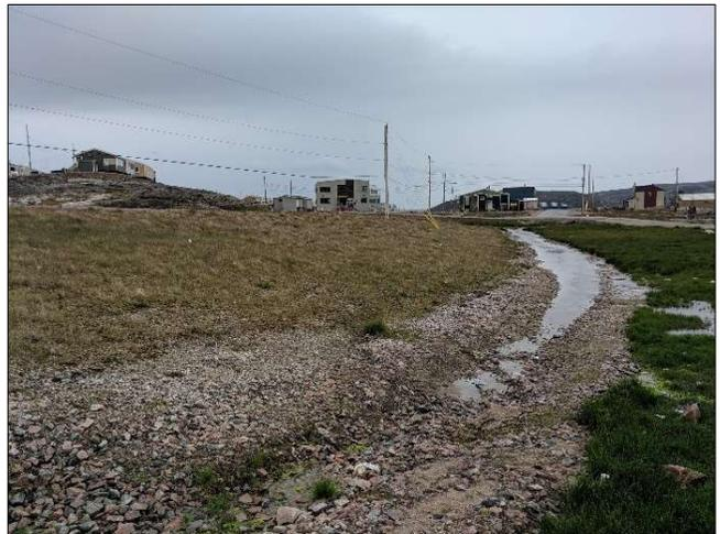
Figure 126 : Conditions de drainage dans le secteur 2 telles qu'observées le 20 juillet 2019. A) vue d'ensemble du côté droit (nord), B) fossé de drainage du côté droit (nord) et C) fossé de drainage du côté gauche (sud), route d'accès à l'aéroport d'Ivujivik.
