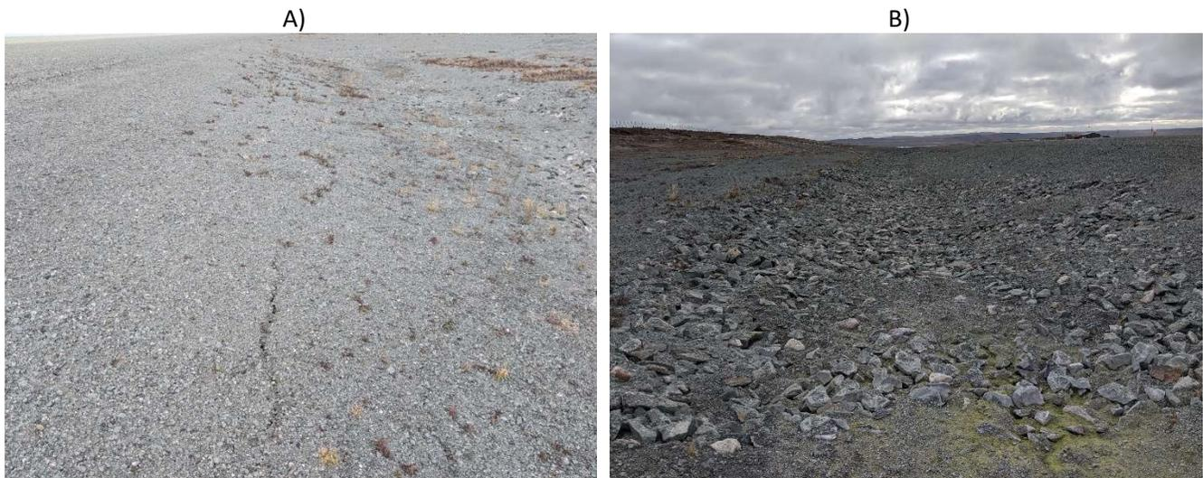
Figure 119 : A) Quelques fissures présentes sur les talus du remblai à une dizaine de mètres au sud de la berme côté est. B) Absence d'accumulation d'eau au fond des fossés qui témoigne de leur bonne efficacité à drainer l'infrastructure.
