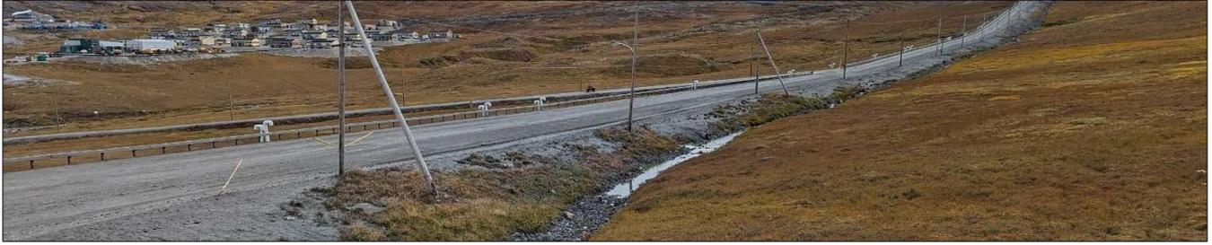
Figure 3 : Exemple d'intégration de plusieurs techniques de mitigation contre le dégel du pergélisol le long de la route d'accès à l'aéroport de Salluit et qui forment une stratégie d'adaptation.
