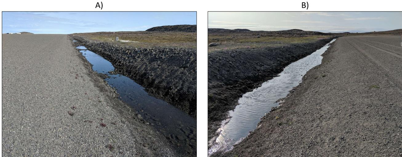
Figure 114 : Accumulations d'eau qui persistent dans les fossés au courant de l'été entre les chaînages 1+600 m et 1+830 m. A) Vue vers le nord et B) vue vers le sud.
