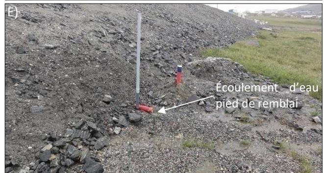
Figure 67 : Section de la route d'accès à l'aéroport de Salluit présentant des problèmes de drainage. A), B), C) et D) Accumulations d'eau côté amont associées à un mauvais drainage. E) Écoulement d'eau en pied de remblai côté aval (Modifiée de L'Héroult et Allard, 2016).
