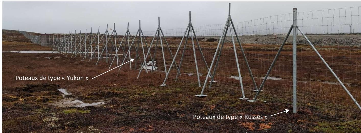
Figure 159 : A) Aperçu général des sections de clôtures adaptées mises en place autour de la piste d'atterrissage d'Inukjuak et B) utilisant les deux types de poteaux « Yukon ».
