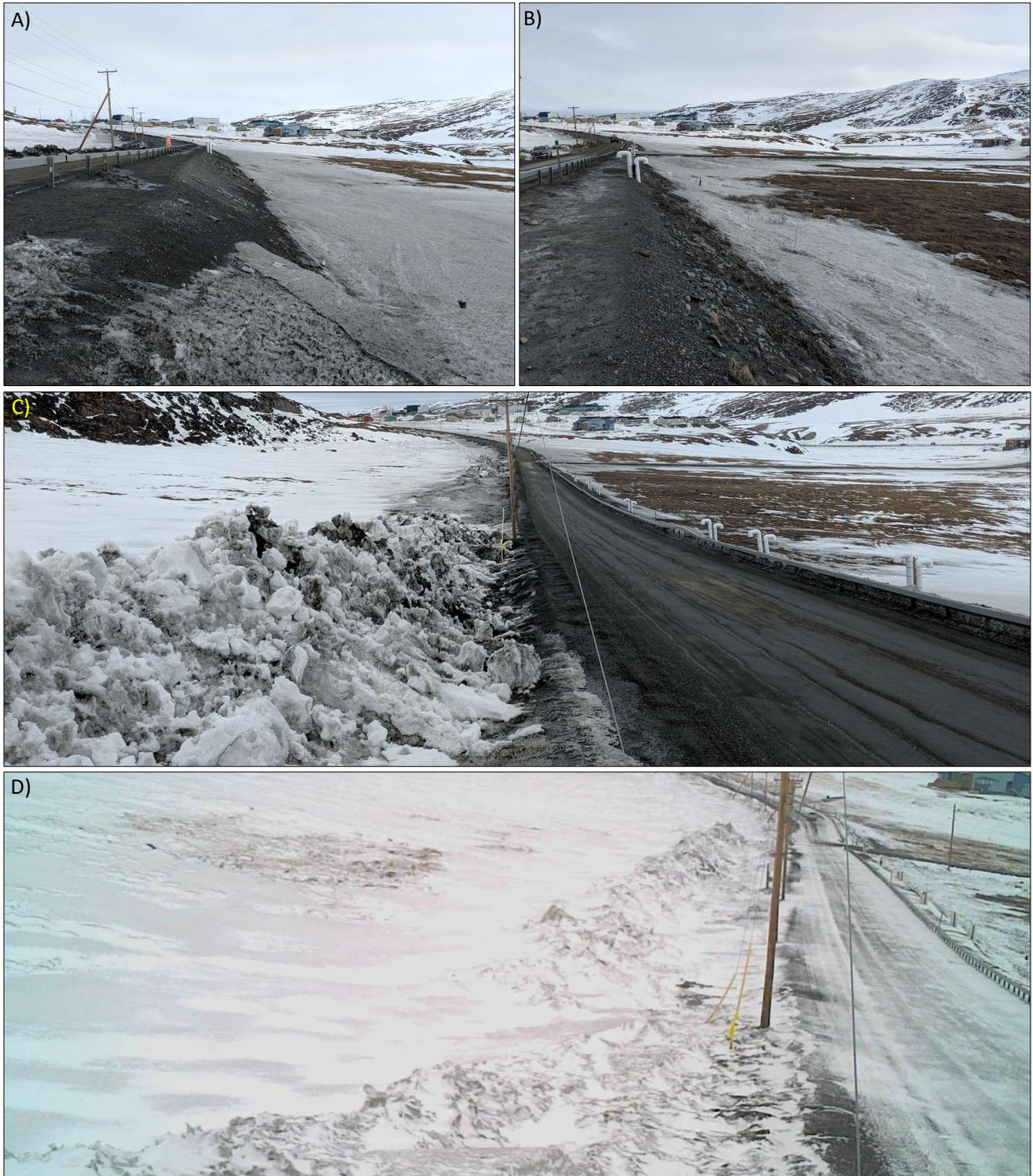
Figure 64 : A) Conditions d'enneigement le long de la route d'accès à l'aéroport de Salluit en date du 9 mai 2019 A) SalCam-3, B) SalCam-4 et C) SalCam-2. D) Conditions d'enneigement le long de la route du côté amont (pente douce) observées à la fin de l'hiver 2019-2020.
