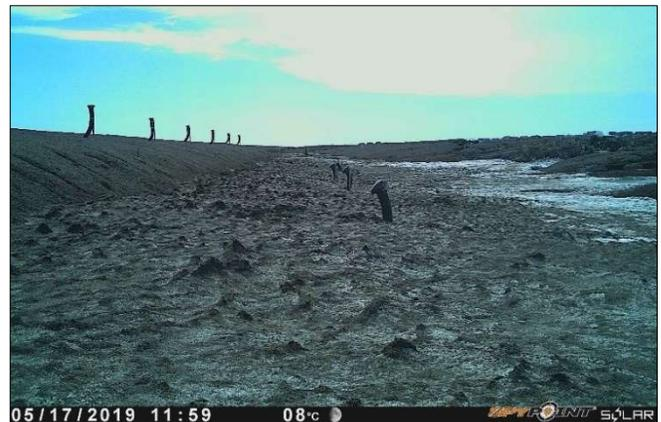
Figure 38 : Accumulation d'eau importante en pied de remblai côté amont (ouest) survenue au printemps 2019 entre B) le 15 et C) le 16 mai, puis D) rapidement drainé par le fossé de drainage excavé dans le roc, piste d'atterrissage de Puvirnitug.
