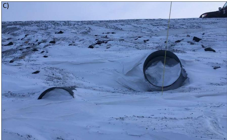
Figure 66 : Relation entre épaisseur de neige en marge de l'infrastructure et la distance du pied de remblai (Source : Geneviève Trudel, février 2020). Photos B) d'une cheminée d'entrée d'air du système à convection et C) d'un ponceau double bouchés par de la neige (Source : Yves Pilotte, février 2020).
