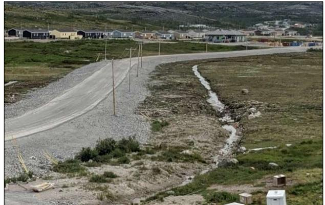
Figure 130 : État des fossés latéraux localisés à une distance des pieds de remblai du côté droit (nord-est) et gauche (sud-ouest) un an après (2017) et trois ans après (2019) leur mise en place.
