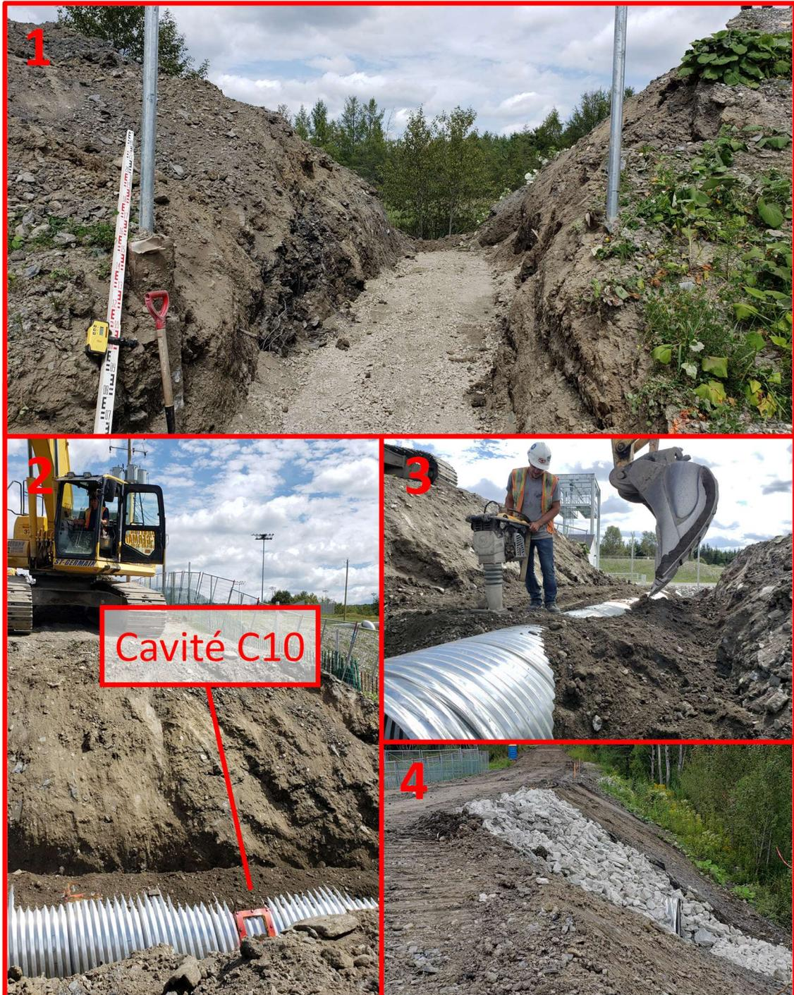
Figure 3.4: Les différentes étapes de l'exécution du ponceau 2.
