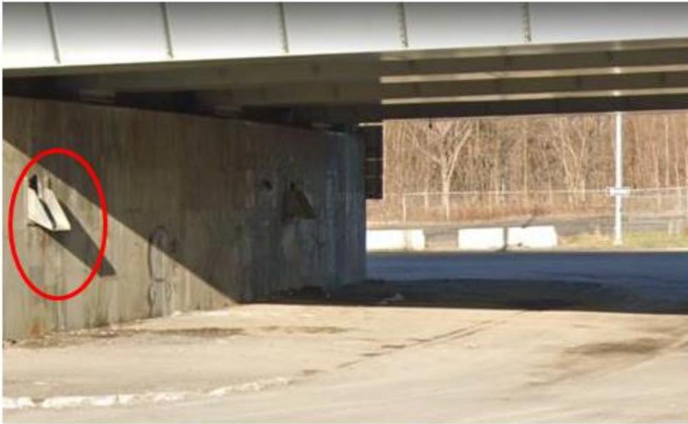
**Figure 8 : Drainage des culées creuses du pont Charles-De Gaulle**
