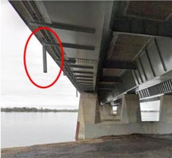
**Figure 7 : Drainage du tablier du pont Charles-De Gaulle**
