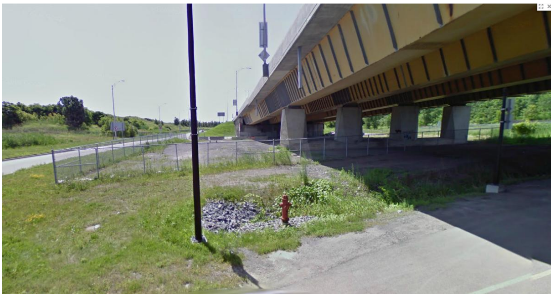
Photo 11 : Présence d'une borne d'incendie et de lampadaire d'éclairage près du pont Charles-de-Gaulle, intersection boulevard Gouin et bretelle, photo Google
