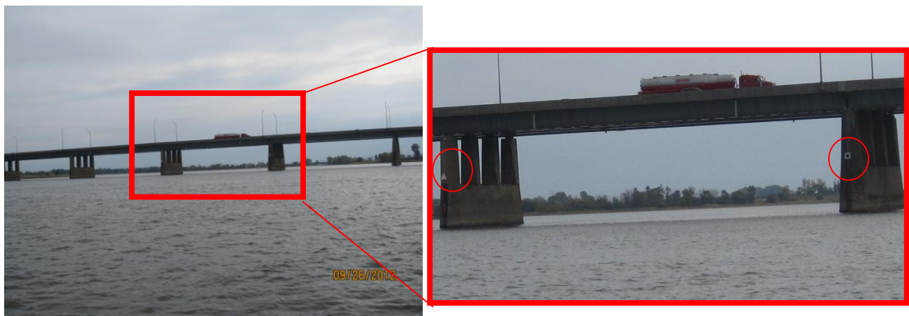
Photo 6 : Chenal maritime assurant la circulation maritime sous le pont Charles-de Gaulle
