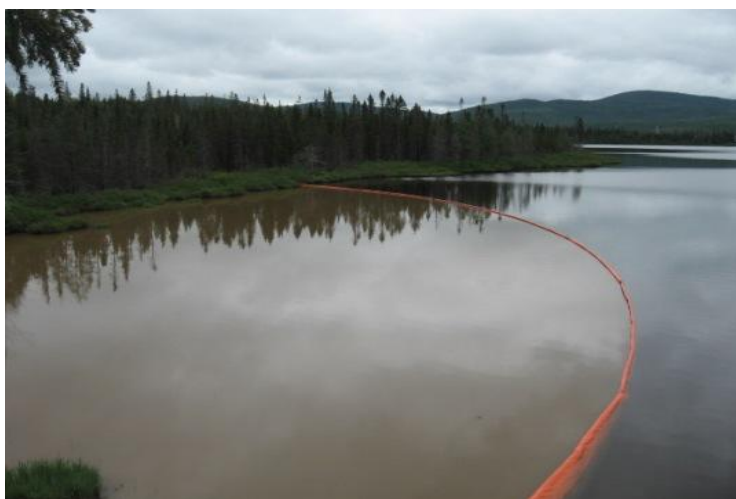
Photo 15 : Efficacité d'un rideau de turbidité source (octobre 2012)
