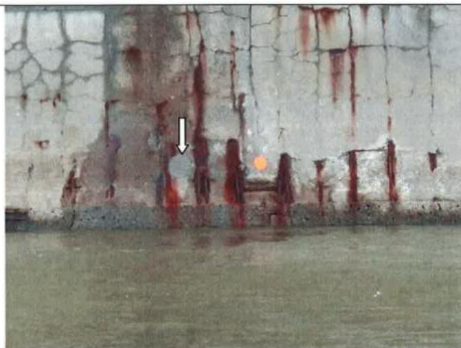
La flèche montre approximativement l'emplacement où la carotte C-4 a été prélevée.
