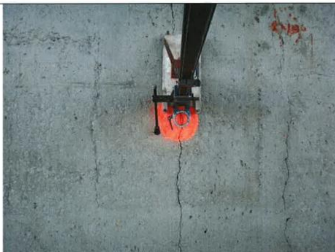
Base de la carotteuse installée à l'emplacement où la carotte C-3 a été prélevée.
