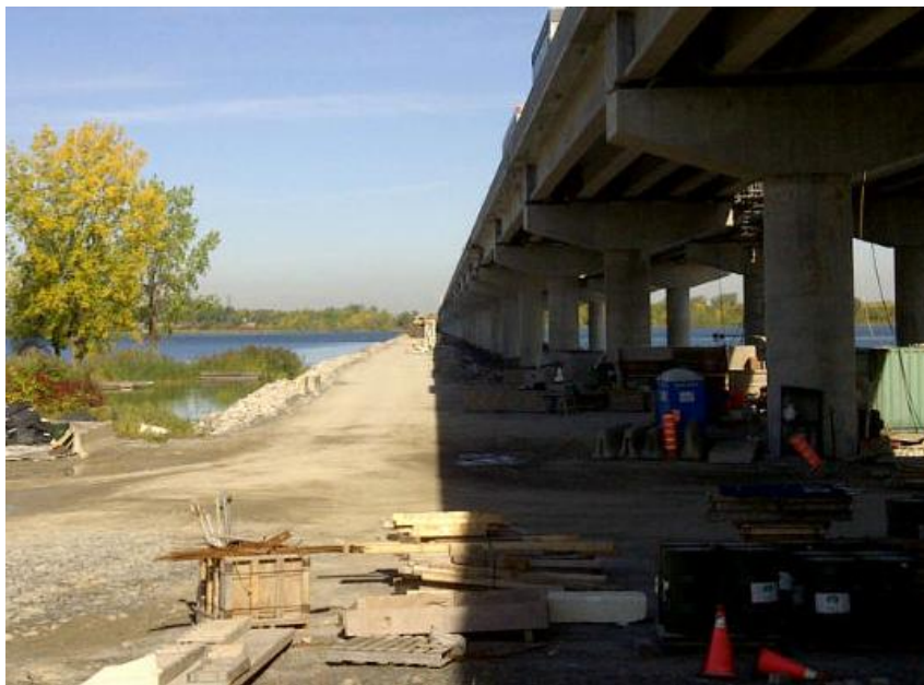
Photo 4 : Batardeau en digue de matériaux granulaire utilisé lors de la construction de la nouvelle Autoroute 30
