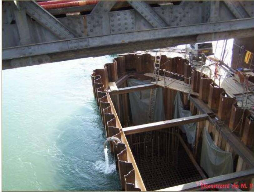
Photo 5 : Batardeau de palplanche, source (octobre 2012)
