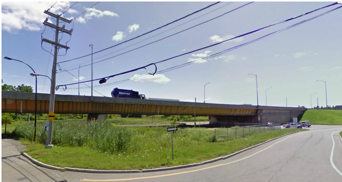
Photo 13 : Position de la ligne électrique de distribution Hydro-Québec par rapport au pont Charles-de-Gaulle, intersection boulevard Gouin et bretelle, photo Google
