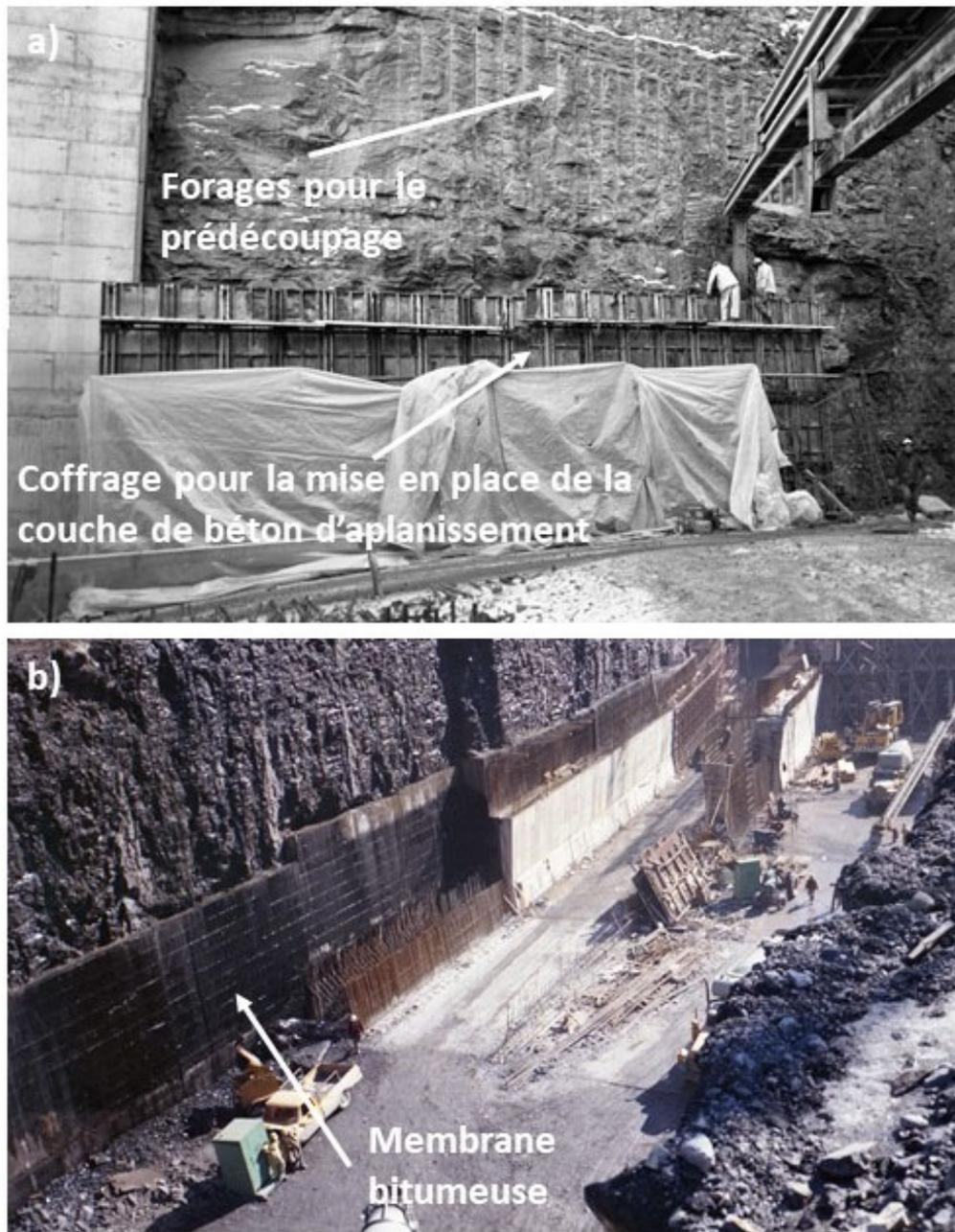
Figure 10 Exemples de béton utilisé pour aplanir la surface du roc (a) et de membrane bitumeuse (b).
