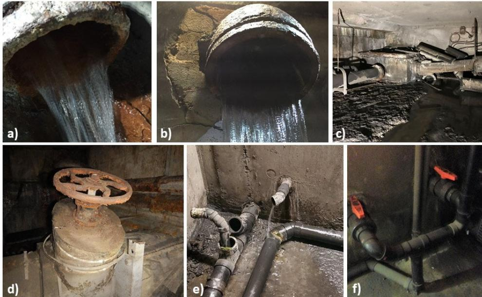
**Figure 28** Percements utilisés pour drainer la tranchée du tunnel, a) percement principal pour le sud de la voie B (37+70), b) percement principal pour le nord de la voie B (37+70), c) puits de raccordement des percements de la voie B au réseau de drainage du tunnel (37+70), d) vanne du percement de la voie B (37+70), e) percement secondaire à l'est de la cathédrale (22+19), f) percement secondaire près de la tour 12 (51+62).
