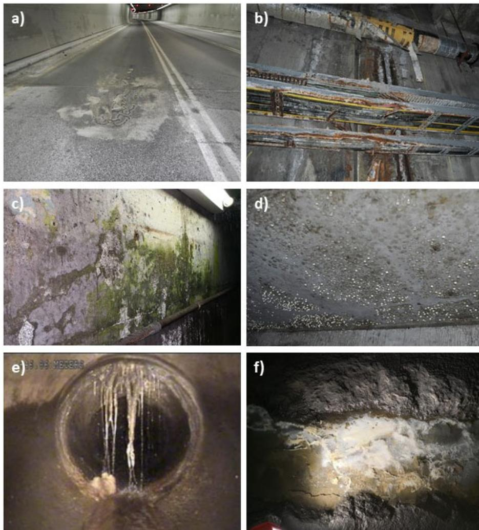
**Figure 20** Exemples de problèmes associés aux infiltrations d'eau dans le TVM a) soulèvement de chaussée et formation de plaque de glaces b) corrosion des équipements, c) moisissures (couloir d'évacuation, chainage 56+00), d) condensation (couloir d'évacuation, chainage 56+00), e) précipitation de calcaire (conduite de drainage, chainage 29+00), f) précipité inconnu (plénium de ventilation de la voie B, chainage 37+70).
