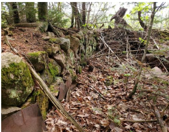
Figure 62 : Secteur 22, fondation de pierres des champs avec mortier, vers le sud
