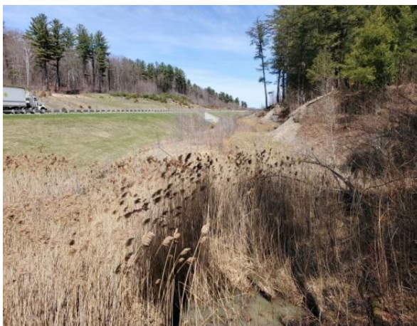
Figure 36 : Secteur 12, sol naturel au-dessus de l'autoroute, coupé par un banc d'emprunt, vers le nord-est
