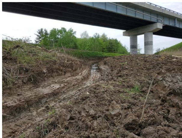
Figure 85 : Secteur 31, tranchée récente de drainage, vers le sud-ouest
