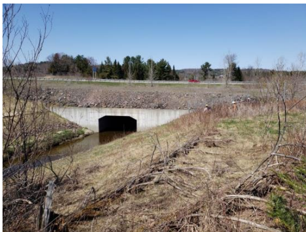
Figure 43 : Secteur 15, aménagement important des berges du ruisseau et ponceau en béton, vers le nord
