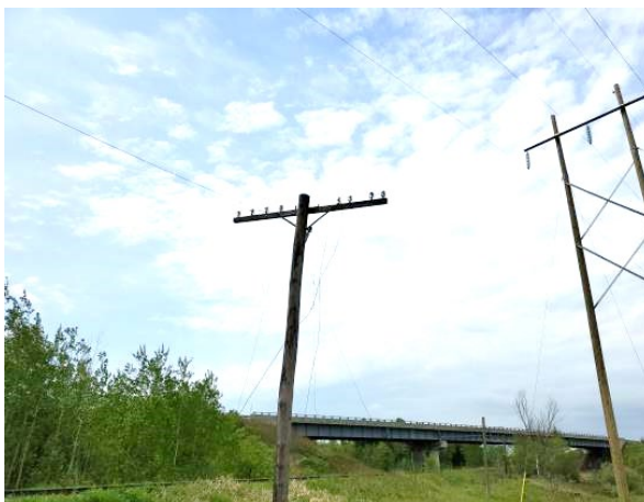
Figure 84 : Secteur 31, poteau de télégraphe, vers le sud-ouest
