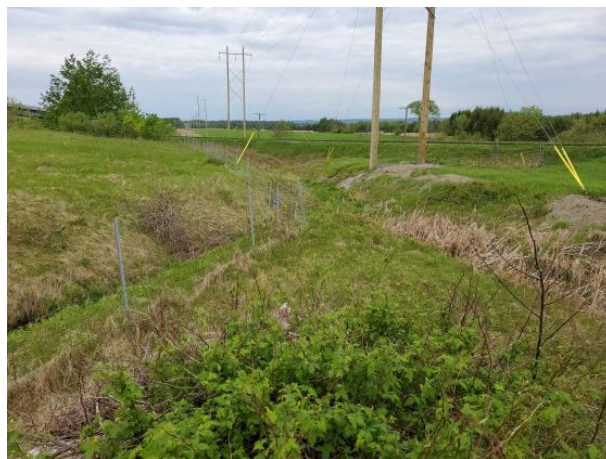
Figure 87 : Secteur 32, tranchée de drainage agricole, vers l'ouest
