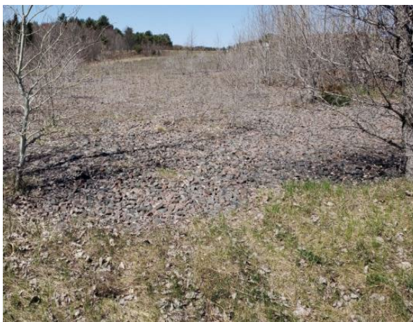
Figure 44 : Secteur 15, bloc rocheux sur ponceau, vers l'ouest
