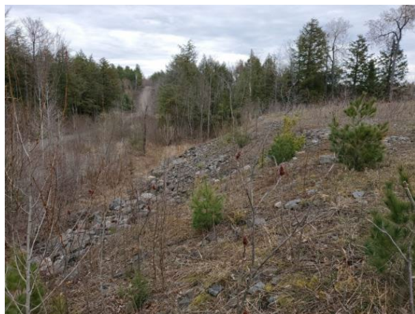
Figure 7 : Secteur 1, remblai de plusieurs mètres d'épaisseur, vers l'est
