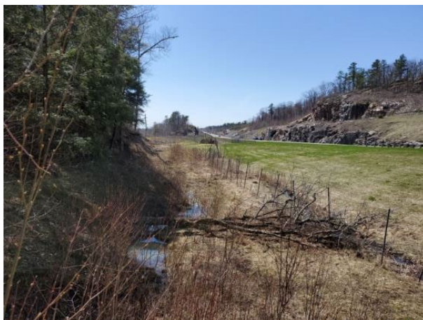
Figure 37 : Secteur 12, sol naturel au-dessus de l'autoroute, avec dynamitage et coupé par un banc d'emprunt, vers le sud-ouest
