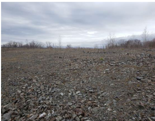
Figure 6 : Secteur 1, remblai nivelé, vers le sud-ouest
