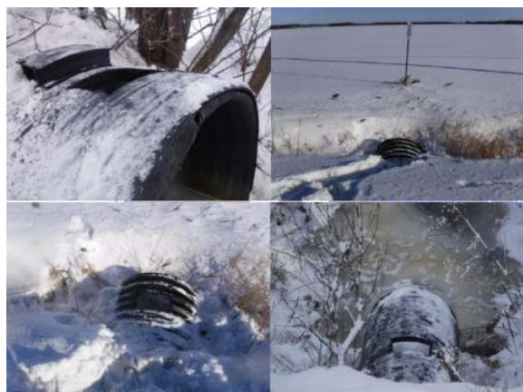
Figure 51: Tuyaux PEHD en service sur le terrain au Québec
