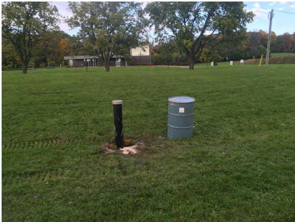
**PHOTO 6** Aménagement d'un puits d'observation dans le forage 20PO3.
