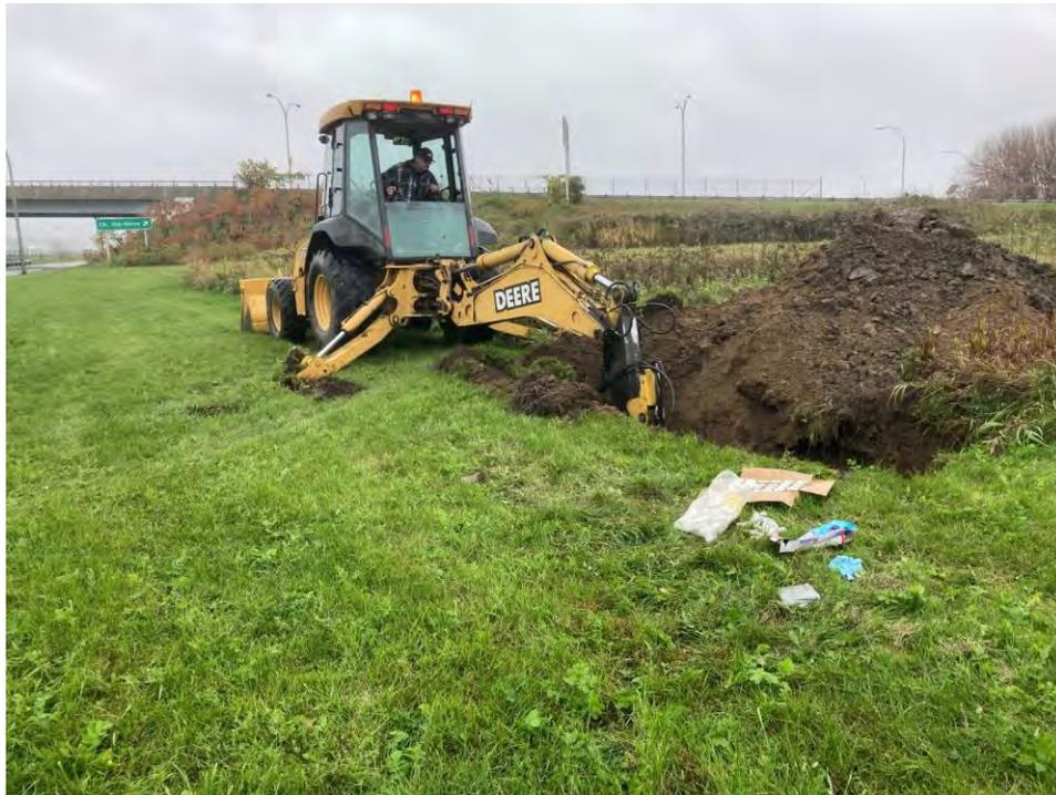
**PHOTO 10** Réalisation de la tranchée d'exploration 20TR01.
