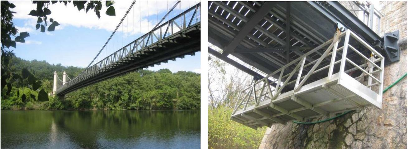
Figure 13.01 : Exemple de nacelle de visite accrochée sous le tablier
