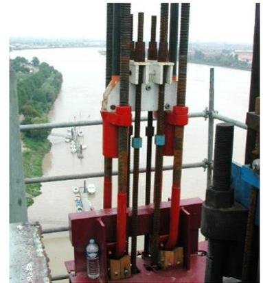
Figure 12.20 : Transfert de charges en pied de suspente
