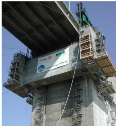
Figure 12.19 : Poutre d'ancrage rive gauche en cours de hissage
