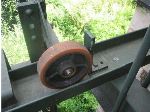
Figure 13.07 : Exemple de galet plat roulant dans un profilé en I disposé à plat
