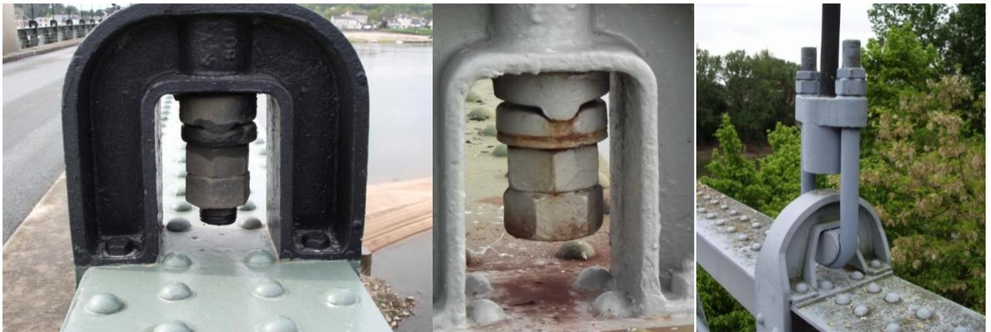
Figures 5.87 à 5.89 : Autres exemples d'attaches basses de suspentes
