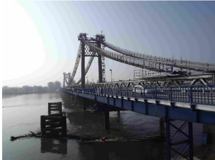
Figure 1.201 : Tablier du pont du Teil posé sur palées pendant le changement de sa suspension
