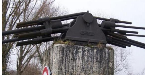
Figures 5.36 à 5.39 : Câbles interrompus au droit des pylônes
