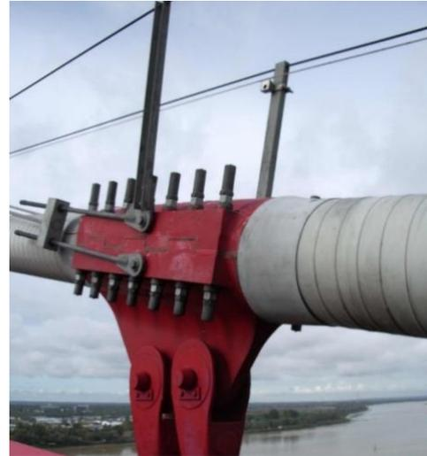
Figure 5.80 : Attache supérieure du pont d'Aquitaine
