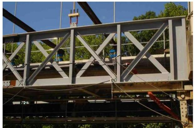
Figures 6.05 à 6.07 : Exemples de ponts avec poutres triangulées : le pont de Tournon et le pont de Serrière
