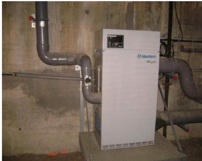
Figure 9.05 : Exemple de déshumidificateur
