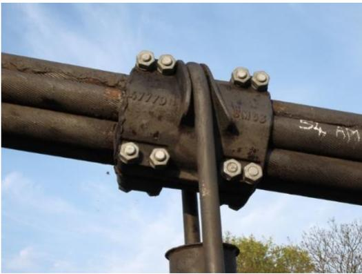
Figure 5.12 : Faisceau de 7 torons
