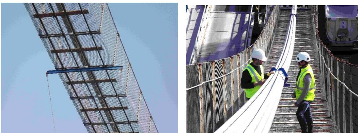
Figures 12.16 et 12.17 : Exemple de passerelle provisoire de travail
