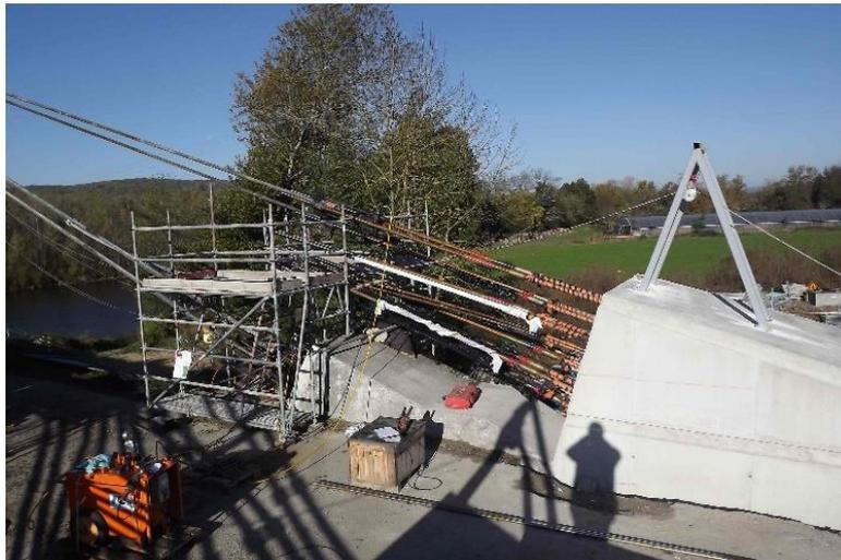
*Figure 12.02 : Le pont de Carennac pendant le changement de sa suspension*
