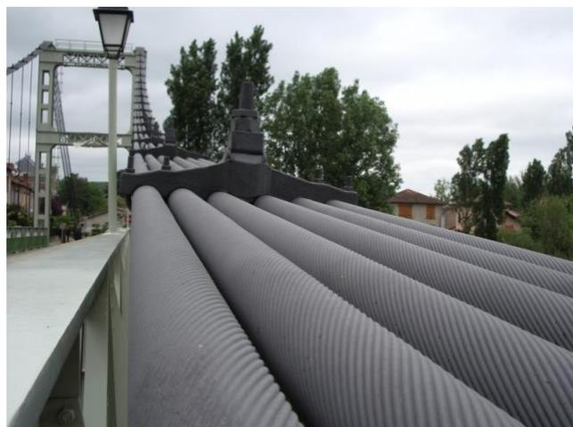
Figure 5.19 : Nappe de six câbles
