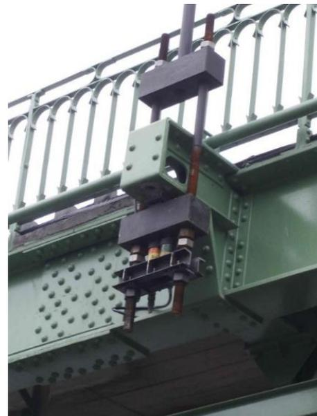
Figure 12.11 : Exemple de dispositif de transfert de charges
