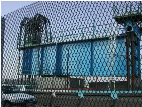
Figure 12.18 : Poutre de hissage de la poutre d'ancrage rive gauche
