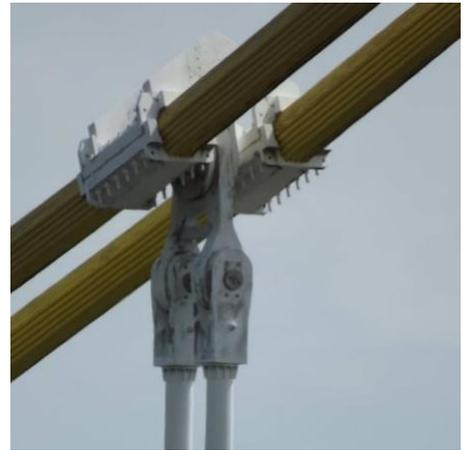
Figures 5.70 à 5.75 : Attaches supérieures de suspentes réalisées par serrage de torons en couronne
