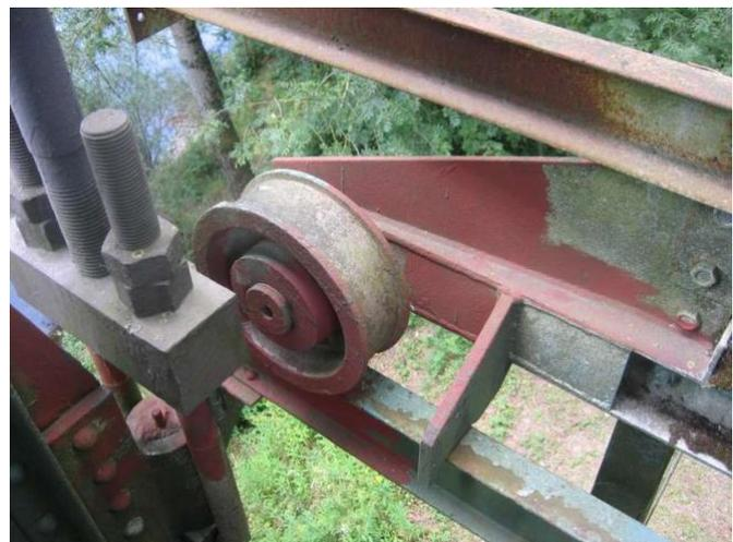
Figures 13.05 et 13.06 : Exemples de galets avec gorges roulant sur un profilé en I
