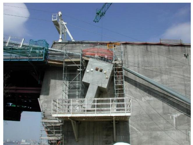
Figures 12.21 à 12.24 : Lançage des nouveaux câbles du pont d'Aquitaine
