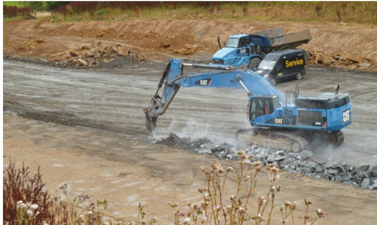
Les moyens utilisables pour agir sur la granularité sont variés : pétardage, concassage, utilisation d'engins spéciaux tels que rouleaux à pieds « dameurs », chenillage avec de gros bouteurs, fragmentation à l'aide de marteaux ou burins hydrauliques, etc.
