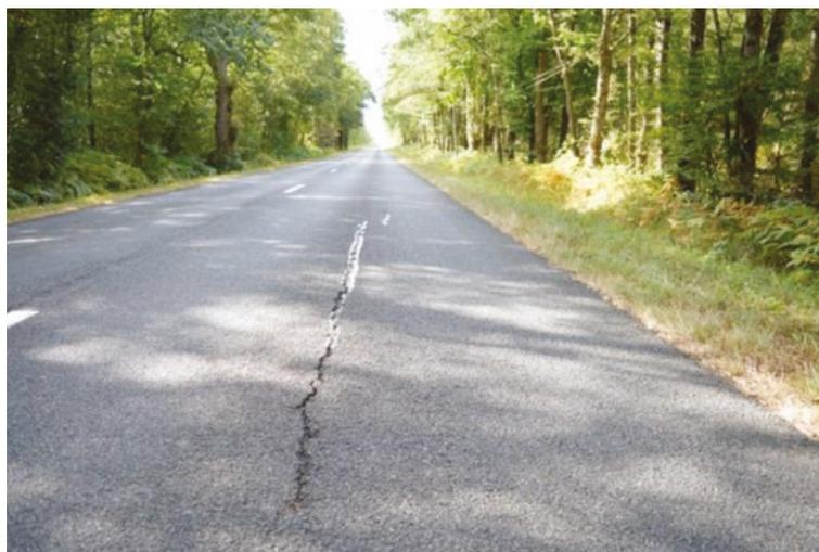
Avec le changement climatique et le renforcement des situations extrêmes, il est vraisemblable que la plage hydrique actuelle des sols s'élargisse et que l'amplitude et la fréquence des déformations liées à ce phénomène augmentent, entraînant une aggravation des désordres.
