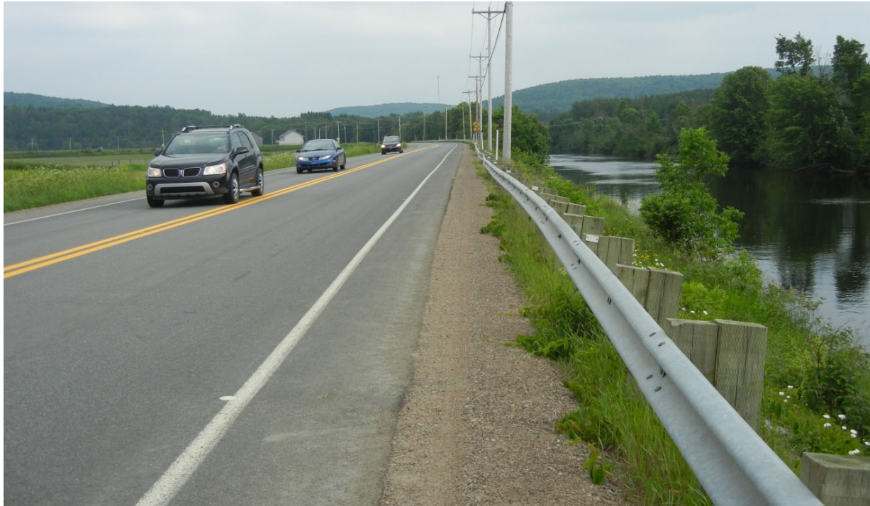
Photo 4-3 : Vue des usagers de la route 349 dans l'unité de paysage bâti agricole A1
