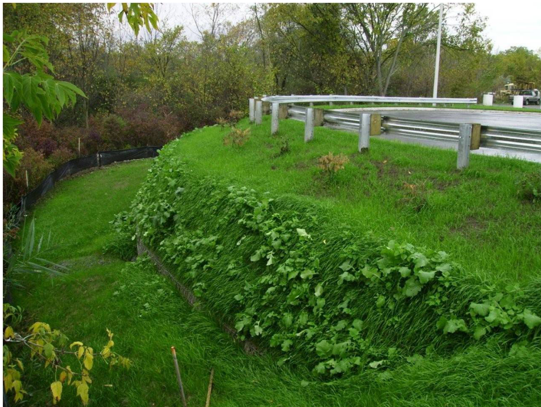
Photo 3-4 : Système de remblai renforcé
