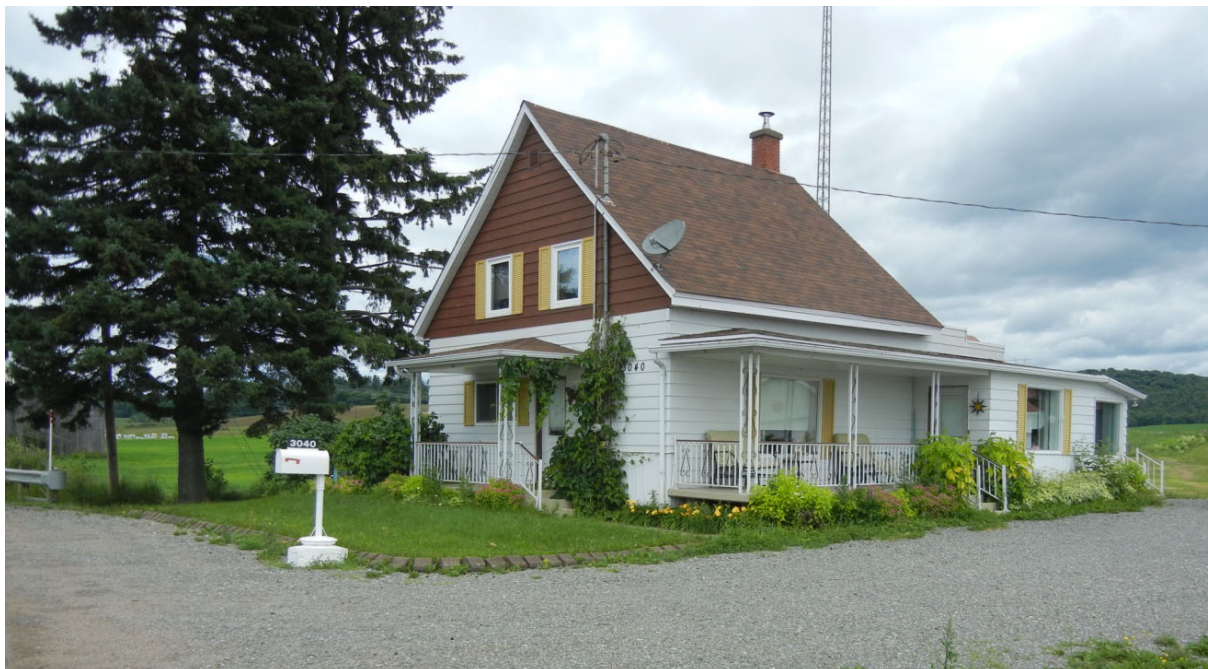
Photo 4-1 : Résidence faisant partie de l'unité de paysage bâti Agricole A1
