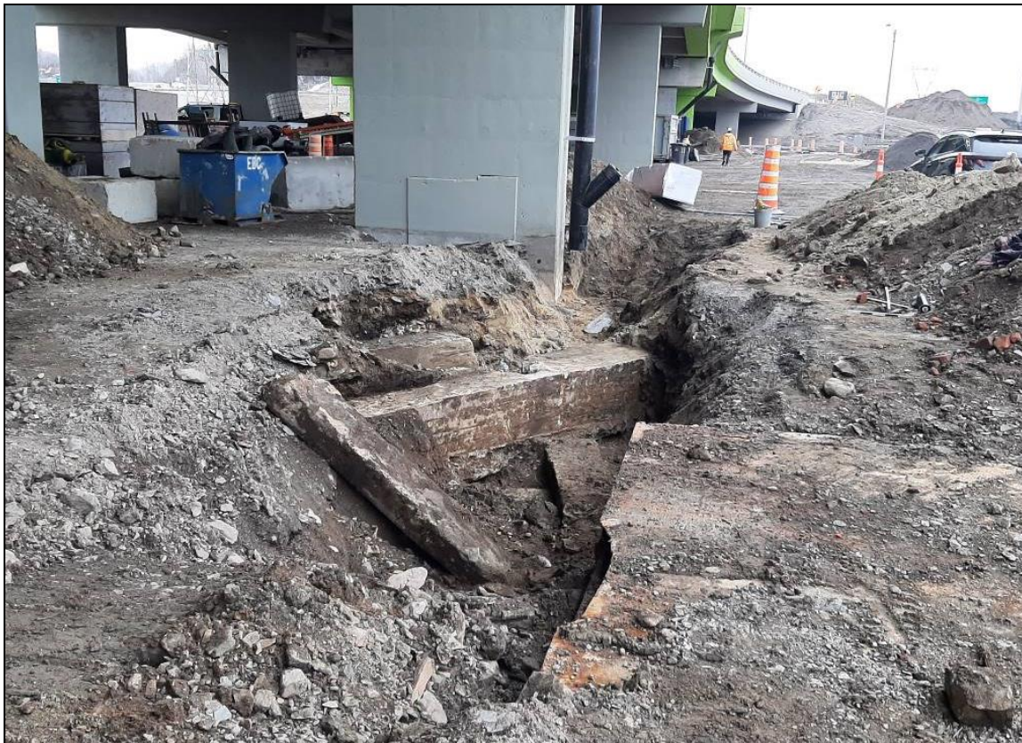
Photo 21. Vue d'ensemble de la zone 1B, vers l'est (MTQ-154-16-0429-2022-216)
