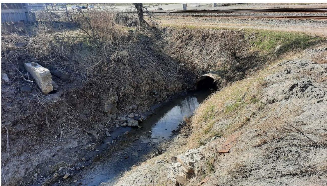
Photo 029 : Vestige 6, vue vers le nord-ouest. Fossé du CN
