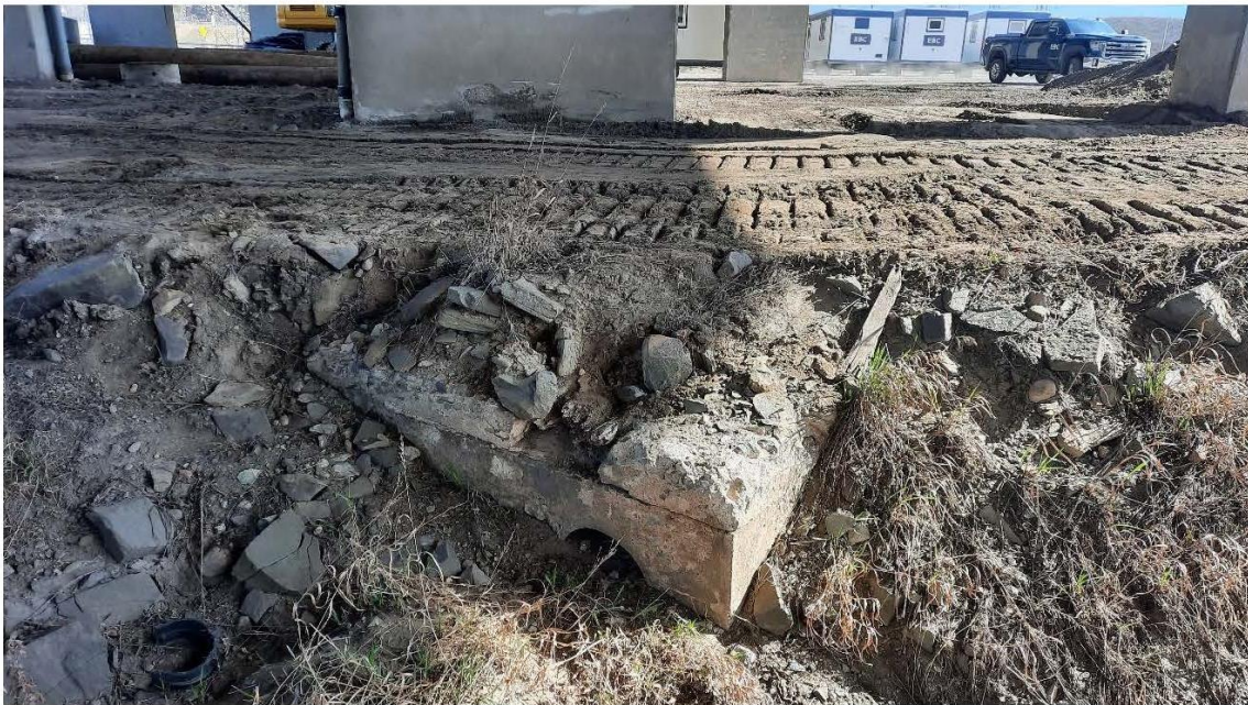
Photo 008 : Vestige 3, vue vers le sud. Massif de béton avec un drain d'environ 30 cm à l'ouest du vestige 2 dans la paroi sud du fossé sous le viaduc.
