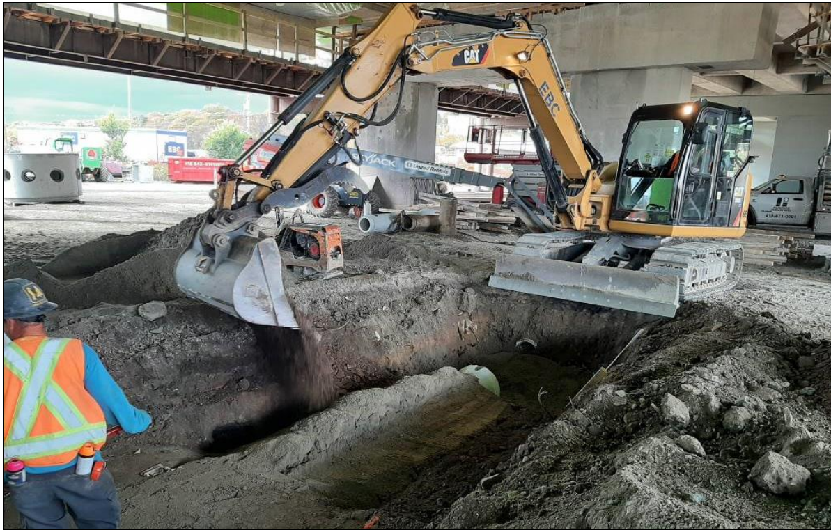
Photo 2. Vue d'ensemble de la zone 1A en cours d'excavation, vers le sud-est (MTQ-154-16-0429-2022-072)
