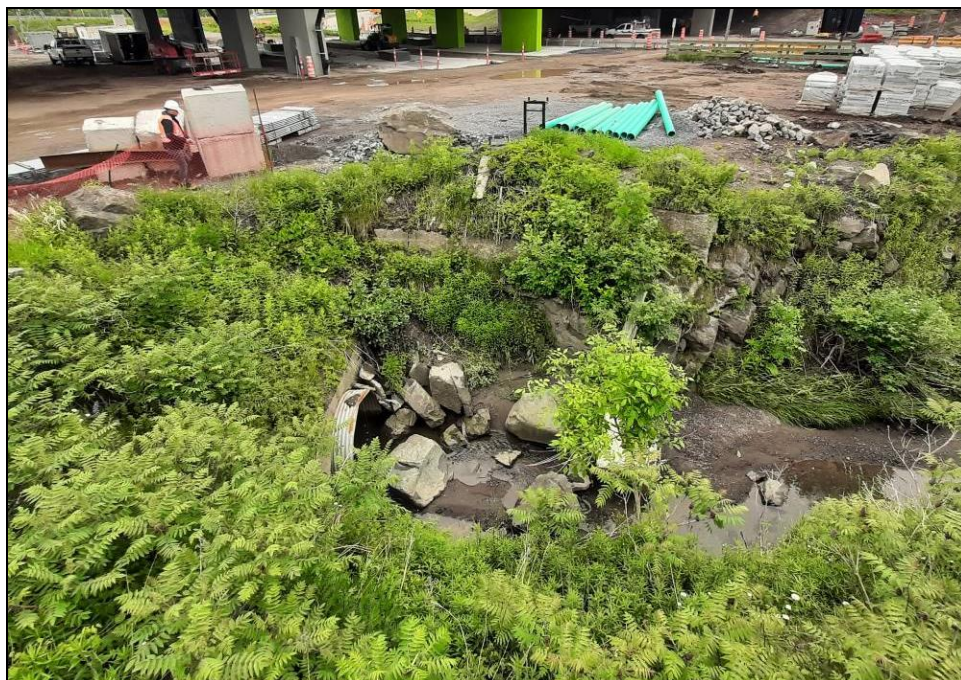
Photo 32. Vue d'ensemble du fossé situé au sud-ouest du secteur d'intervention (zone 1D), vers le nord-est (MTQ-154-16-0429-2022-255)
