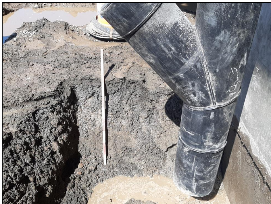
Photo 12. Séquence des remblais observés sur les vestiges bétonnés mis au jour dans la zone 1A, vers le nord (MTQ-154-16-0429-2022-079)
