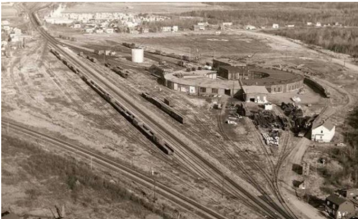
Figure 14. Vue d'ensemble de la rotonde Joffre de Charny construite au cours des années 1880 (Charny – Les vieilles gares du Québec; patrimoinequebec.com)
