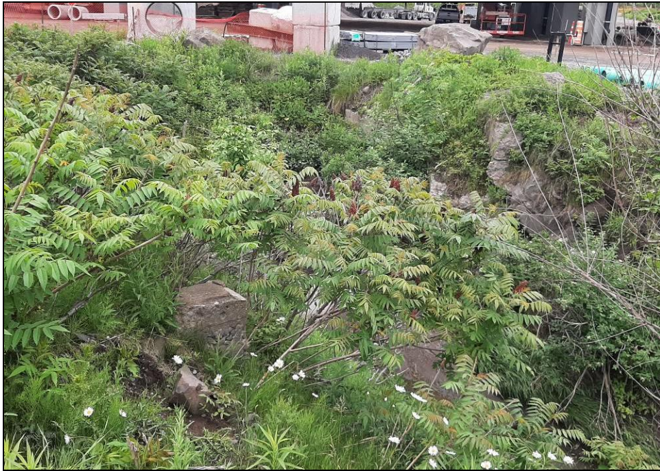
Photo 33. Vue d'ensemble du fossé situé au sud-ouest du secteur d'intervention (zone 1D), vers le sud-ouest (MTQ-154-16-0429-2022-263)
