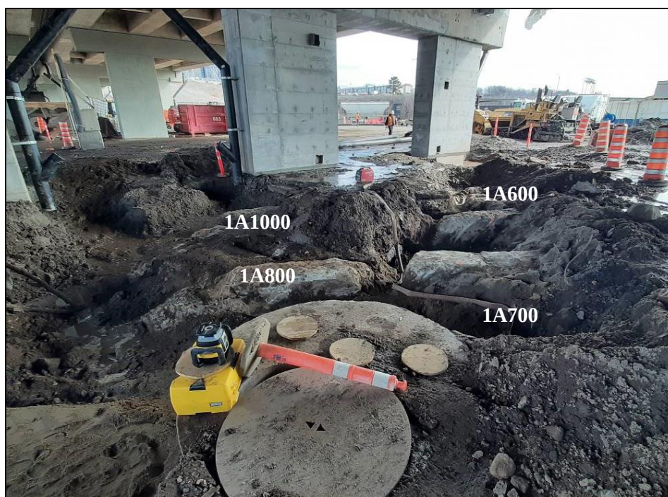
Photo 13. Vue d'ensemble des vestiges bétonnés 1A600, 1A700, 1A800 et 1A1000 mis au jour dans la zone 1A, vers le nord-est (MTQ-154-16-0429-2022-181)
