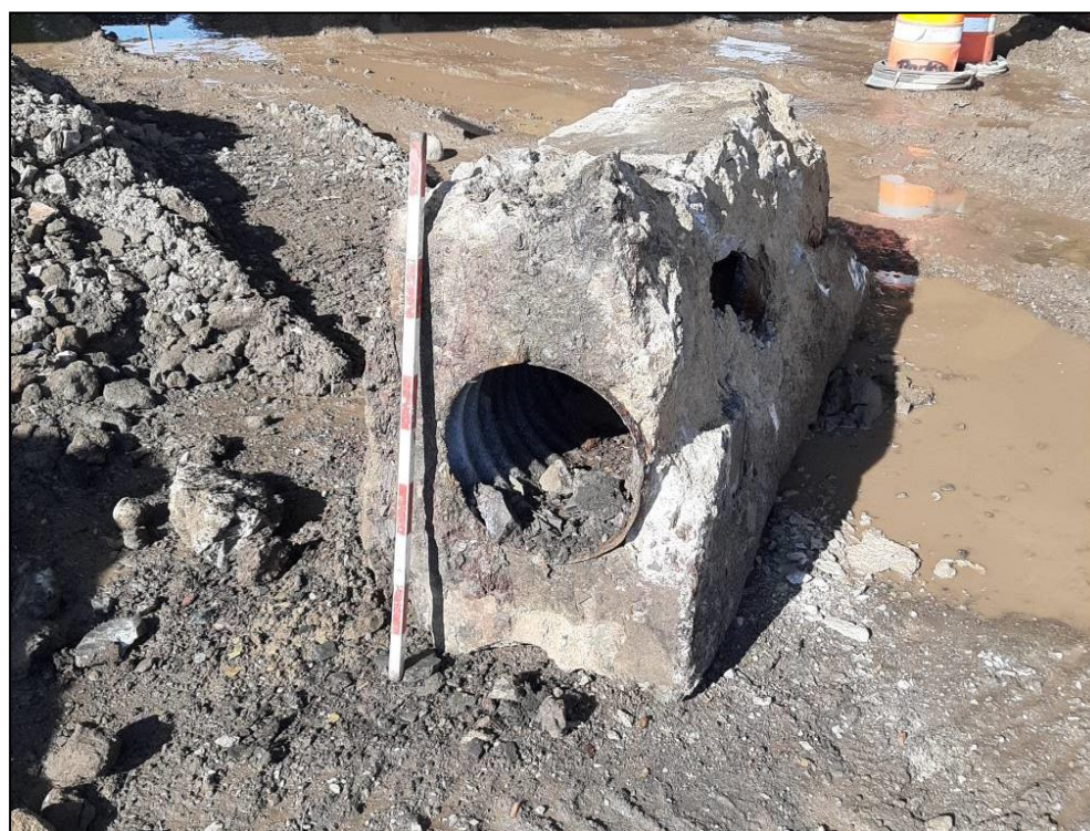
Photo 20. Conduite de drainage en acier présente dans un des vestiges bétonnés mis au jour dans la zone 1A (MTQ-154-16-0429-2022-194)
