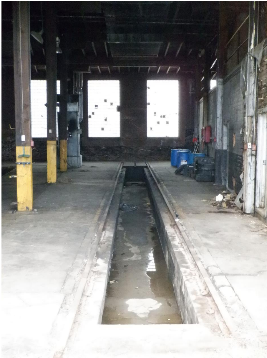
Figure 28. Photographie montrant un puits de mécanicien ( stalle ) de la rotonde de Vallée-Jonction construite en 1917 et qui est demeurée en fonction jusqu'en 2007 (Photo : Catherine Dupont, MTMD)
