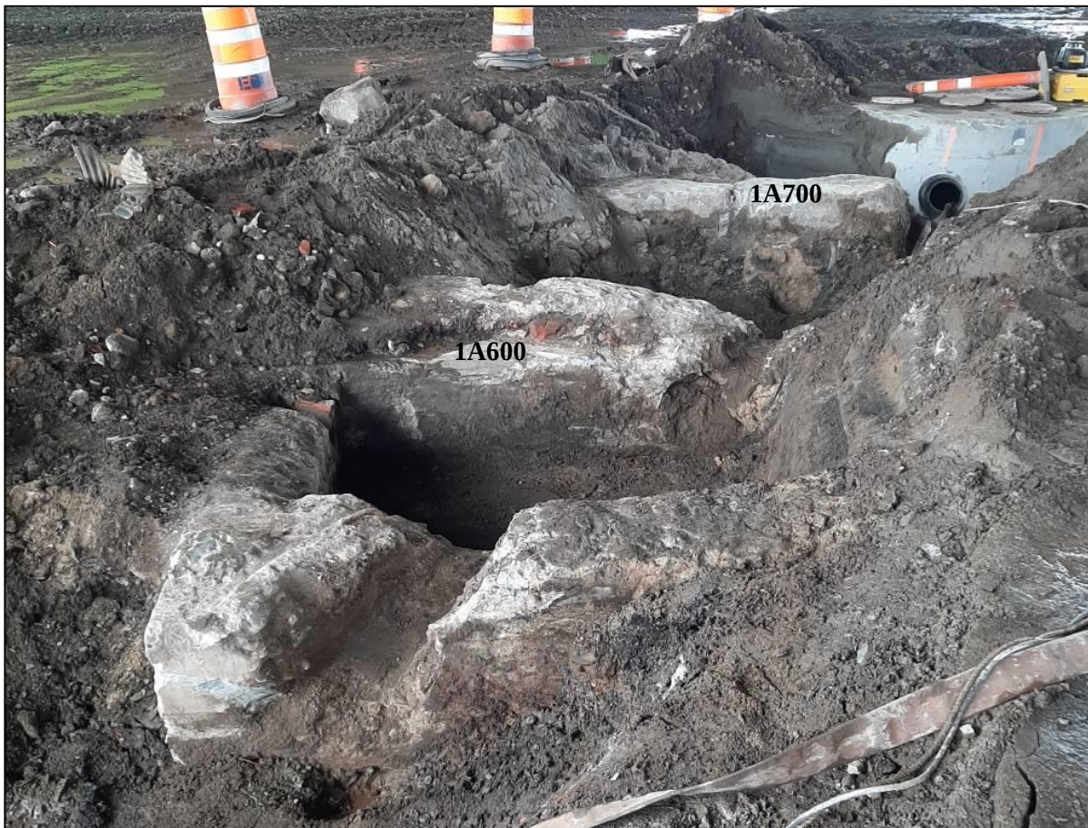
Photo 14. Vue d'ensemble des vestiges bétonnés 1A600 et 1A700 mis au jour dans la zone 1A, vers le sud-ouest (MTQ-154-16-0429-2022-095)
