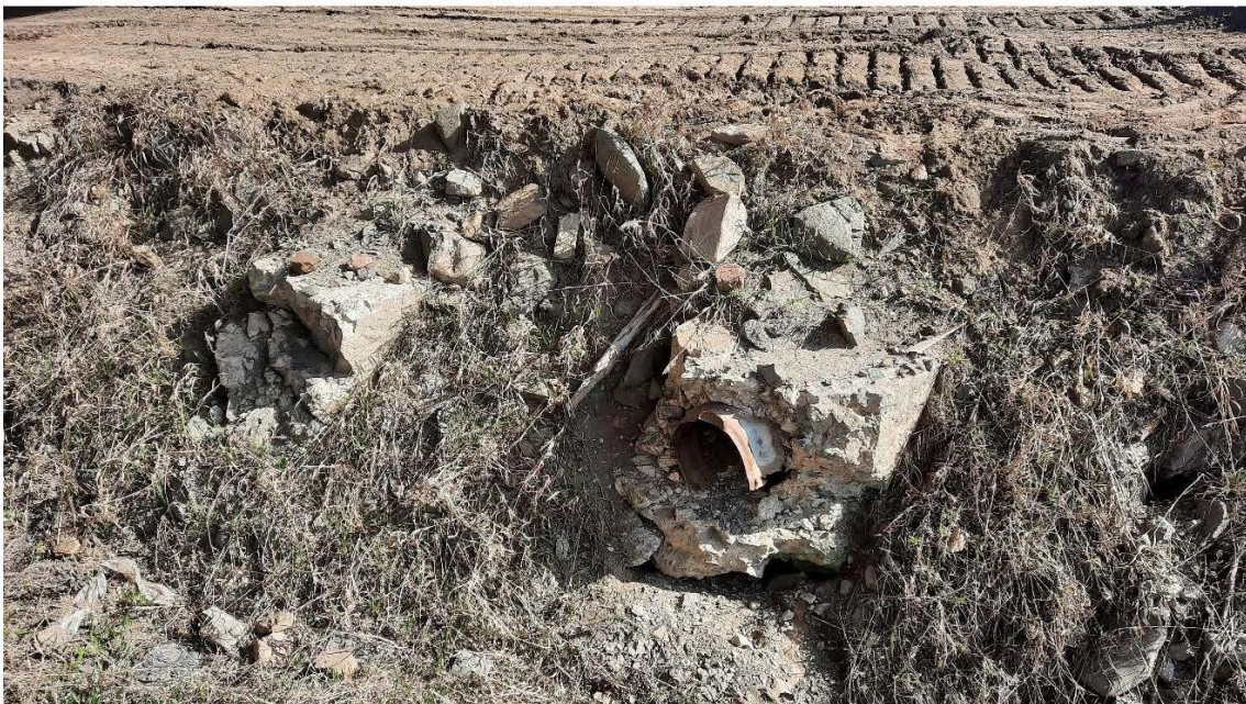
Photo 009 : Vestiges 4 et 5, vue vers le sud. Mur perpendiculaire au fossé et massif de béton avec drain en tôle ondulée de plus de 45 cm de diamètre dans la paroi sud du fossé sous le viaduc.
