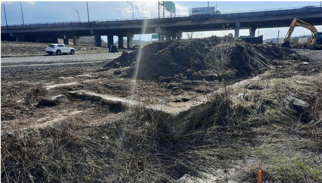
Photo 003 : Vestige 1, vue vers l'ouest-sud-ouest. Prémsumé vestige du magasin des pièces
