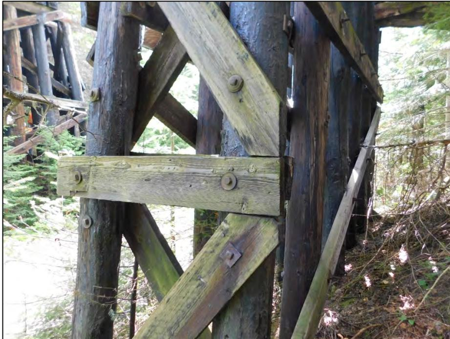
*Figure 18. Finition esthétique des contreventements sur le pilier double de la structure P-17352.*
