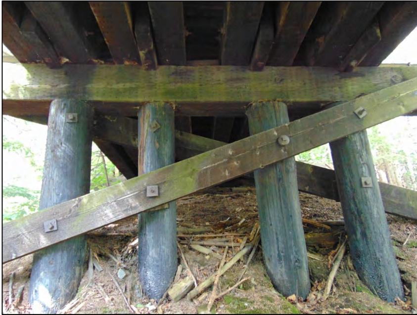
*Figure 14. Poutres inférieures du tablier et madriers verticaux appuyés sur un chevêtre.*
