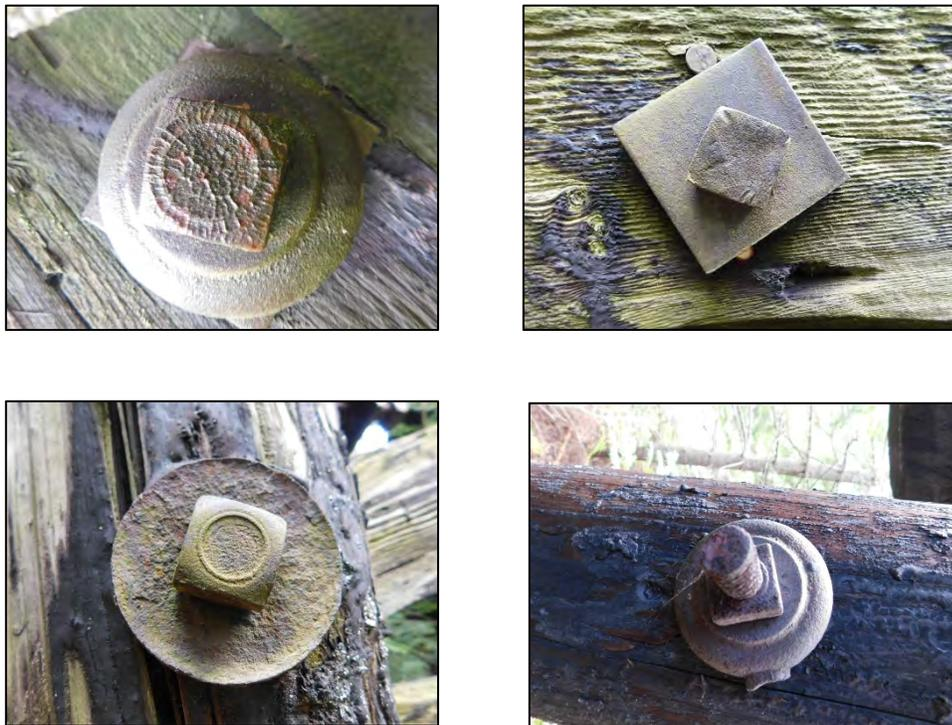
Figure 16. Types de boulons de serrage observés dans la partie inférieure de la structure P-17352.
