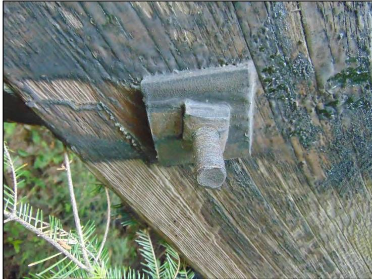
Figure 30. Coulée de goudron sur un boulon. L'angle horizontal témoigne de la rotation du boulon.
