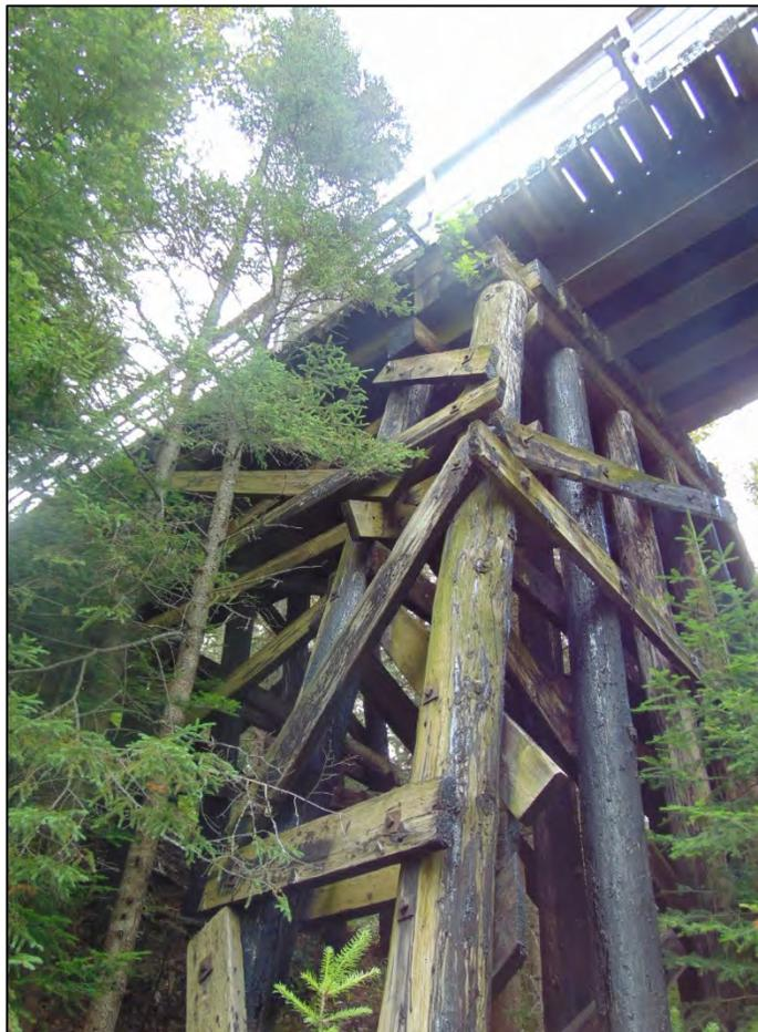
Figure 10. Premier pilier composé de deux rangs de piles.
