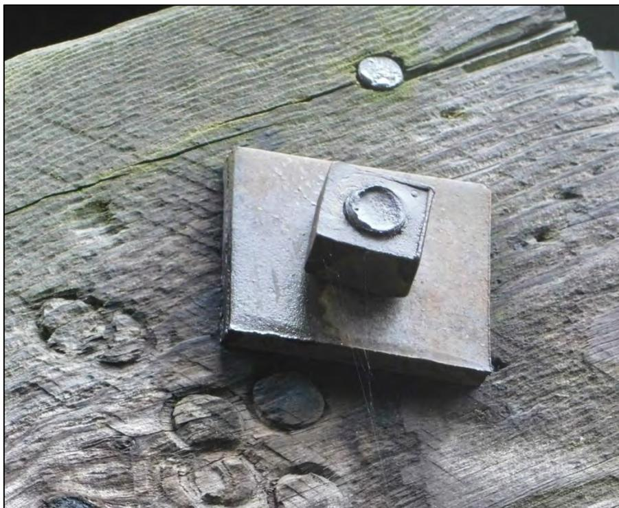
Figure 20. Exemple de fixation des contreventements préalable au boulonnage.
