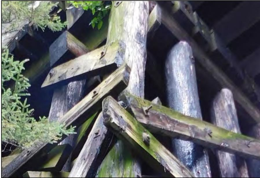
Figure 19. Finition sans souci d'esthétique sur l'un des piliers double de la partie inférieure.
