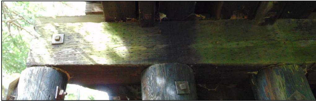
*Figure 26. Détail de la partie supérieure des piles coupées et ajustées au chevêtre à l'aide de colle et de cales. Notez également les incisions générées par le processus d'injection.*
