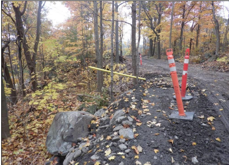
Photo 1. Portion du secteur inventorié rehaussée pour permettre la circulation de la machinerie lourde, vers l'ouest (MTQ-154-16-0429-2023-007)
