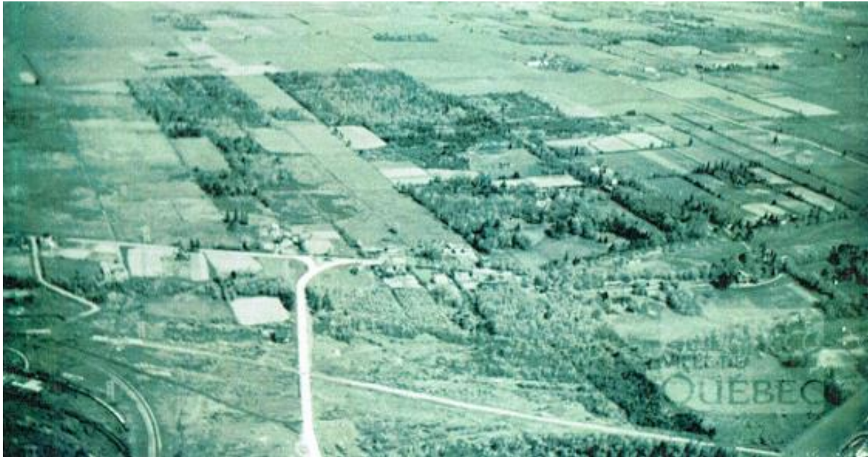
Figure 11. Photo aérienne montrant une partie de l’emprise globale du projet vers le milieu du XX e siècle (AVQ)
