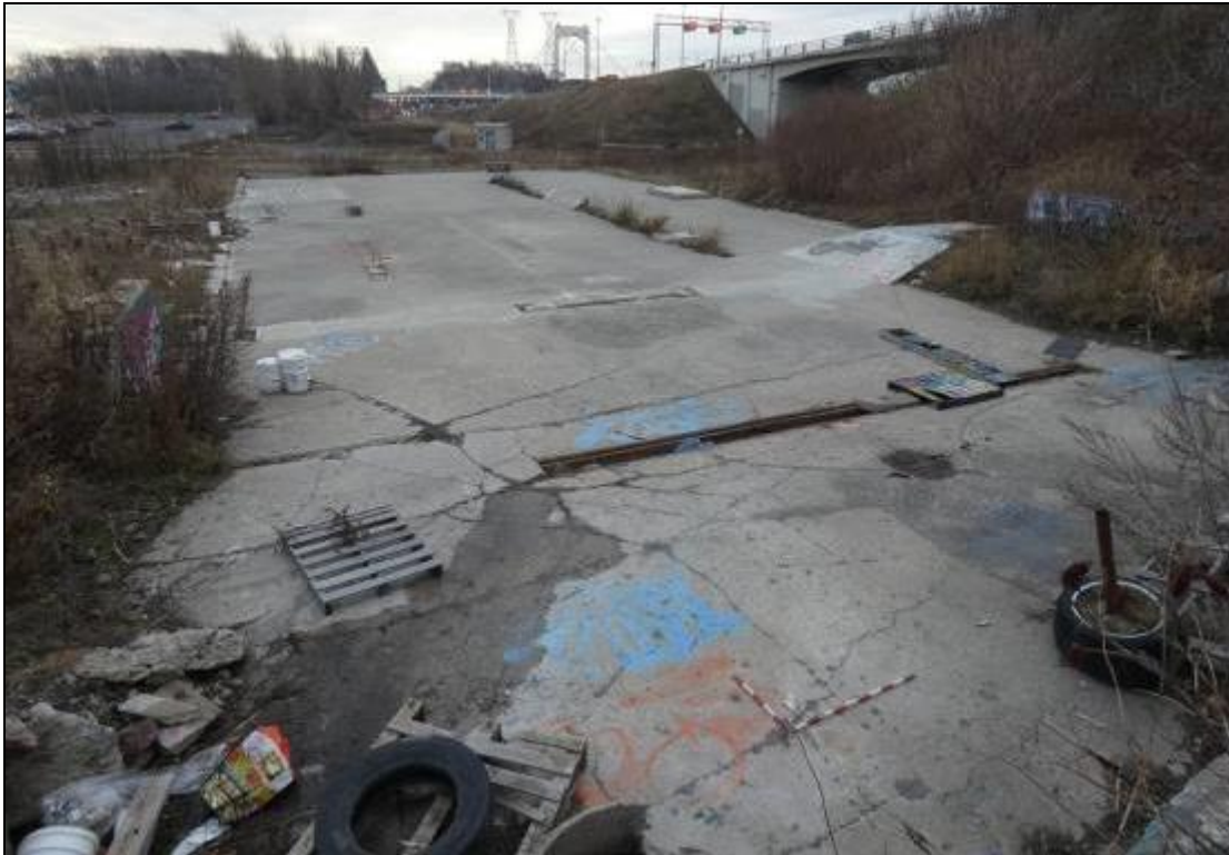
Photo 16. Vue générale du planchodrome, vers le sud (MTQ-154-16-0429-355)
