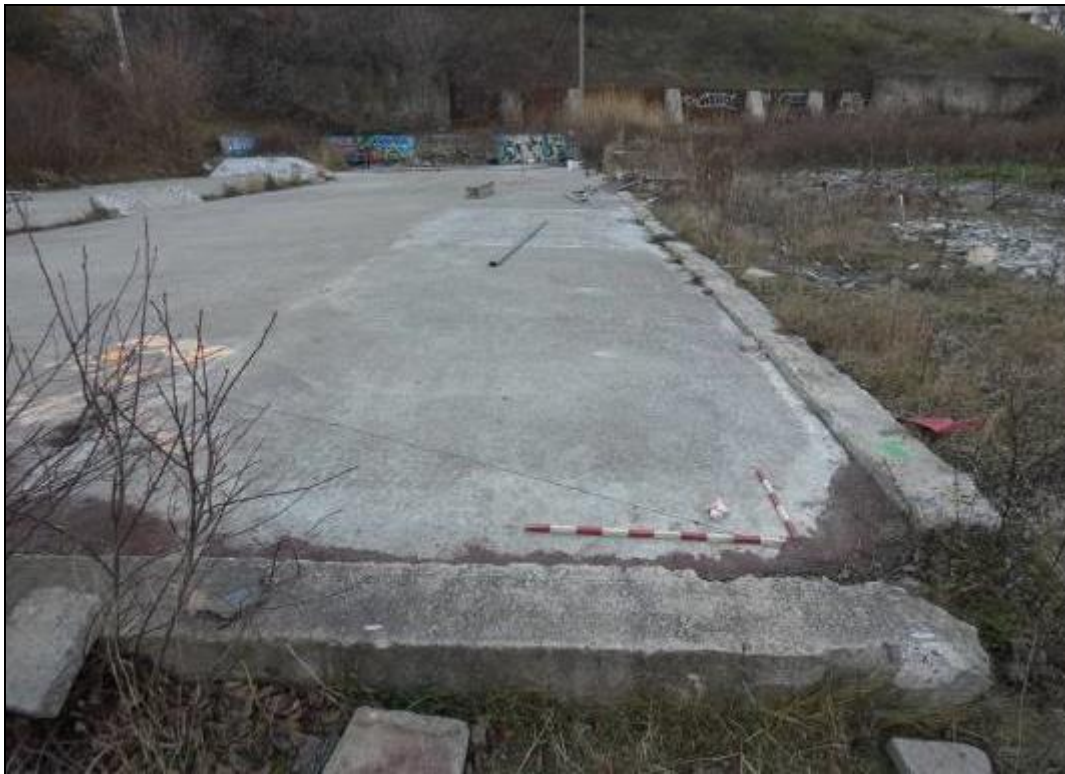
Photo 17. Plancher de béton, bases de murs formant les côtés est et sud de l'ancien bâtiment principal et empreinte au sol délimitant une ancienne pièce, vers le nord-nord-ouest (MTQ-154-16-0429-350)
