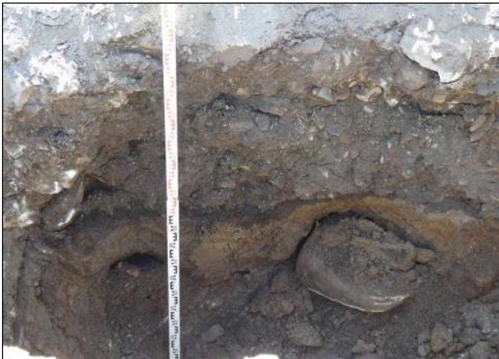
Photo 15. Paroi sud-ouest de la tranchée 3M montrant la présence d'une séquence de sols naturels en place, vers le sud-ouest (MTQ-154-16-0429-130)
