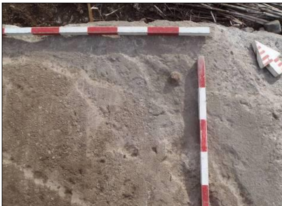
Photo 34. Détail de l'ancrage sud observé à la surface du massif de béton identifié dans la bande ouest de la zone d'intervention B, vers le nord-est (MTQ-154-16-0429-102)
