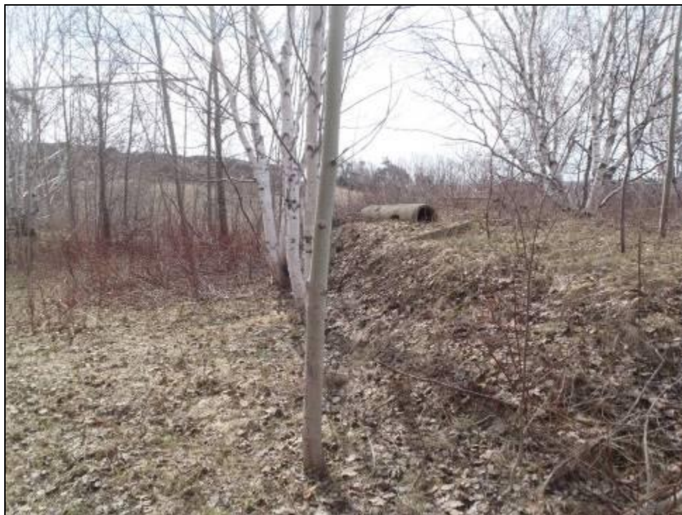
Photo 52. Débris en surface des zones d'intervention F et G, vers l'ouest (MTQ-154-16-0429-136)
