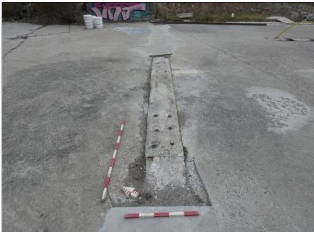
Photo 23. Possible base d'un mur porteur avec des tiges d'acier sciées, vers le nord-est (MTQ-154-16-0429-401)
