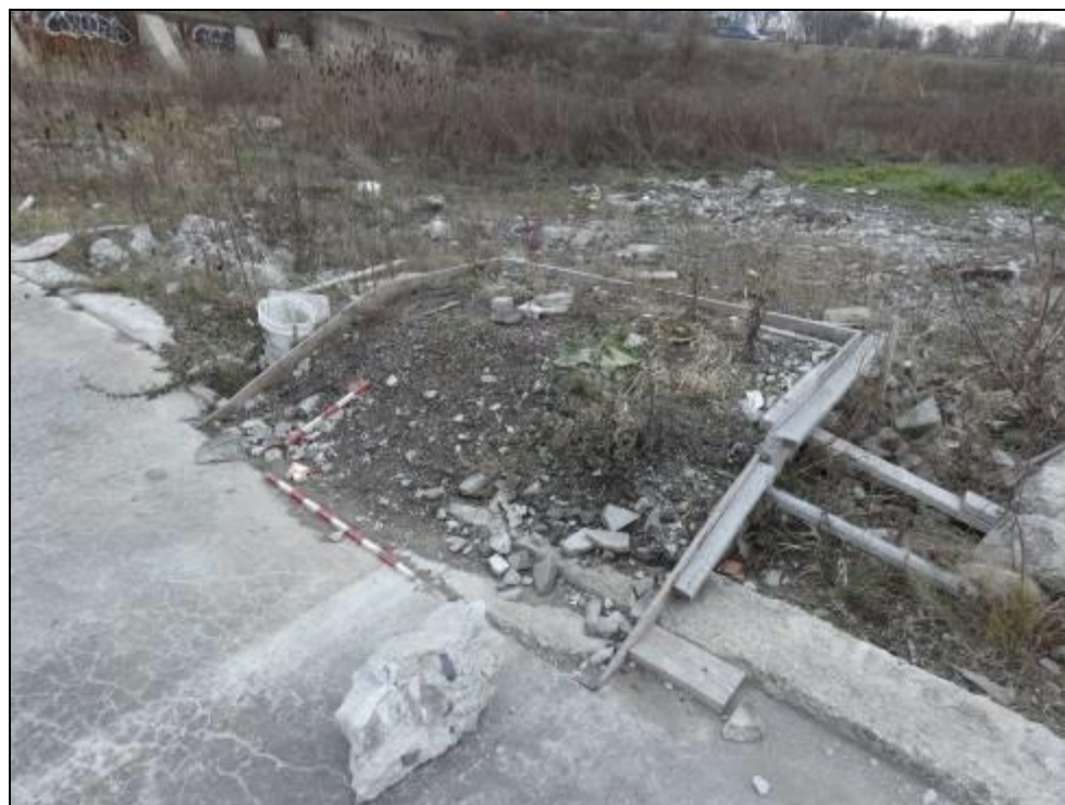
Photo 29. Module du planchodrome ( skate park ) abandonné avant que le béton ne soit coulé, vers le nord (MTQ-154-16-0429-392)
