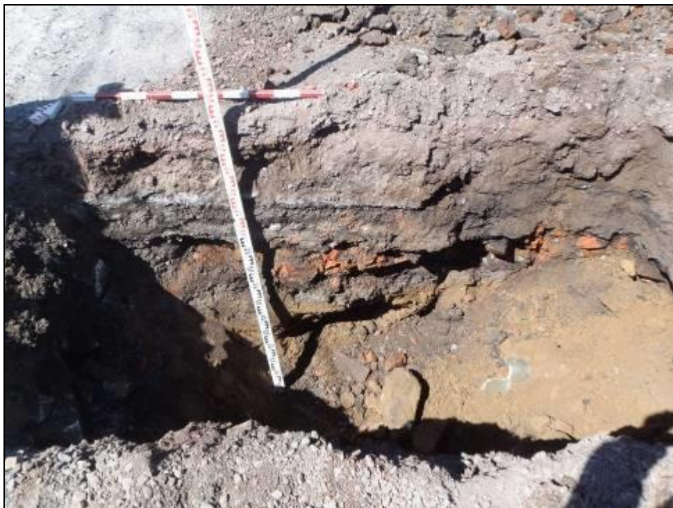
Photo 3. Couche d'asphalte identifiée en paroi de la tranchée 1P, vers le nord-ouest (MTQ-154-16-0429-040)
