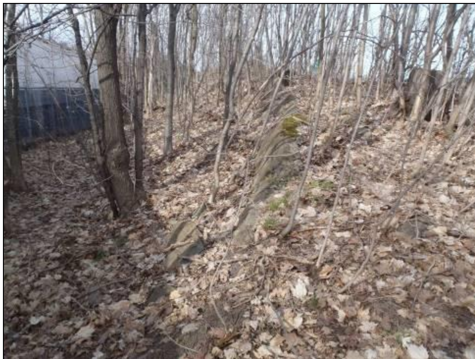
Photo 43. Portion nord de la zone d'intervention D, vers le nord-est (MTQ-154-16-0429-119)
