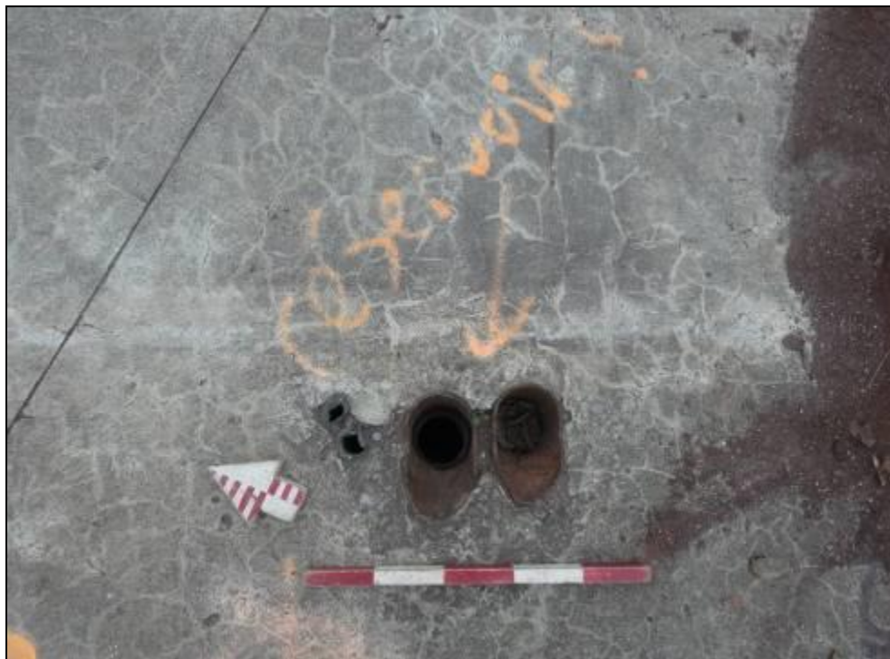
Photo 24. Ouvertures dans le plancher de béton, vers le nord-est (MTQ-154-16-0429-377)
