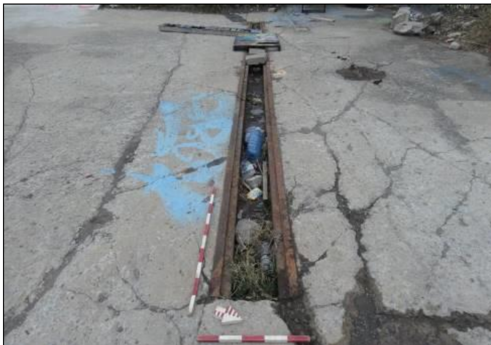
Photo 21. Système de drainage de l'ancien bâtiment, vers le sud-ouest (MTQ-154-16-0429-403)
