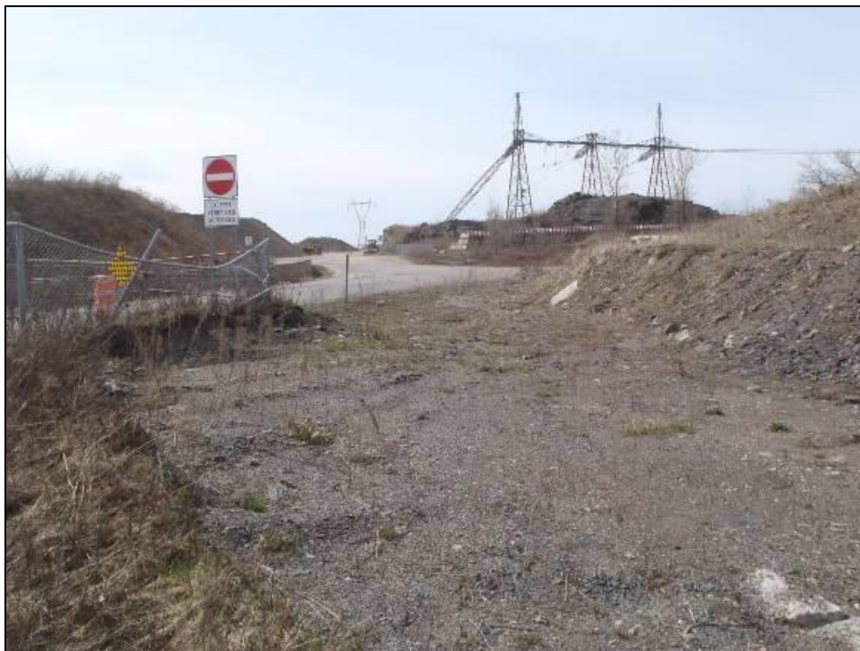
Photo 50. Vue du secteur du dépôt à neige, vers le sud-ouest (MTQ-154-16-0429-129)
