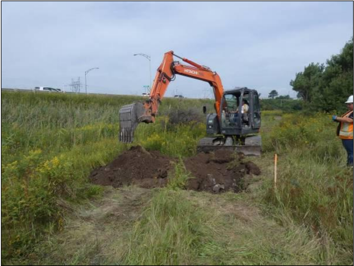
Photo 13. Vue d'ensemble de la portion ouest de la zone d'intervention B, vers le nord-ouest (MTQ-154-16-0429-241)
