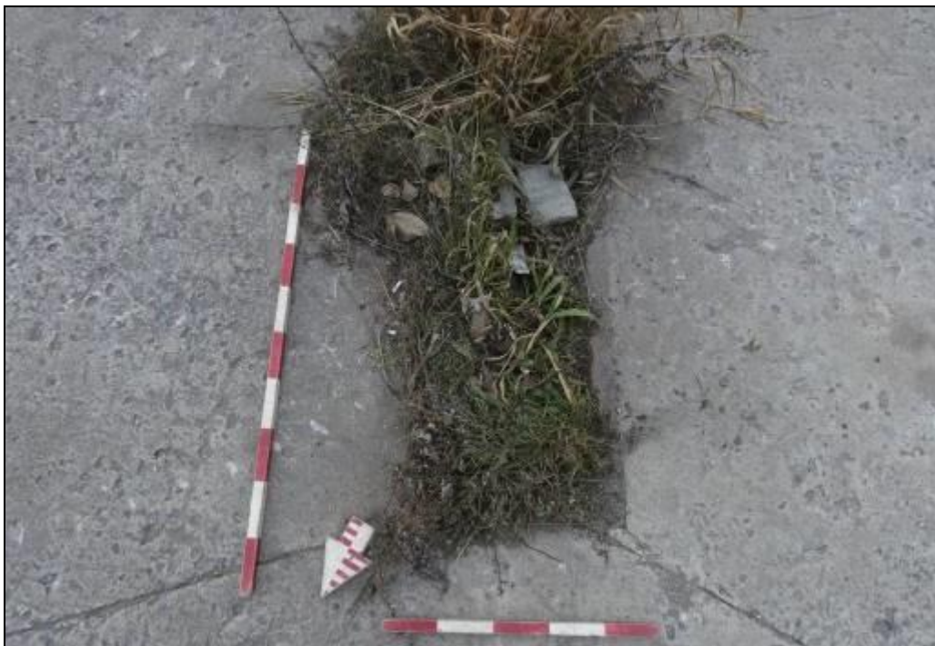
Photo 22. Extrémité nord d'un système de drainage orienté selon un axe nord-sud, avec les traits de scie partant vers les coins du bâtiment, vers le sud-est (MTQ-154-16-0429-373)
