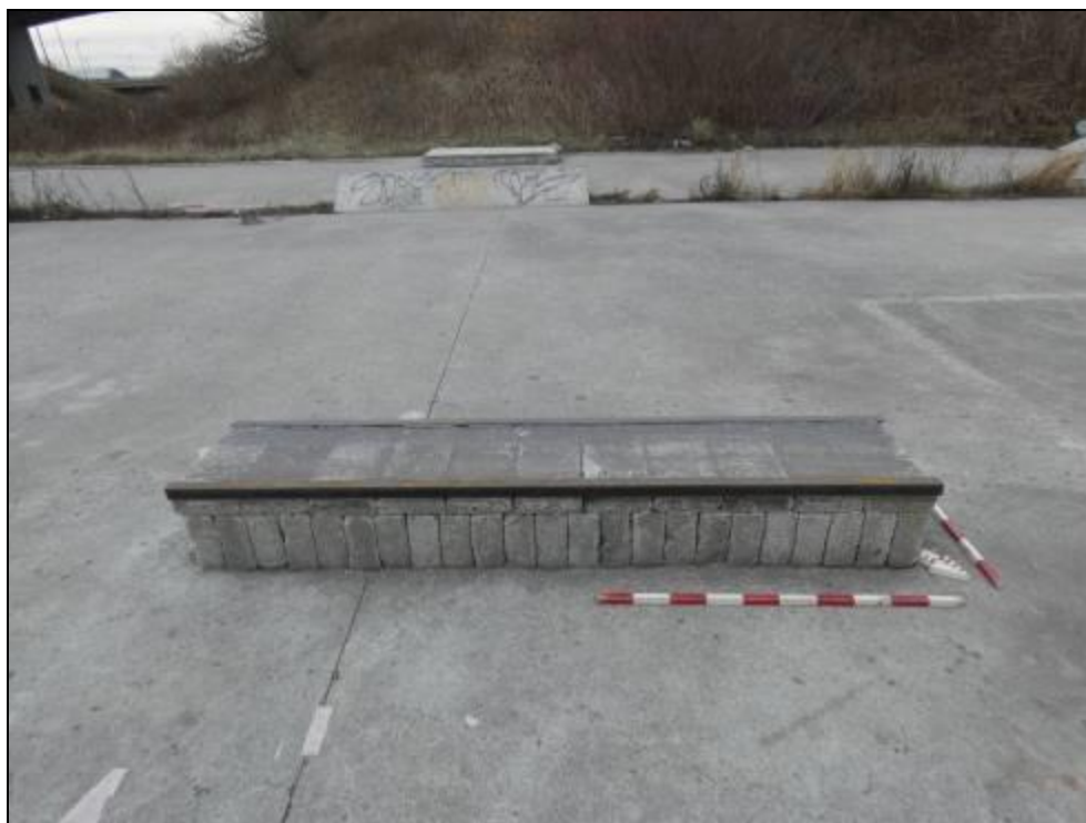
Photo 28. Curb avec rails d'acier aménagé pour le planchodrome ( skate park ), vers le sud-ouest (MTQ-154-16-0429-388)
