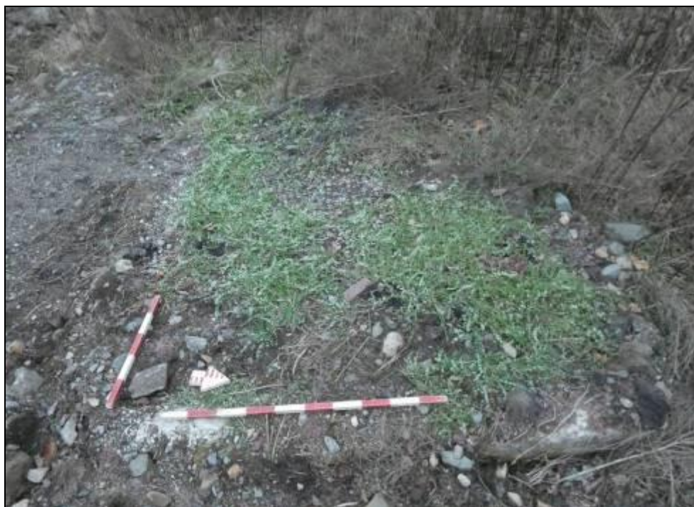
Photo 30. Bordures de béton ensevelies sous les déblais et présentes dans le coin sud-est de la portion nord de la zone d'intervention B, vers l'ouest (MTQ-154-16-0429-420)
