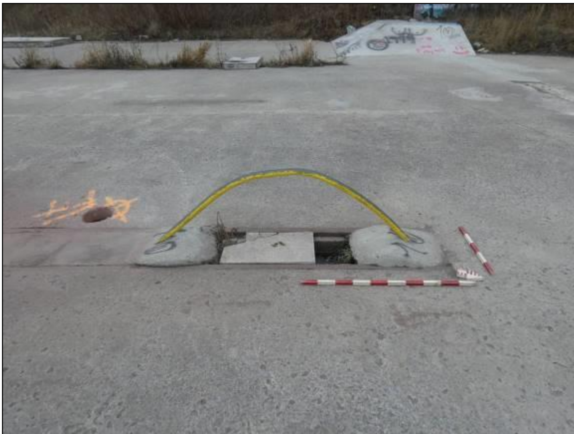
Photo 25. Rail aménagé pour le planchodrome ( skate park ), vers le sud-ouest (MTQ-154-16-0429-397)
