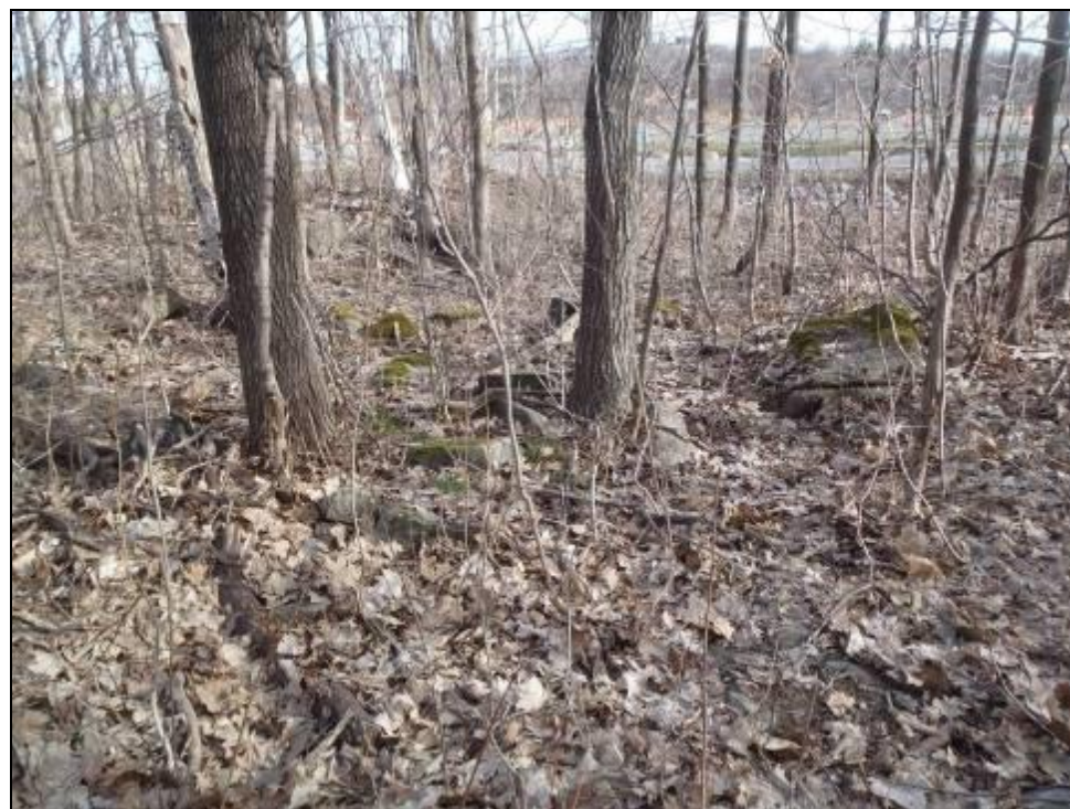
Photo 46. Blocs et débris observés dans la zone d'intervention E, vers le sud (MTQ-154-16-0429-106)
