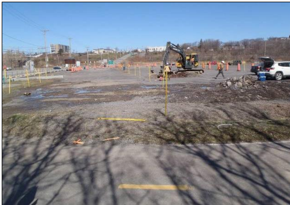
Photo 1. Vue d'ensemble de la zone d'intervention A, vers le nord (MTQ-154-16-0429-021)
