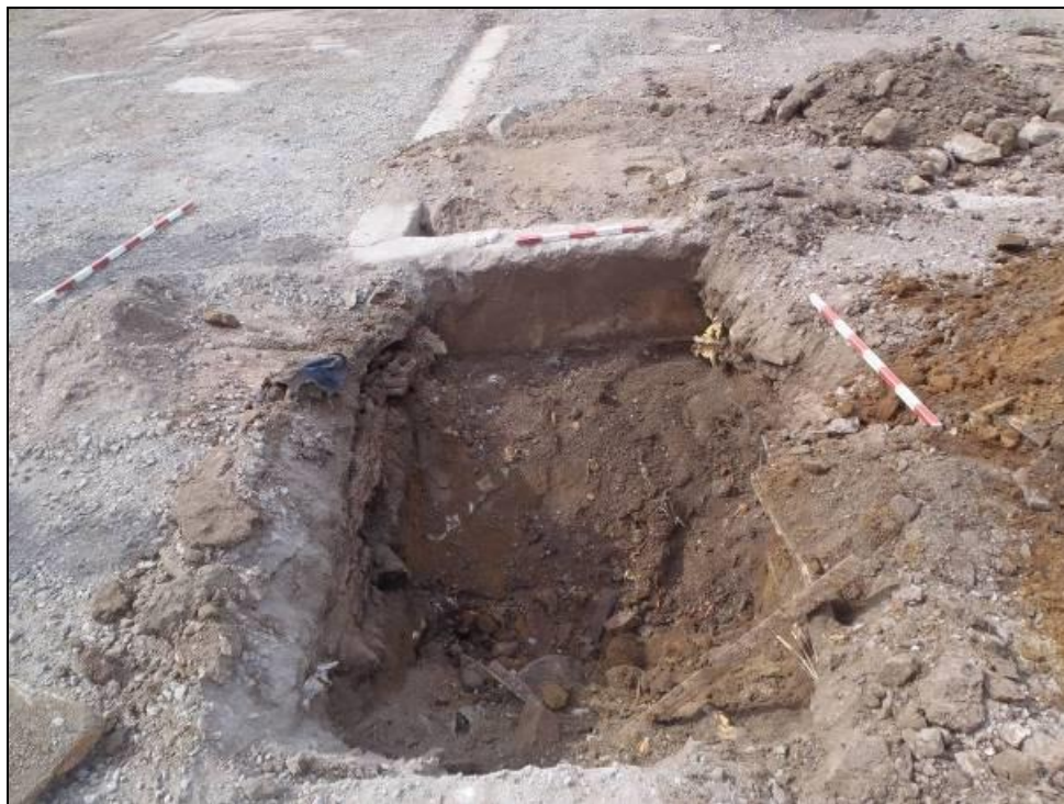
Photo 9. Parement extérieur du vestige de béton 2A100, vers le nord-ouest (MTQ-154-16-0429-092)
