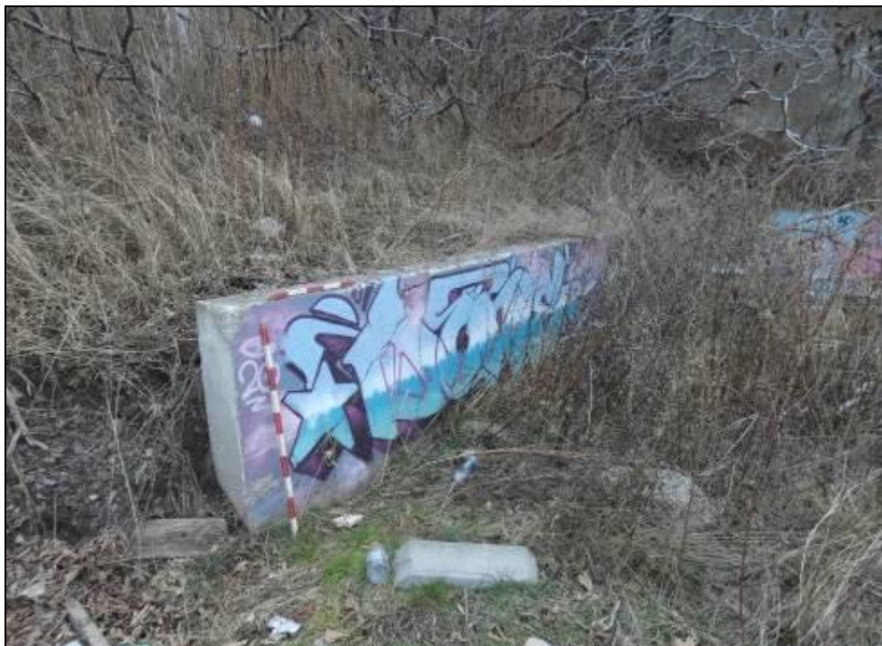
Photo 18. Portion haute du mur ouest de l'ancien bâtiment principal, vers l'ouest (MTQ-154-16-0429-363)
