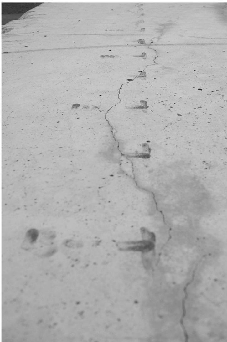
figure 6.30 montre une fissure passant alternativement de part et d'autre d'une gaine.
