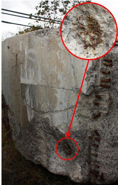
Figure 5.38- Ancre sectionné visible sur le segment de poutre B4S2
