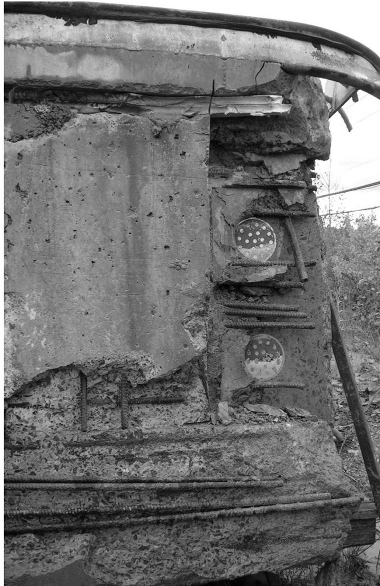
Figure 6.55- Ouverture de deux des ancrages du segment de poutre B2S7
