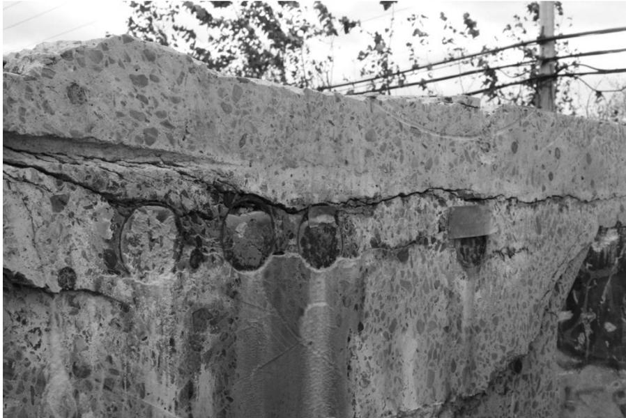
Figure 0.3- Plan de fissuration au-dessus des gaines du bloc B4S3
