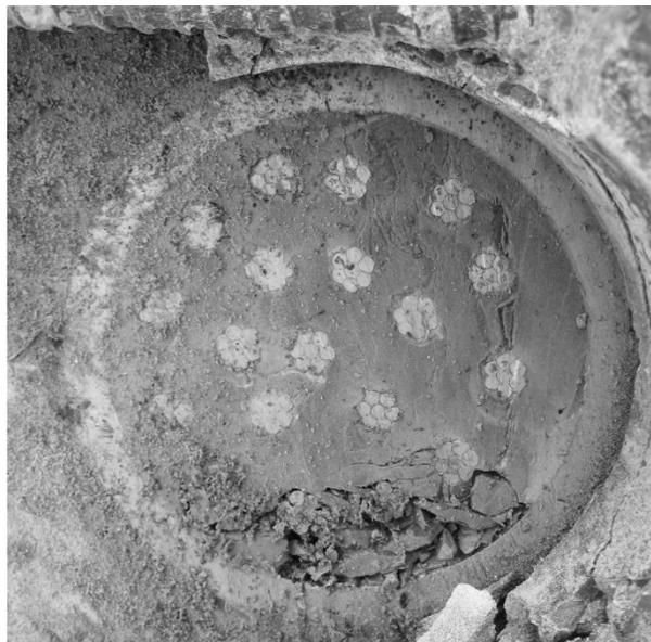
Figure 6.58- Tête d'ancrage ouverte en bas du segment B4S1
