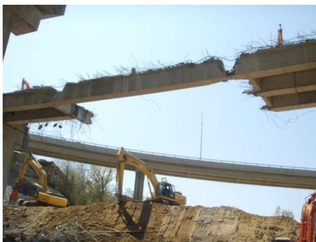
Figure 5.22- Étape intermédiaire pour le prélèvement d'une section de poutre de la bretelle B4 [44]
