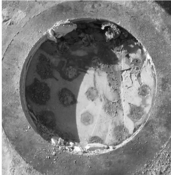
Figure 6.59- Tête d'ancrage ouverte au bas du segment de poutre B2S2
