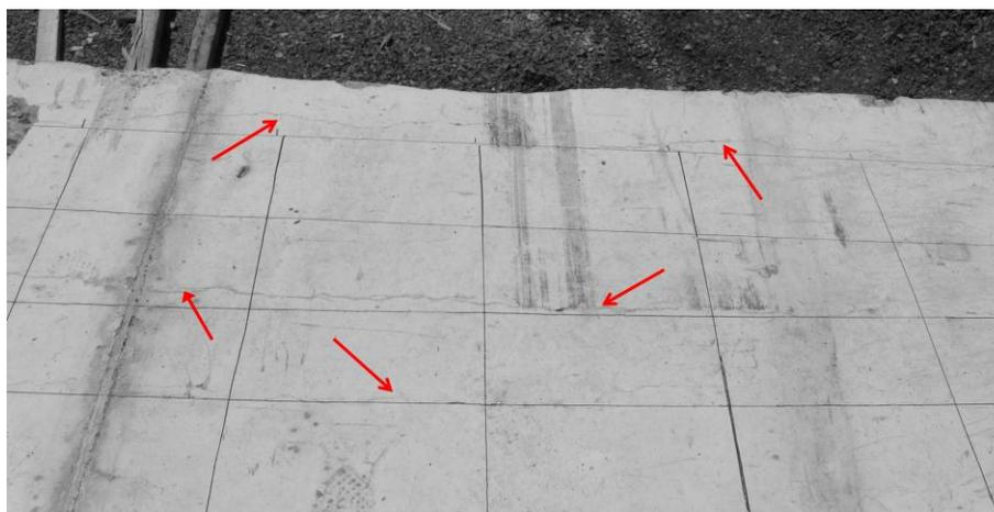
Figure 5.33- Microfissuration le long des gaines (tracés horizontaux) sur B4S4
