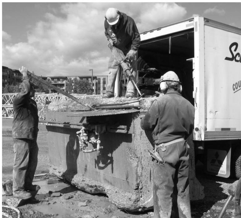
Figure 6.45- Récupération de la gaine E du segment de poutre B4S4
