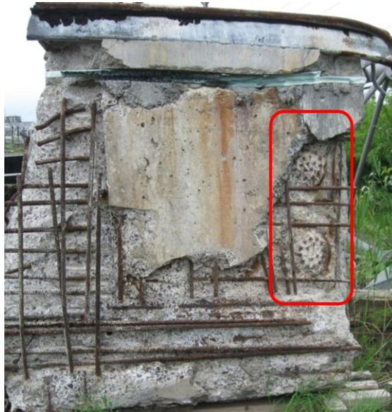
Figure 5.37- Vue sur les ancrages visibles sur le segment de poutre B2S7
