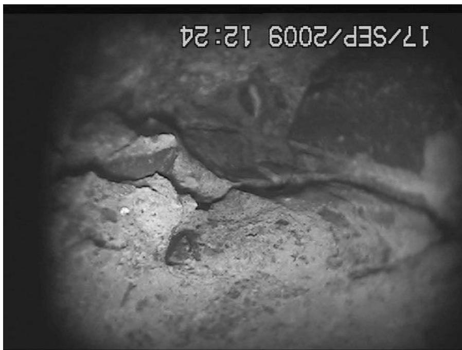
Figure 0.4- Cliché du plan de fissuration au-dessus des gaines obtenu par endoscopie (observation à 90°) à la cote B85
