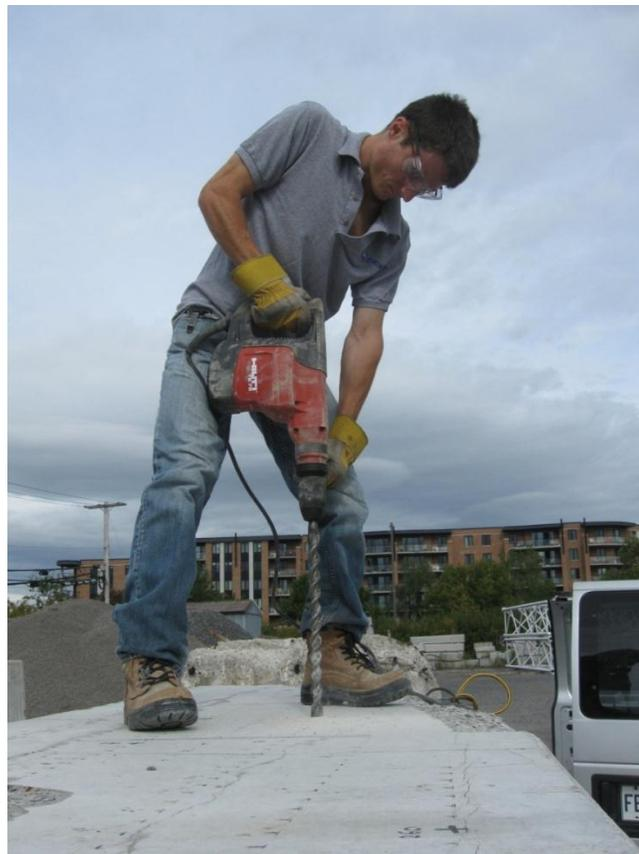
Figure 5.56 - Perçage d'un segment de poutre à l'aide d'une perceuse Hilti munie d'une mèche à béton
