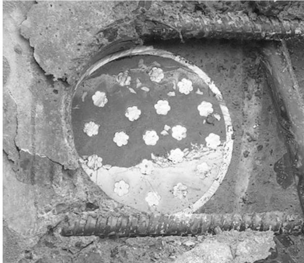
Figure 6.56- Arrière de l'ancrage situé en haut du segment de poutre B2S7
