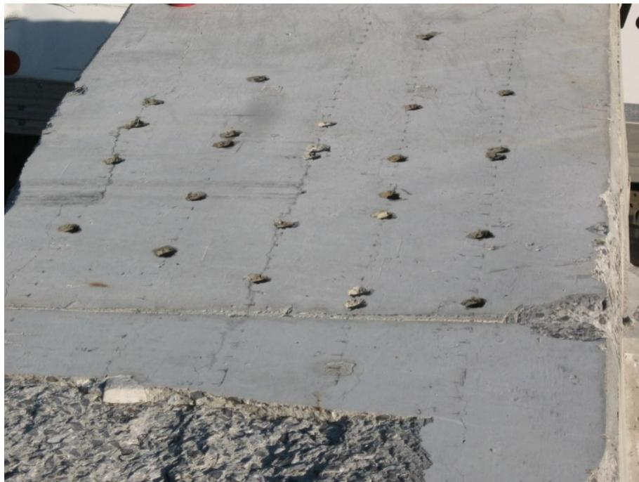
Figure 6.31 - Segment de poutre B4S4 percé suivant les différents endroits d'étude pour l'endoscopie
