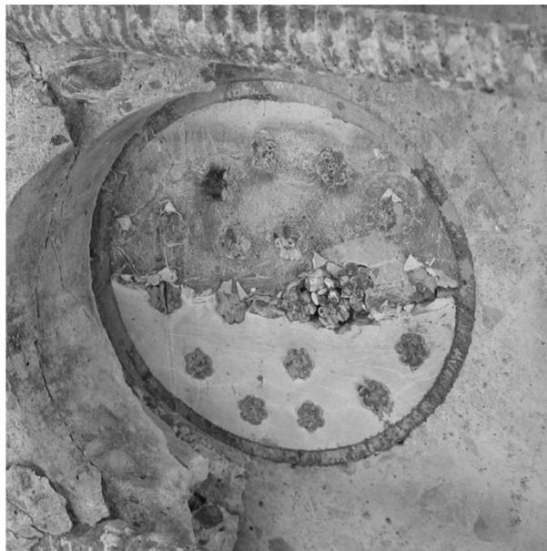
Figure 6.57- Arrière de l'ancrage situé au bas du segment de poutre B2S7
