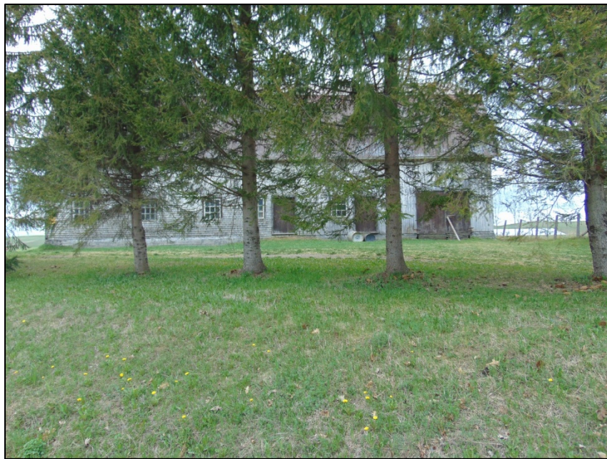
Figure 6 Zone à potentiel P-8 du projet 154-08-0439, vue vers le nord (154-08-0439-00319)
