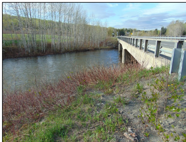
Figure 15 Limite de la zone d'intervention, à l'ouest de la zone à potentiel P-12, route 195, Amqui, vue vers l'ouest-nord-ouest (154-08-0439-00289)
