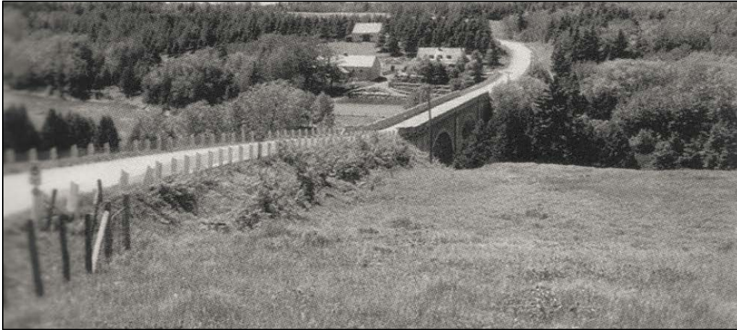
Figure 33 Pont en béton de 1928-1930 et la Tredennick farm (tiré de Patrimoine Experts, 2011:55)
