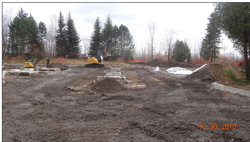
Figure 89 Site CfEs-23, vue du secteur de la sous-opération 25A (QUE1805-117)
