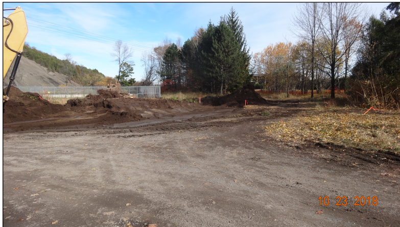
Figure 86 Site CfEs-23, vue du secteur de la sous-opération 24K (QUE1805-033)
