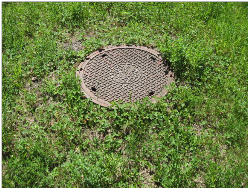
Figure 51 Couverture fermant la chambre souterraine enfouie près de l'angle sud-ouest de l'enclos
