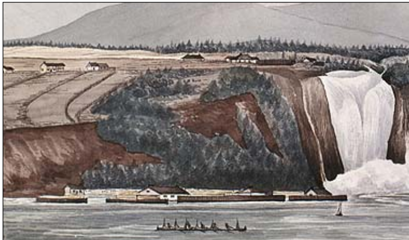
Figure 13 Détail d'une aquarelle peinte par H.F. Ainslie en 1838 montrant les installations Patterson au pied de la falaise
