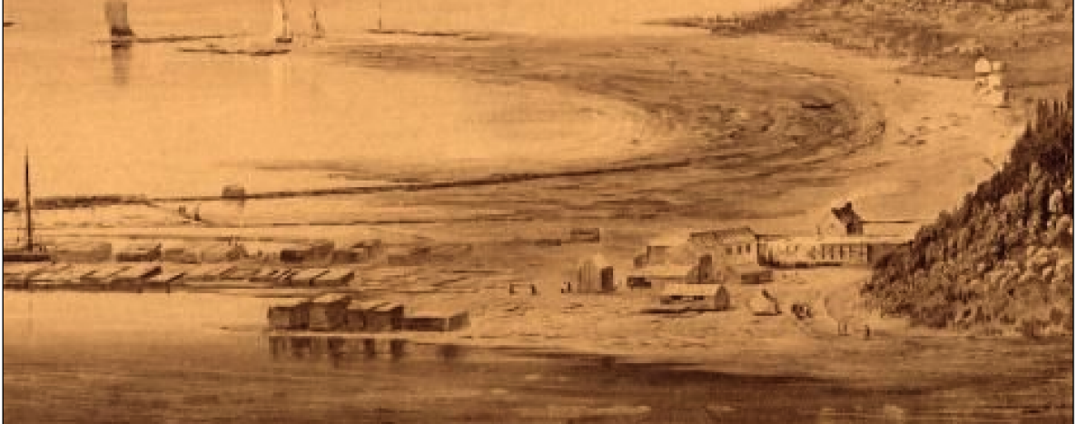
Figure 24 Détail de la figure 15 montrant les installations sur la plage
