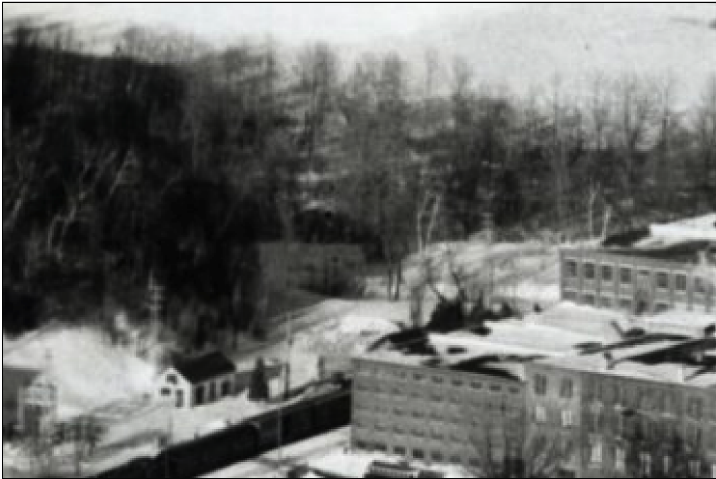
Figure 30 Détail tiré d'une photographie de W.B. Edwards montrant l'arrière de l'usine Dominion Textile, là où sera construit le poste Montmorency
