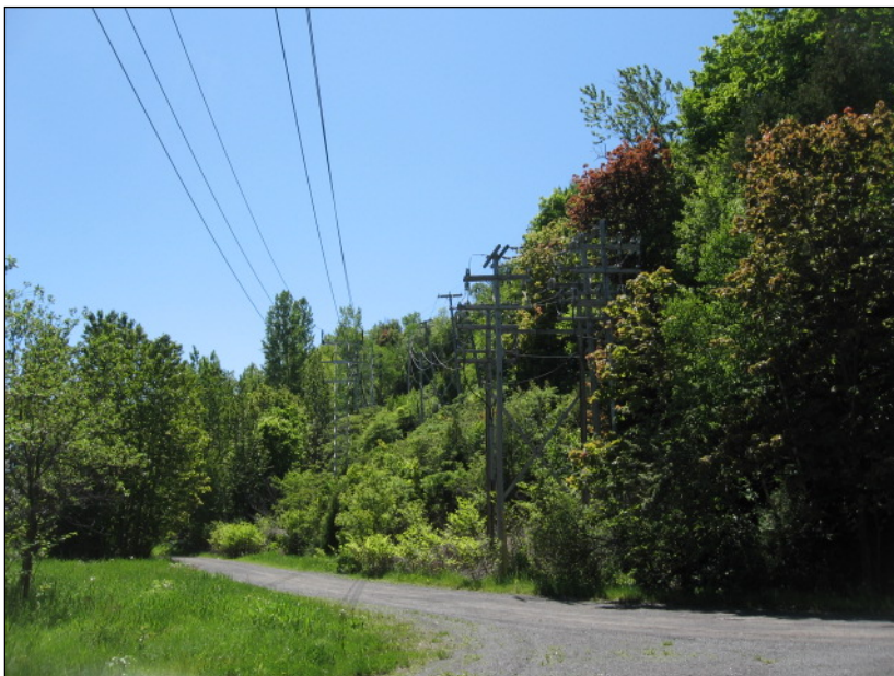
Figure 45 Vue vers le sud montrant l'espace situé devant le poste
