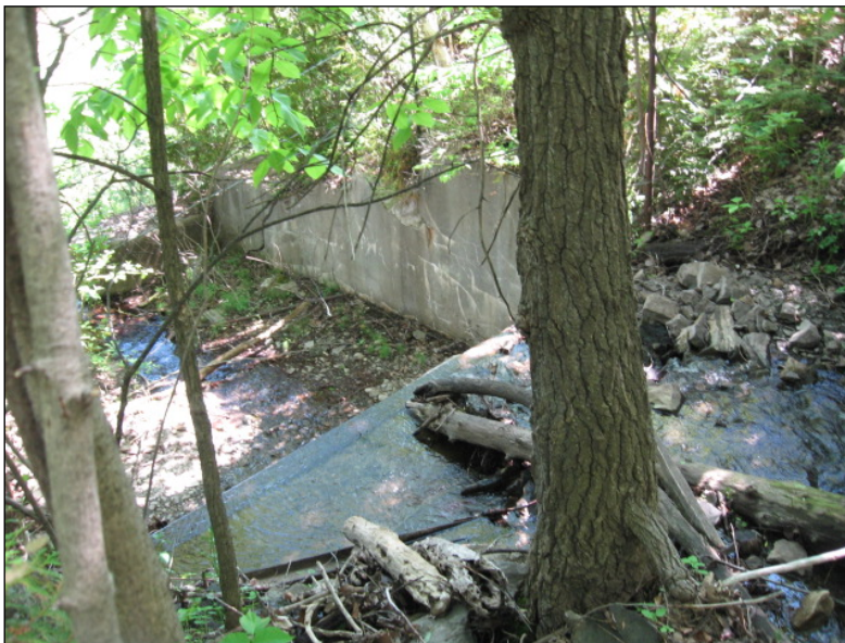
Figure 53 Ancienne structure en béton associée à la centrale surplombant la voie ferrée
