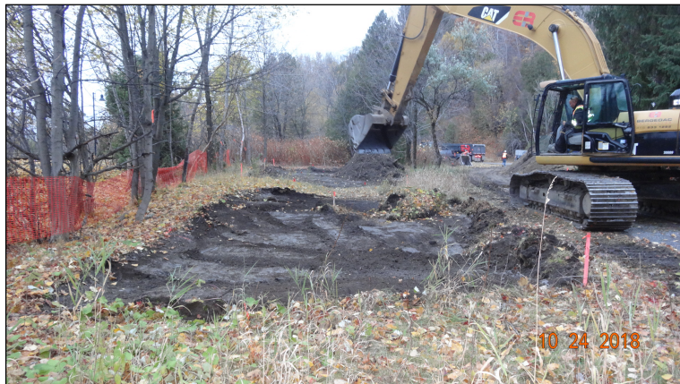
Figure 77 Site CfEs-23, vue du secteur de la sous-opération 24G (QUE1805-037)
