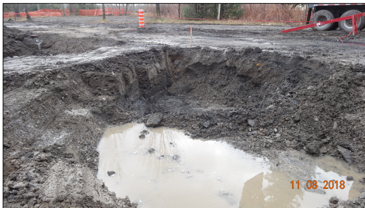
Figure 73 Site CfEs-23, section de la paroi nord-ouest de la sous-opération 24E (QUE1805-244)
