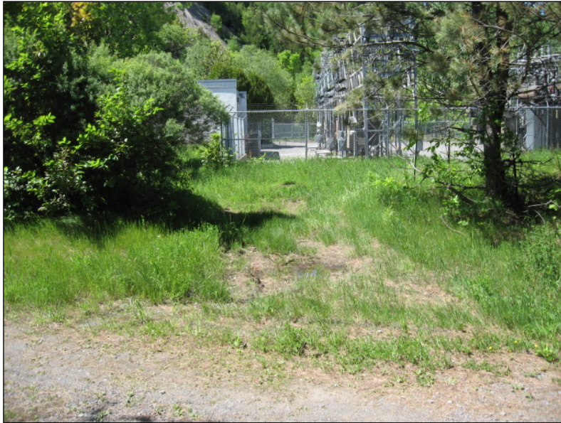
Figure 50 Lacune observée dans le cordon longeant le côté sud du poste
