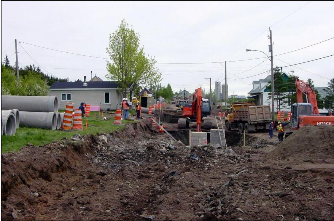
Photo 7 Section de dynamitage de la tranchée dans le secteur 8 (ch. 5+700), en direction est (PATR 07N06-004)
