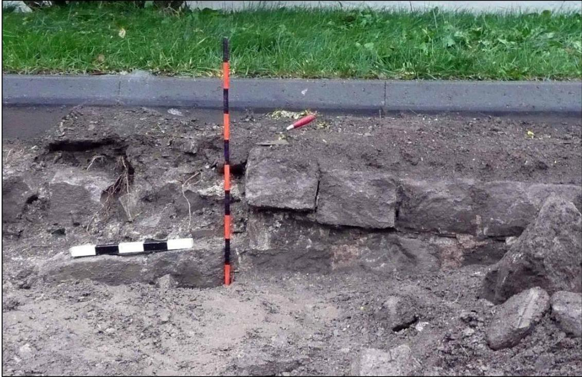
Photo 25 Vue des deux assises en pierres de taille du mur de fondation de la 3<sup>e</sup> église de 1877, direction est (PATR07N12-063)
