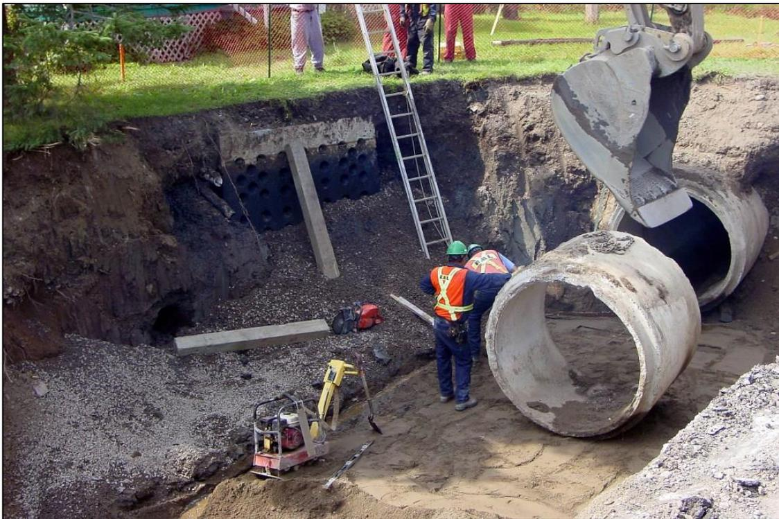
Photo 18 Pose d'une conduite à l'intersection du chemin du Haut-de-la-Rivière et de la route de la Plaine, ch 2+620, direction ouest (PATR07N06-218)
