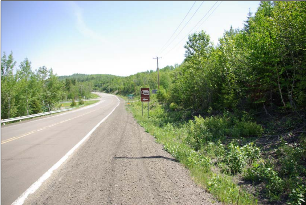
Photo 8 Projet n° 154-00-0086 (20-3174-0078), vue de l'emprise du côté sud, fossé, entre le km11+600 et le km 11+700, en direction est, (IMPG_523.jpg)
