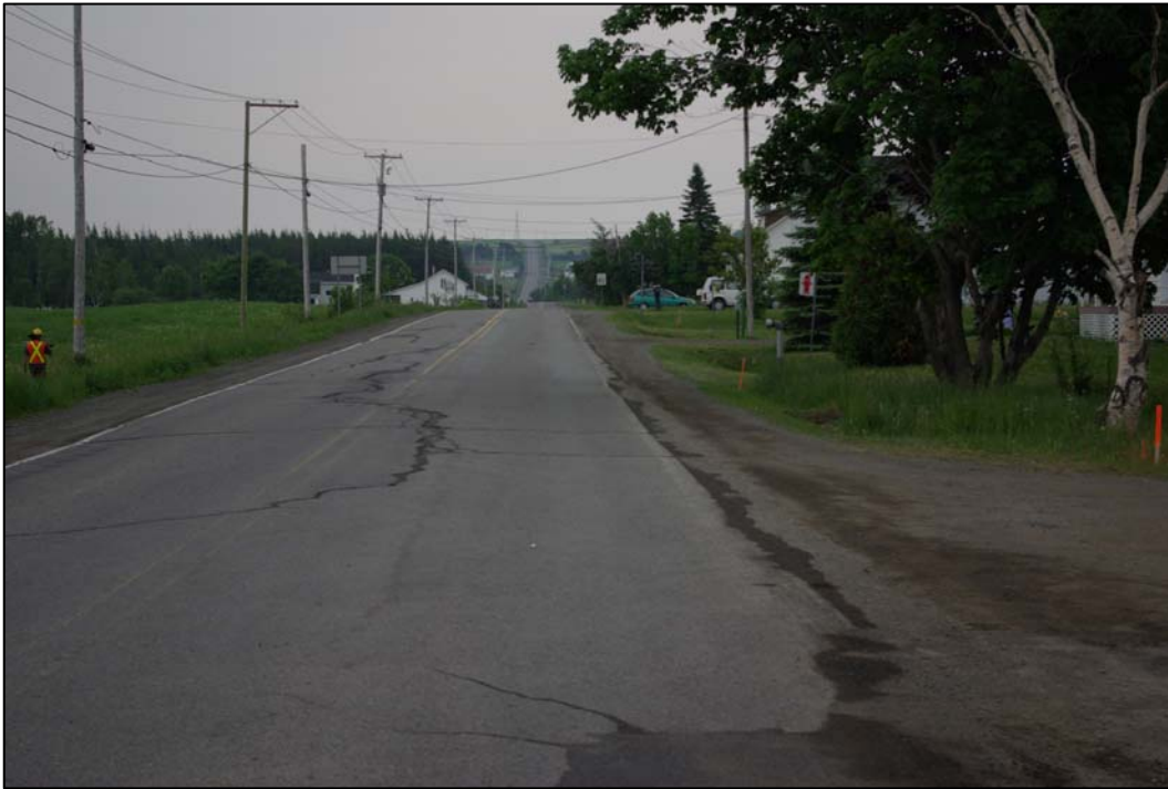
Photo 4 Projet n° 154-97-0115 (20-3373-9708-B) vue d'ensemble au km 11+100, en direction ouest (IMPG_582.jpg)
