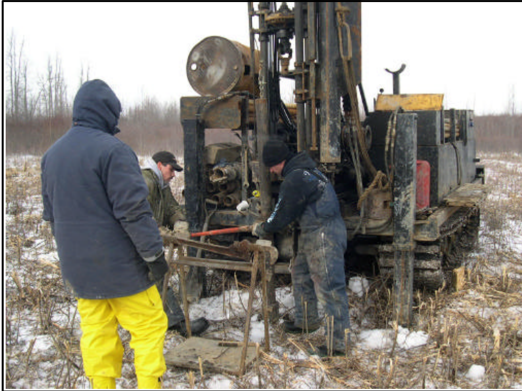
Photo 1 : Opération de forage (photographie Désirée-Emmanuelle Duchaine, MTQ-DSCN0179)
