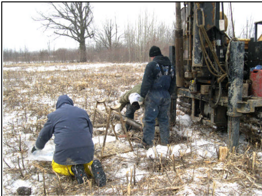
Photo 2 : Extraction et emballage d'une carotte (photographie Désirée-Emmanuelle Duchaine, MTQ-DSCN0191)
