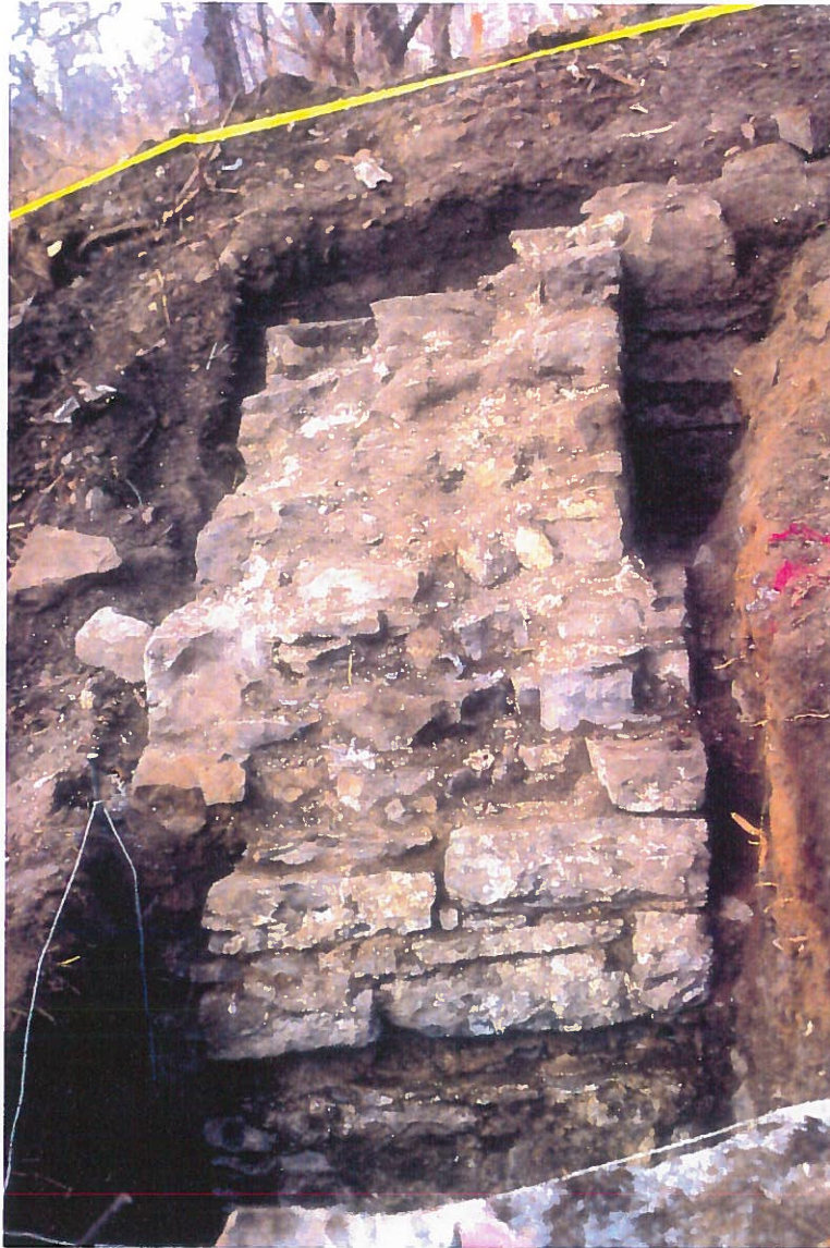
Photographie 1.23: Vue générale du coin Nord-Ouest et des murs extérieurs de l'auberge Bureau. Dans la paroi Nord du puits 1, vue d'un mur de pierres constituant la battée d'une baie de fenêtre ou de porte dans le mur extérieur Ouest de l'auberge. Orientation N.
