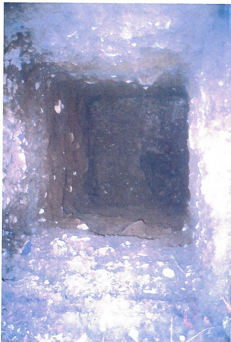
Photographie 3.7: Vue du fond du puits 8. Orientation E.
