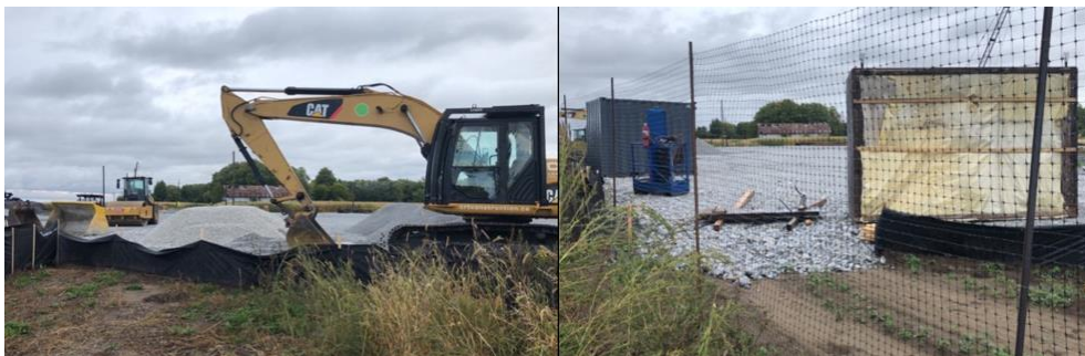
Figure 39. Blocage complet des accès vers le MR8 lors de travaux du MTQ
