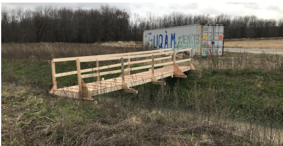
Figure 41. Passerelle temporaire bâtie par le MTQ pour l'UQAM
