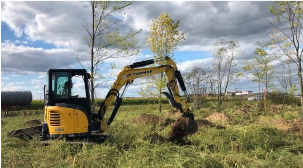
Figure 10. Excavation de trous pour les arbres (> 1,5 m) dans le MR8A
