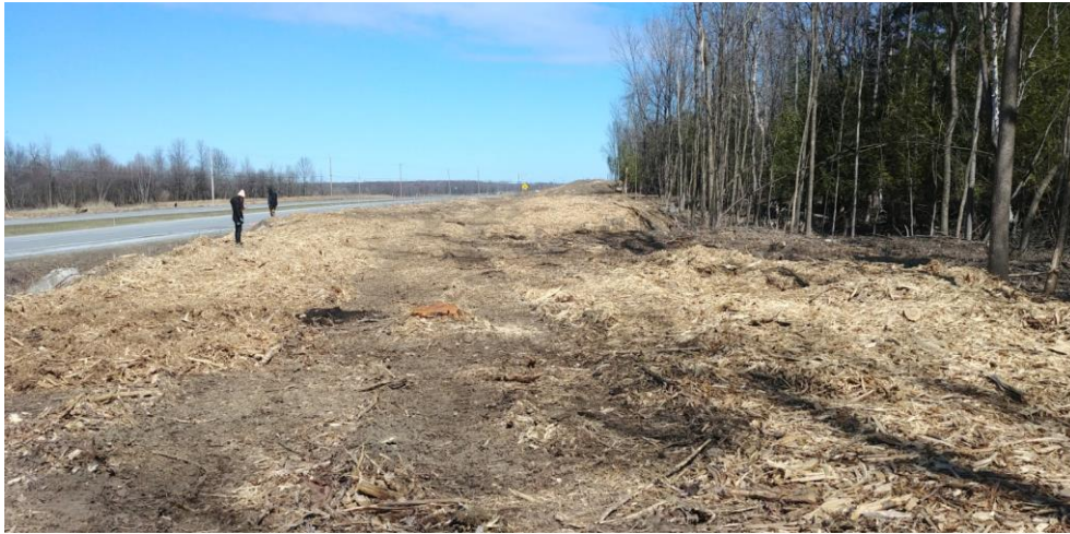
Figure 42. Épandage des résidus de bois dans les zones présentant initialement des EMVS
