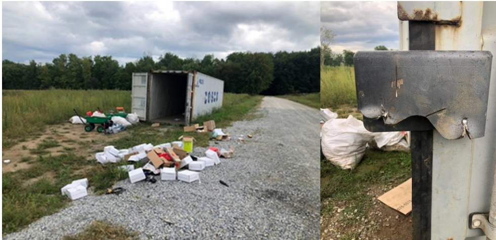
Figure 43. Vue d'ensemble du conteneur dépouillé à la suite du vol et de la boîte de sécurité abimée
