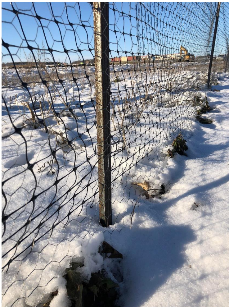
Figure 9. Aménagement de grillage hexagonal galvanisé dans le bas de l'exclos du MR8
