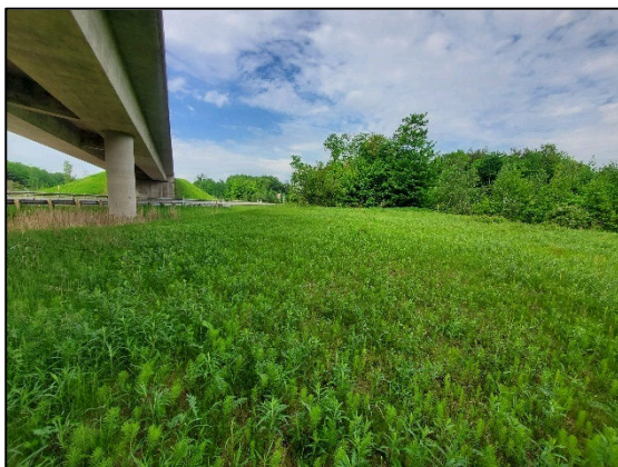
Figure 56 : Secteur 9, clairière anthropique sous le viaduc à l'extrémité est de la zone, au 28+900, vers le sud
