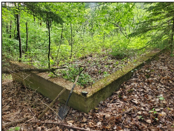
Figure 48 : Secteur 7, site 21-MIRABEL-01, fondation en béton, au 31+650, vers le sud-est
