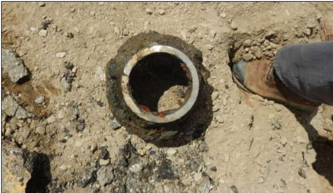
**Figure 59 : Vue en coupe de l'ancien tuyau d'aqueduc (la main), vers l'ouest (100H).** (Photo n° : 100H-DSCN0392, 2019-08-05)
