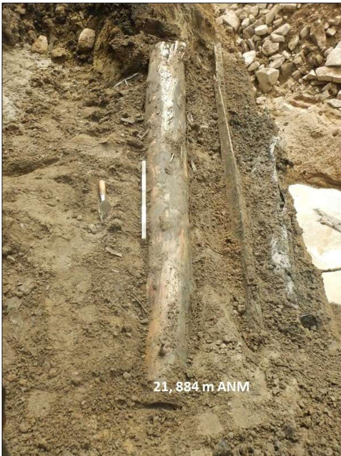
**Figure 58 : Caisson en bois goudronné renfermant le tuyau d'aqueduc en fonte, section nord (100J2).**
