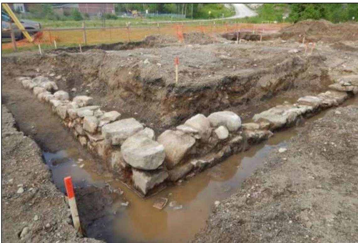
**Figure 26 : Fondations en maçonnerie du magasin, à partir de l'angle sud-est. (Photo n° : 100D-DSCN 1175(3), 2019-06-16)**
