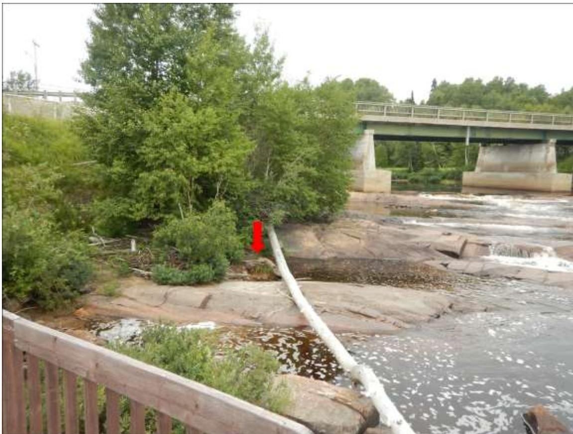
**Figure 66 : Reste d'un caisson de bois de l'ancien pont couvert traversant la rivière Sault-au-Mouton avec le pont actuel en arrière-plan, vue vers le nord. (Photo n° : DSCN0504, 2019-08-06)**
