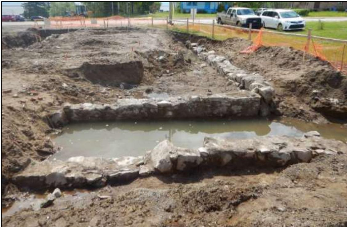
**Figure 25 : Fondations en maçonnerie du magasin et de l'annexe (en avant-plan), vues vers le sud. (Photo n° : 100D-DSCN1166, 2019-06-16)**
