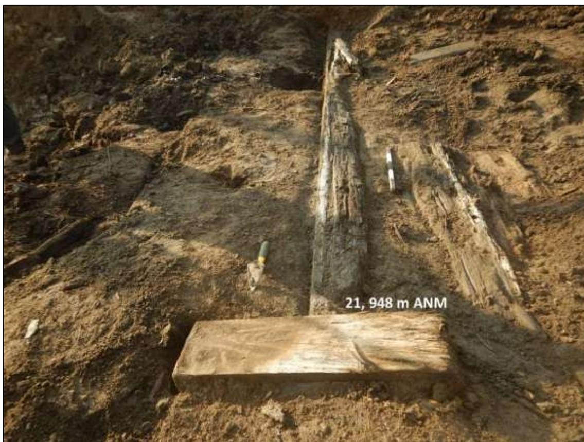
**Figure 57 : Caisson en bois goudronné renfermant le tuyau d'aqueduc en fonte, section sud. Les poutres écharries, autrefois en position verticale, semblent avoir servi de balises (100K3). (Photo n° : 100K3-DSCN0540, 2019-08-07)**
