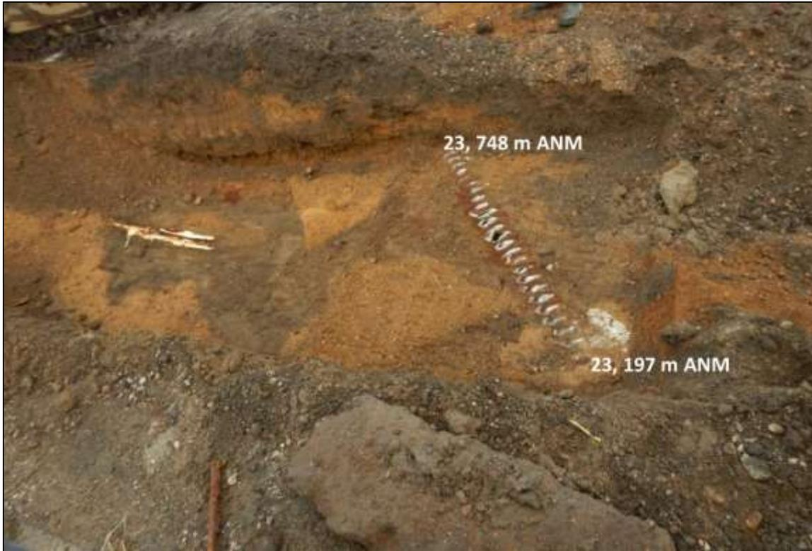
**Figure 61 : Tuyau en tôle ondulée traversant le chemin principal, vue vers le nord (100K8).** (Photo n° : 100K8-DSCN0939, 2019-08-13)
