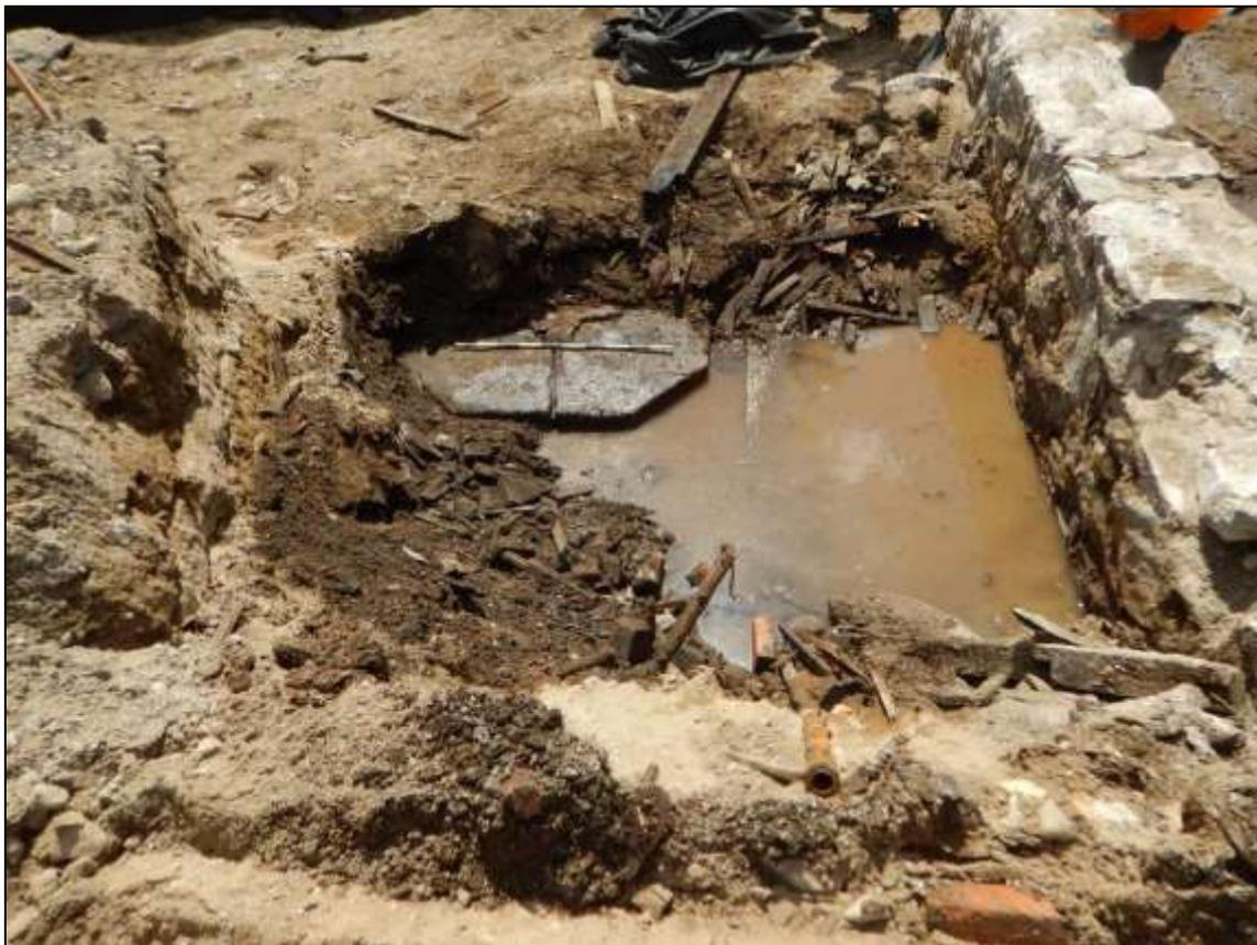
**Figure 29 : Dalle supportant vraisemblablement le réservoir à eau chaude sous les débris de démolition dans le soubassement du magasin. (Photo n° : 100D-DSCN1201, 2019-06-18)**
