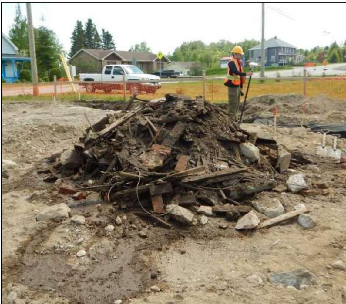
**Figure 30 : Amas de débris provenant des remblais à l'intérieur des fondations du magasin. (Photo n° : 100D-DSCN1214, 2019-06-18)**
