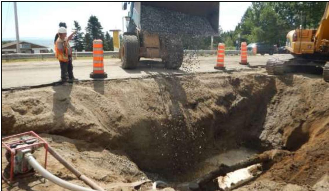
**Figure 55 : Excavation du côté nord de la route Principale (100H). L'ancien tuyau d'aqueduc est visible au bas de la photo. (Photo n° : 100H-DSCN0390, 2019, 08-05)**
