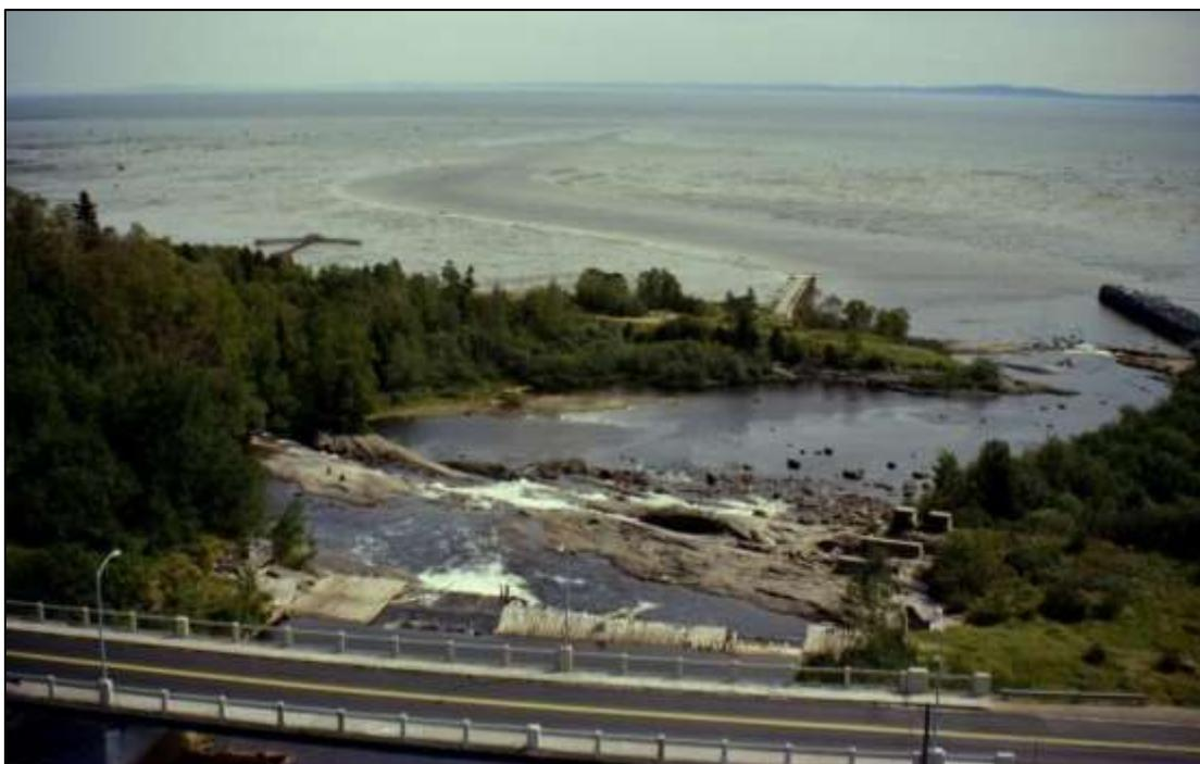
**Figure 15 : Photo datant de 1977, sur laquelle on aperçoit les caissons de l'ancien pont couvert et le nouveau pont datant de 1951 immédiatement au nord. Les supports en béton de l'amenée d'eau vers la scierie sont également visibles. (Source : BAnQ numérique, 06M\_P690S1\_D77-219\_0197)**
