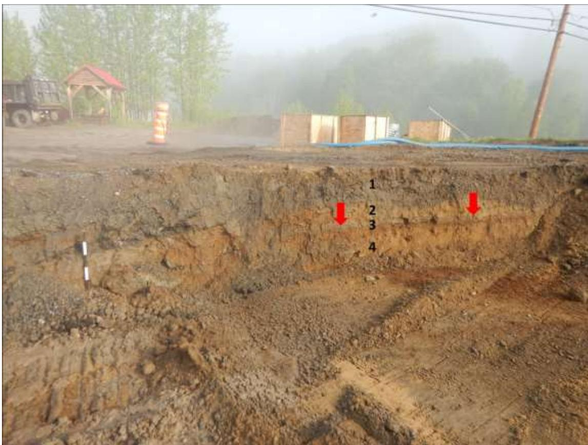
**Figure 69: Profil des sols à l'approche du pont actuel traversant la rivière Sault-au-Mouton, tranchée 100L, vers le nord. Le niveau de la chaussée en 1951, lors de la construction du pont, est visible en paroi. (Photo n° DSCN3990, 2021-05-26)**
