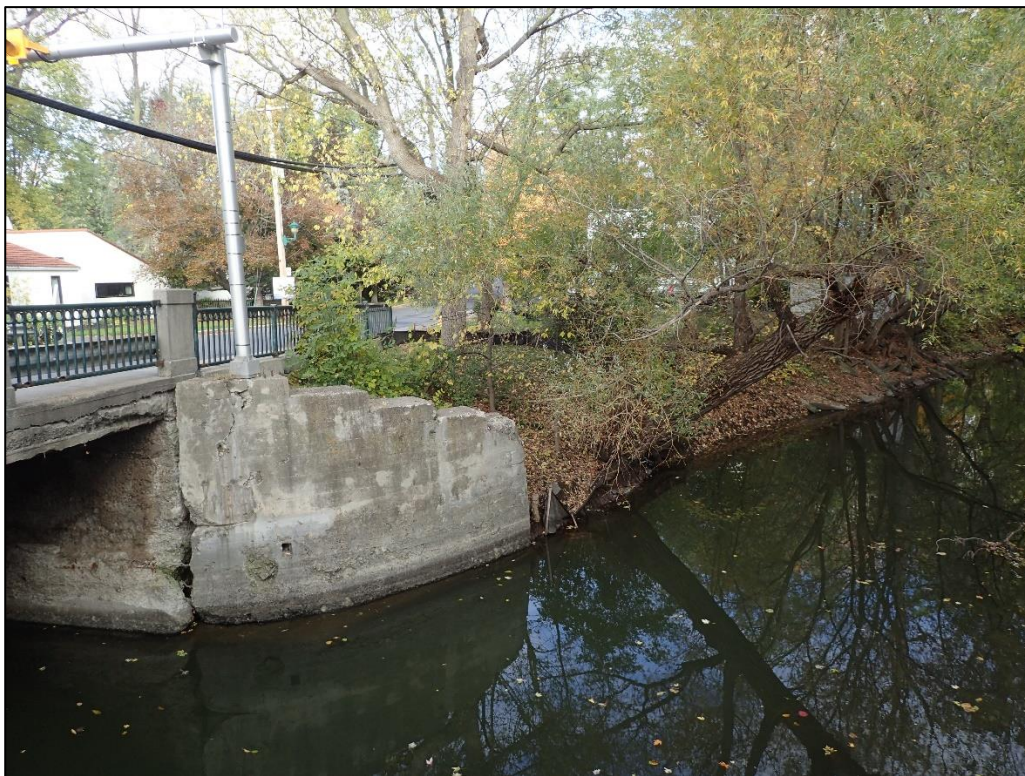
Figure 6 : Projet 154-07-1539, vue générale de l'emprise, route 133, Saint-Jean-sur-Richelieu (vue vers le nord, photo 154-07-1539-10).
