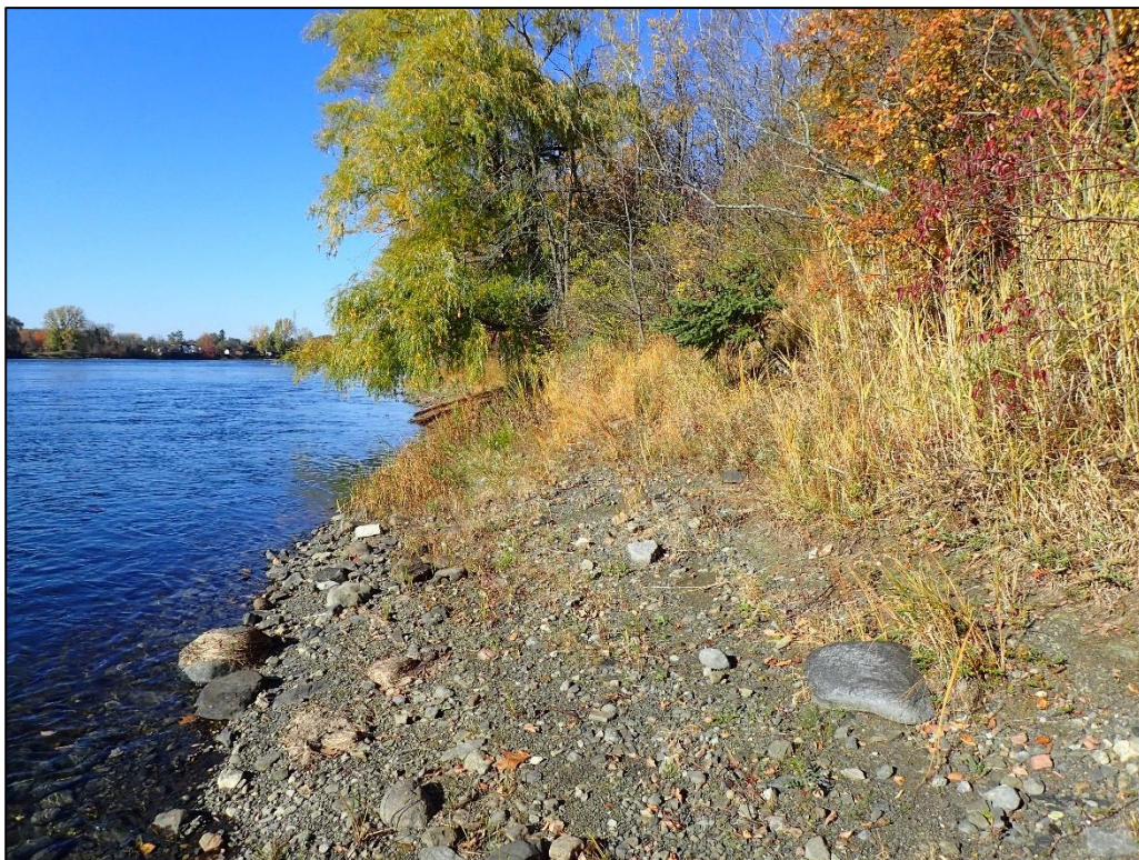
Figure 15 : Projet 154-20-0566, vue de la berge de la rivière Richelieu ayant fait l'objet d'une inspection visuelle, route 133, Richelieu (vue vers le nord, photo 154-20-0566-18).
