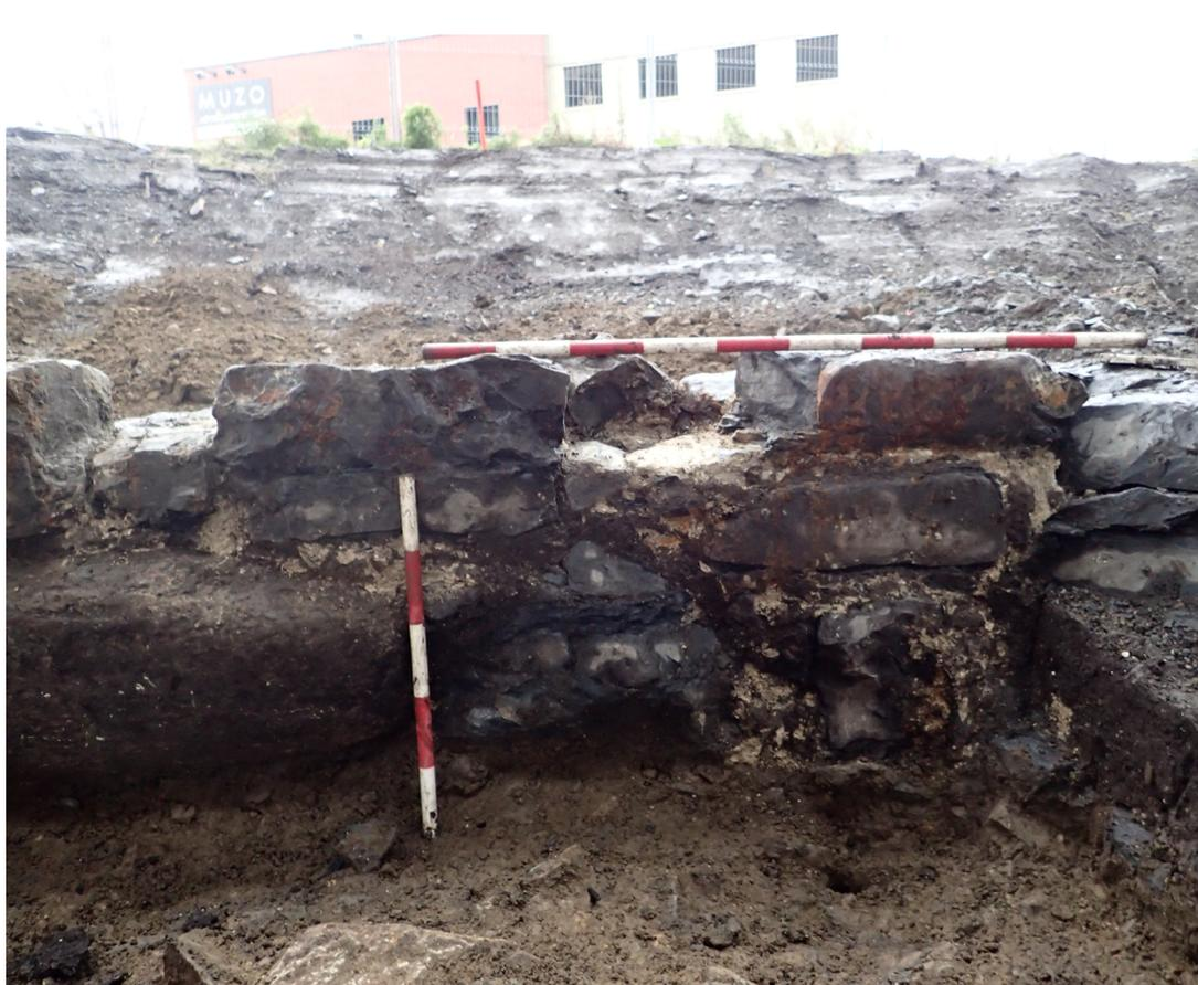
deux endroits, se trouvent des décrochements éloignés de 1,60 m sur le parement est de 3A100. Ces décrochements élargissent le mur de 0,23 m. Ils pourraient avoir eu pour fonction de renforcer le mur arrière du bâtiment. Le mur a été dérasé à une altitude de 18,74 m, c'est-à-dire qu'il demeure une hauteur maximale résiduelle de 0,63 m. Les joints affleurants à débordant de mortier jaunâtre mesurent de 1 à 3 cm de largeur.
