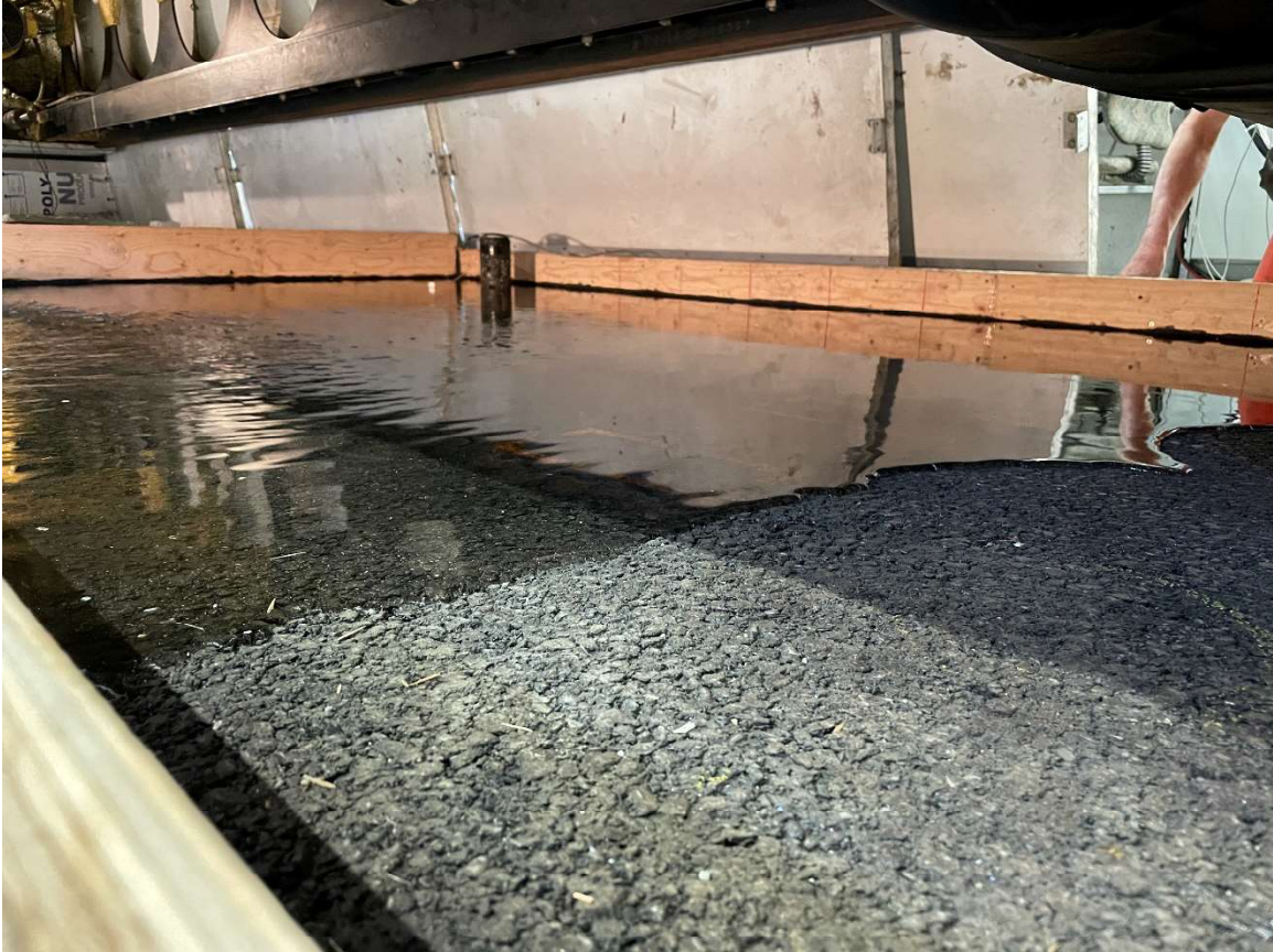
Figure 71. Ajout d'eau dans le bassin
