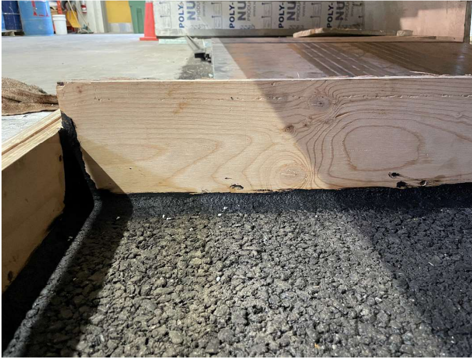
Figure 68. Exemple de joints mis en œuvre dans le bassin
