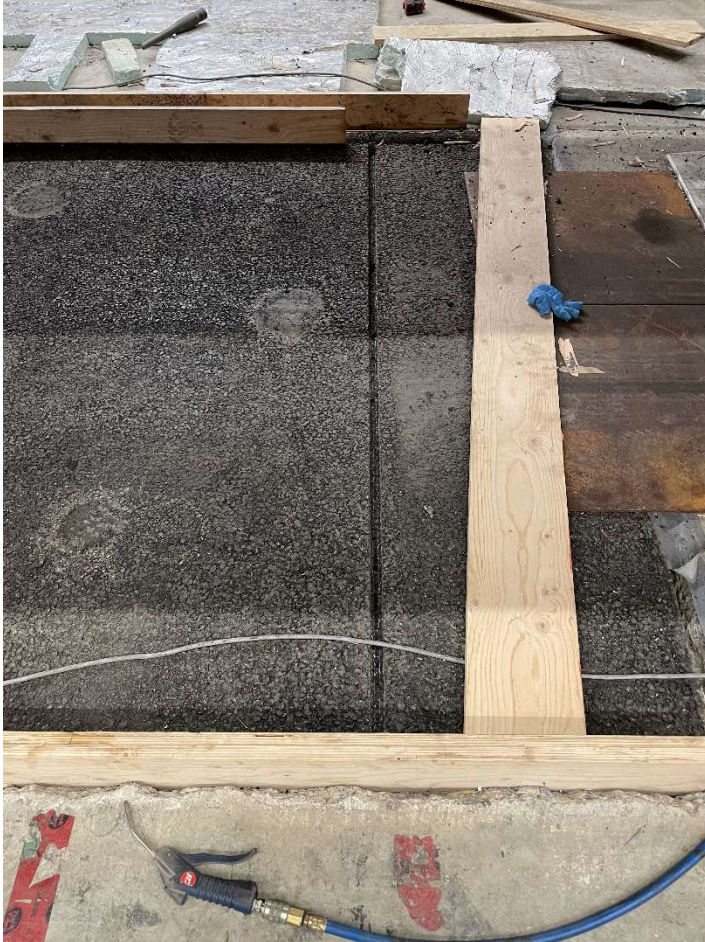
Figure 67. Trait de scie pour l'insertion de la paroi transversale du bassin
