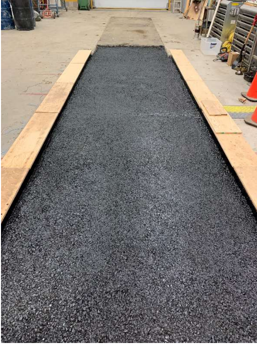
Figure 38. Émulsion bitumineuse mise en œuvre à la surface du GB20
