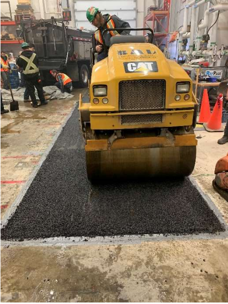
Figure 35. Compactage des couches d'enrobé au rouleau
