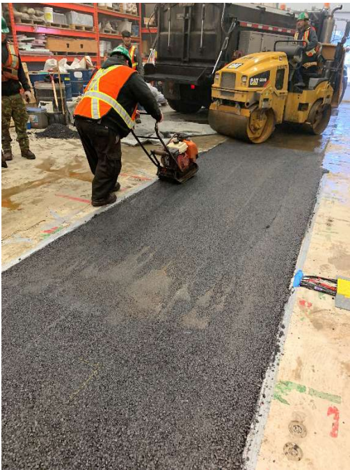
Figure 36. Compactage des extrémités de la fosse avec une plaque vibrante
