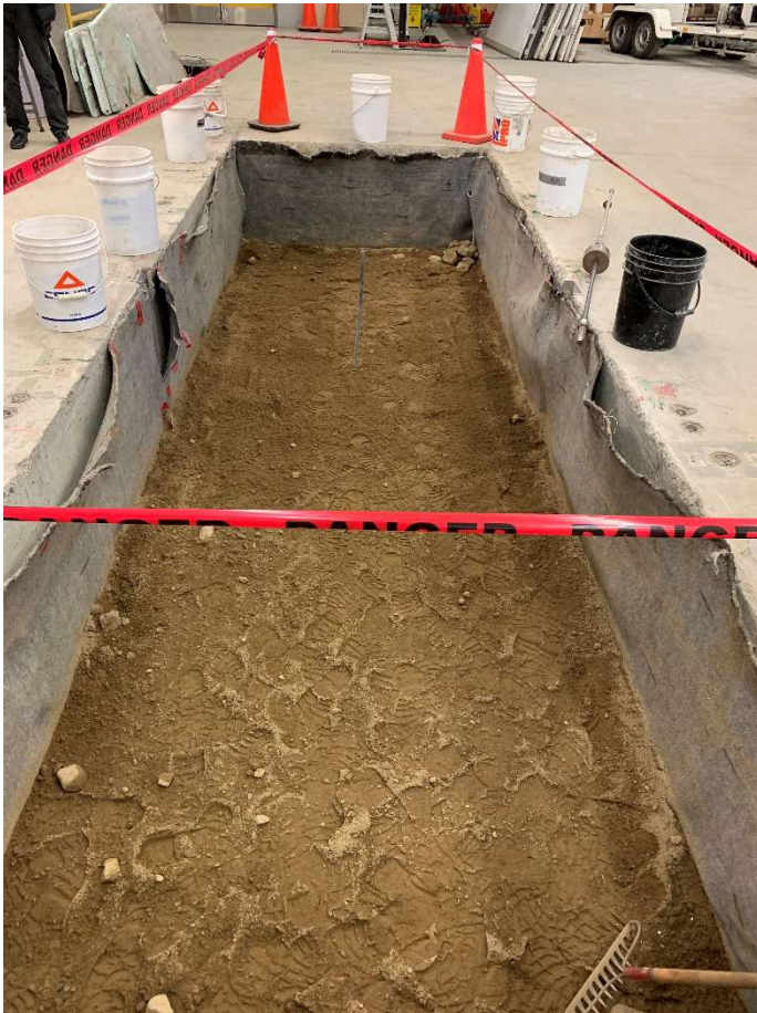
Figure 29. Excavation de l'ancienne chaussée jusqu'à une profondeur Z=-825 mm
