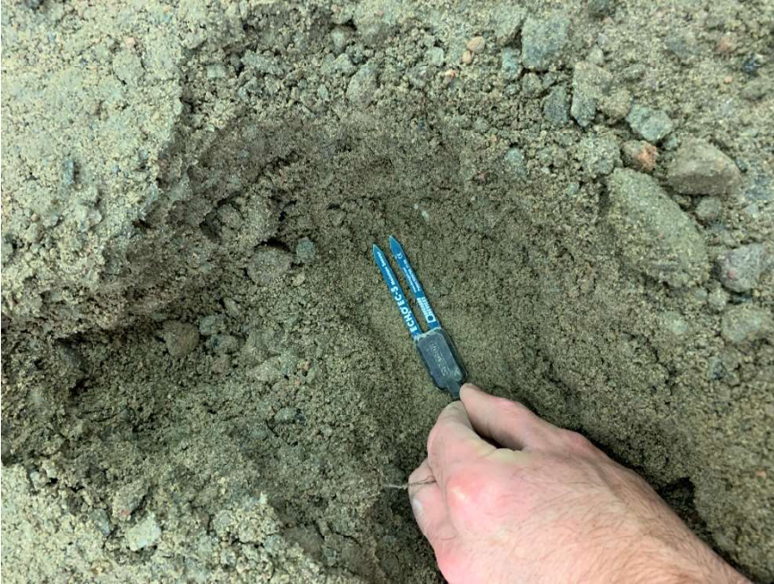
Figure 61. Installation de la sonde Decagon dans une excavation locale à la mi-couche dans la fondation
