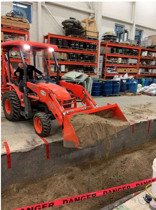
Figure 30. Remplissage de la fosse avec le tracteur hydraulique
