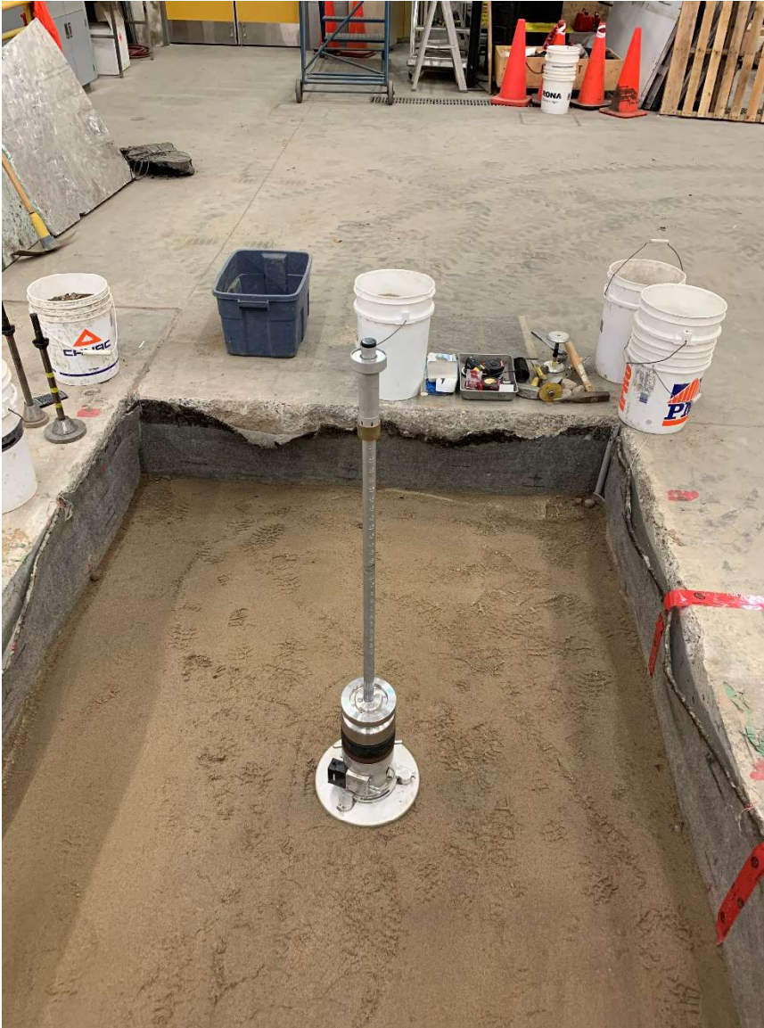
Figure 47. Essai au LWD sur les couches mises en œuvre – Exemple de la sous-fondation
