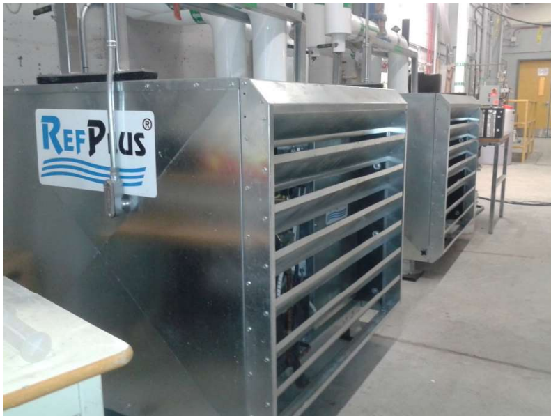
Figure 28. Unités de conditionnement thermique pour la dalle de béton au bas de la fosse
