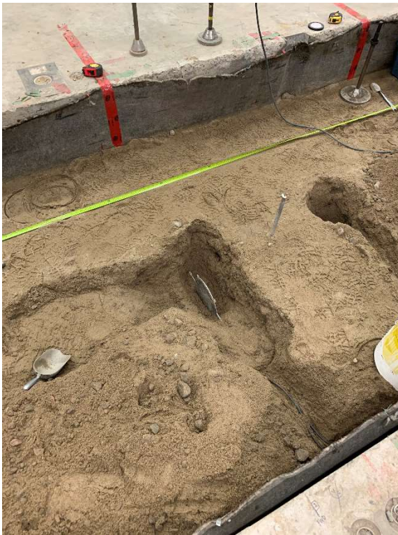
Figure 57. Excavations locales pour l'installation des cellules de contraintes
