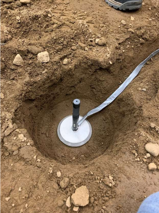
Figure 66. Excavation locale pour l'installation des capteurs de déformation
