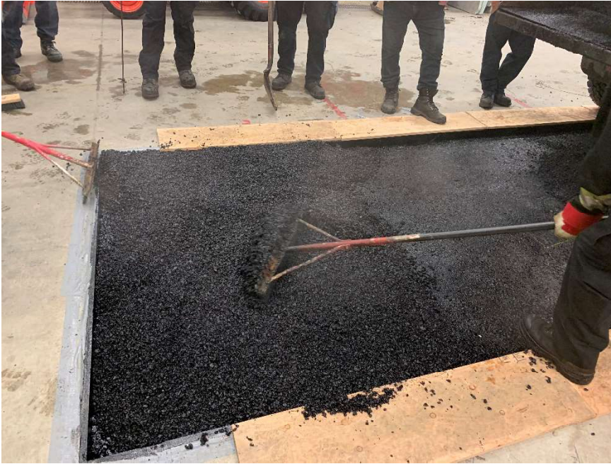
Figure 34. Épandage de l'enrobé bitumineux à la surface – Exemple de la pose du ESG10 sur le GB20
