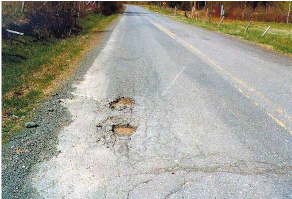
Figure 2. Nids-de-poule sur une chaussée flexible (Ministère des Transports du Québec, 2007)
