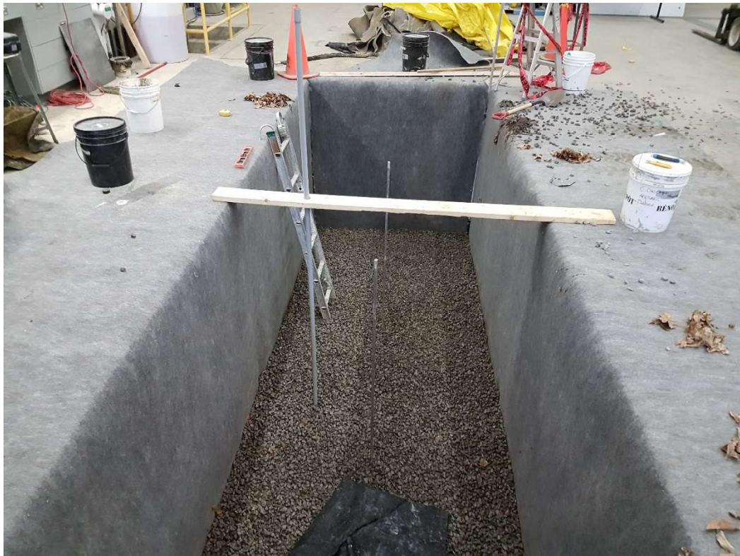
Figure 13. Utilisation de pierre nette au fond de la fosse
