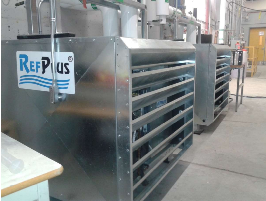
Figure 14. Unités de conditionnement thermique pour la dalle de béton au bas de la fosse
