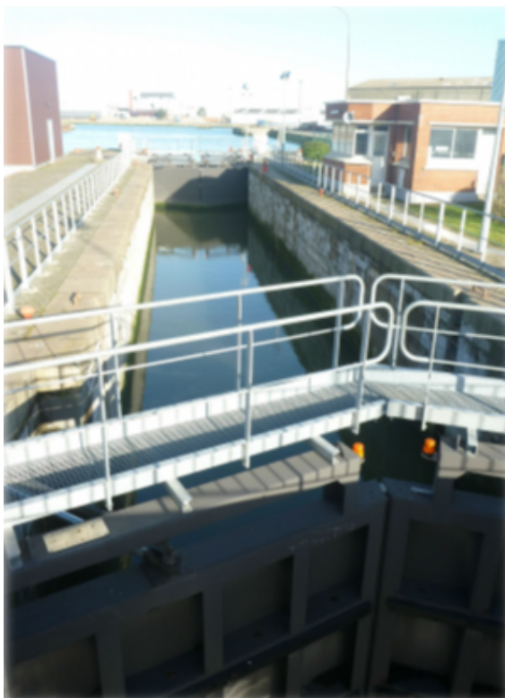
Figure 26 - Écluse de la Batellerie - Calais (source : Cerema)
