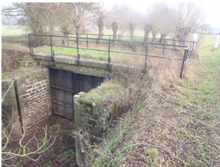
Figure 19 - Digue de Chalonnes-sur-Loire (source : Cerema)
