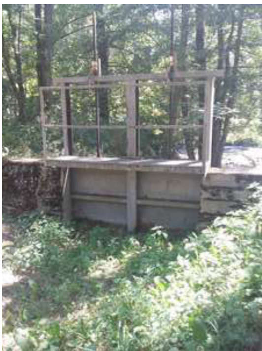
Figure 17 - Digue de Savignac sur l'Ariège (source : Cerema)
